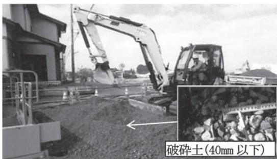
図-7 OSJ工法による埋戻状況
