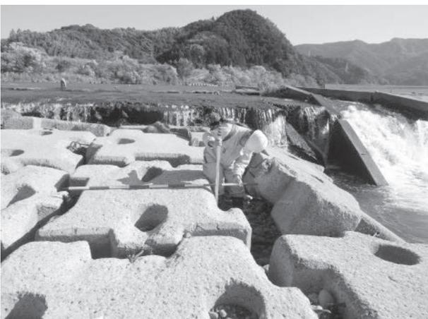
写真-4 根固めブロック（下流エプロン）の損傷状況
