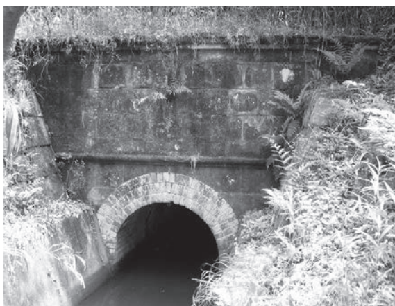
写真－５ 淡河川疏水のれんがトンネル
