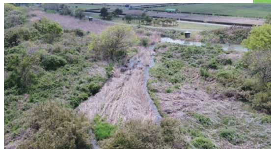
⑥ ドローン撮影 (立ち入り困難施設)
