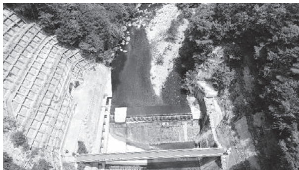
写真-8 法面工事の仮設計画のための状況写真
