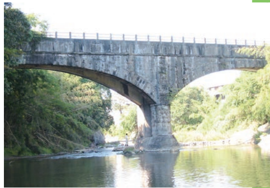
② 御坂サイホン水路橋
