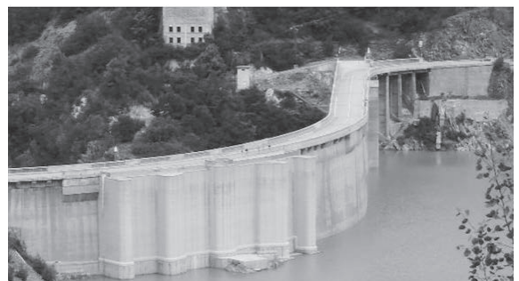
図-3 ジオメンブレンが使用されて16年後のChambonダム
