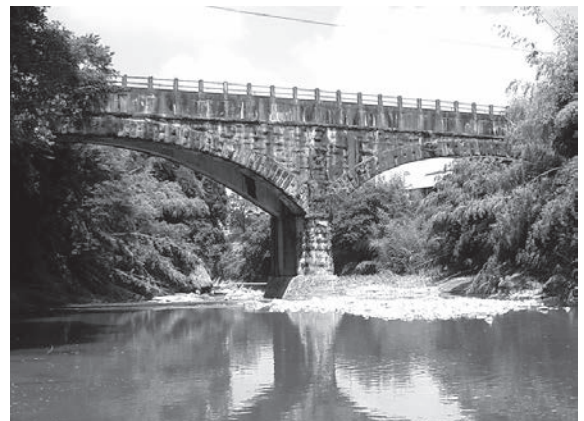
写真－3 御坂サイフォン水路橋
