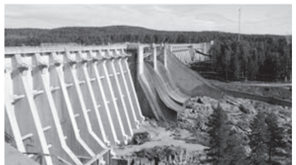
図-6 Storfinnfosenコンクリートバットレスダム
