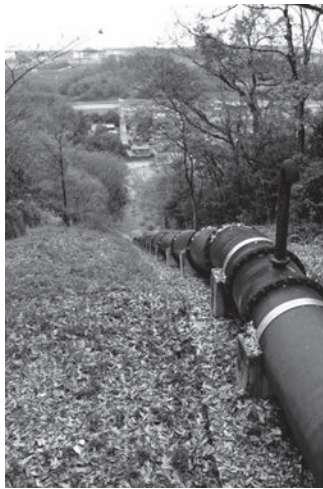
写真－４ 御坂サイフォン露出管
