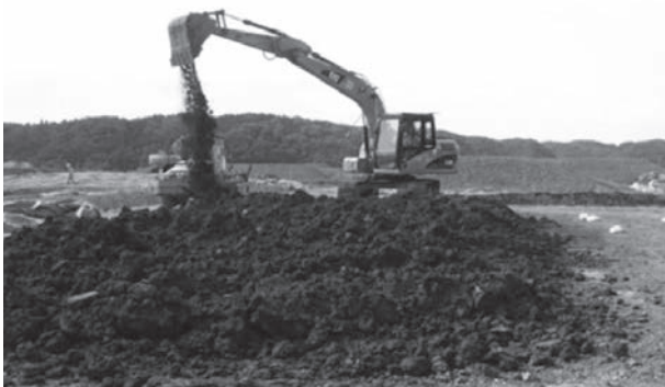
写真-11 コア細粒材（粘土）単独材バックホウ曝気状況
