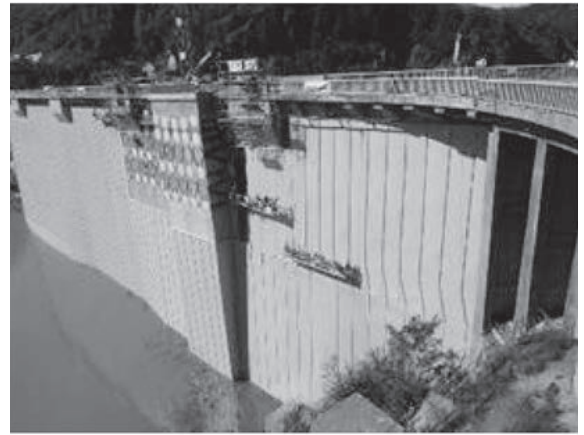
図-5 ジオメンブレンの設置状況
