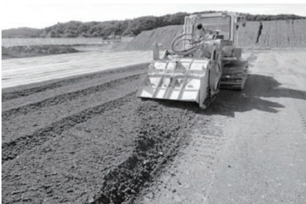
写真-12 コア細粒材と粗粒材スタビライザーによる混合状況
