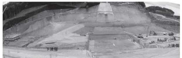
写真-10 本堤コア敷部基礎掘削完了状況
