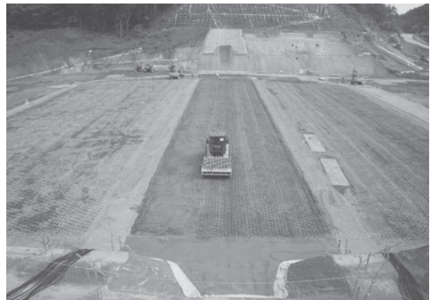
写真-14 タンピングローラコア転圧状況
