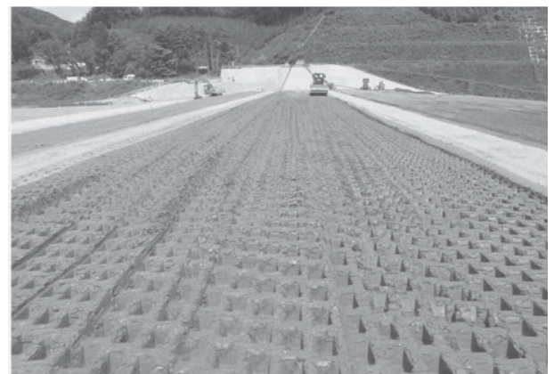
写真-15 コア転圧状況の近景
