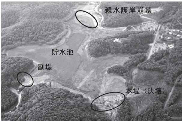
写真-4 上空から見た被災後のダム貯水池
