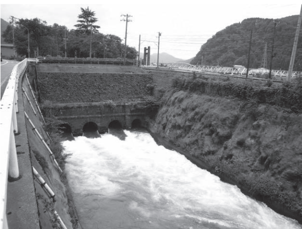
写真－1 七ヶ用水の給水口
