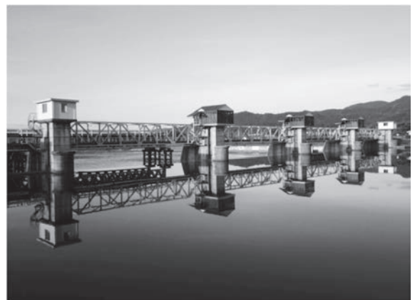
写真-8 改修工作中的の赤川頭首工
