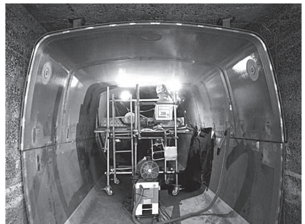
写真-1 ボックス型鋼管施工状況
