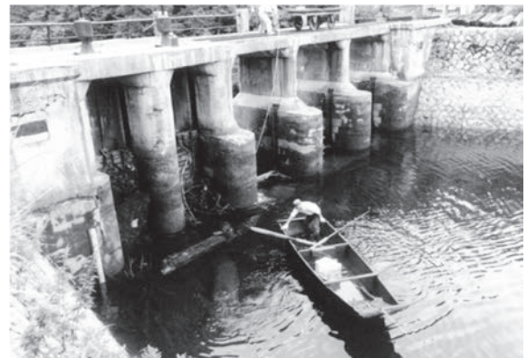
写真-9 流木除去作業（旧制水門時代）
