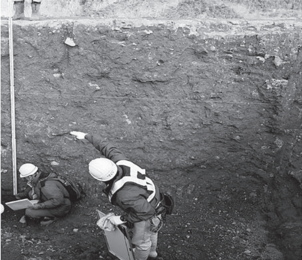
写真-10 クラック剥離面状況の確認
