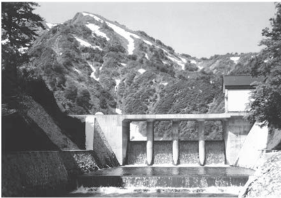
写真-7 改修後の制水門
