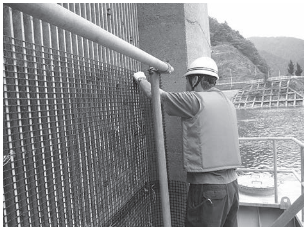
写真-4 取水口スクリーンへの樹脂ネット取付
