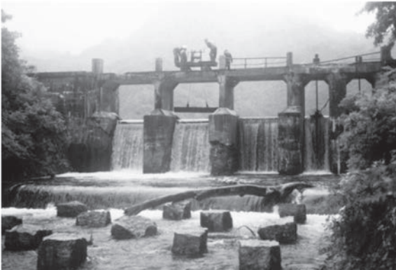
写真-4 (旧) 制水門角落し操作状況
