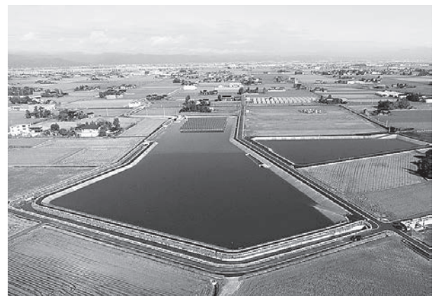
写真-4 試験貯水中の岸渡洪水調整池（平成28年11月） ※二次池側から撮影
