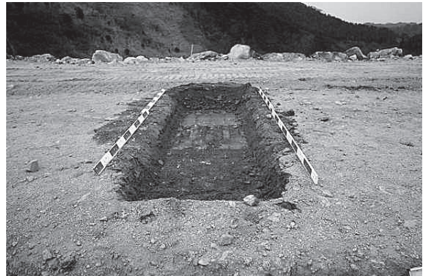
写真-3 トレンチ A タイプ掘削状況
