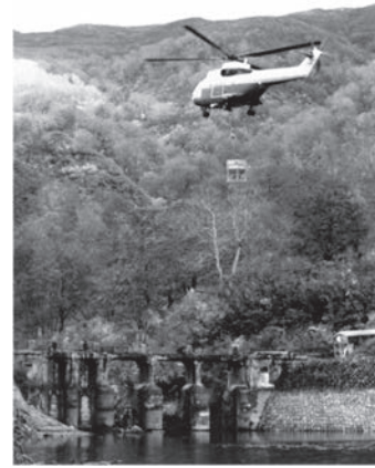
写真-5 大型ヘリによる資材運搬
