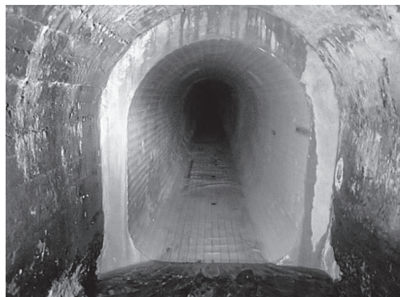
写真-4 完成イメージ (施工済み区間)
