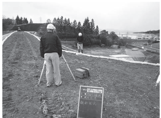
写真-6 表面変位量観測状況
