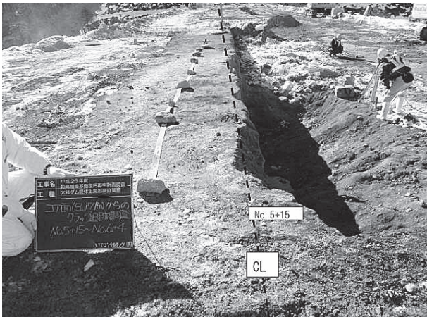
写真-6 クラック片面剥ぎ取り
