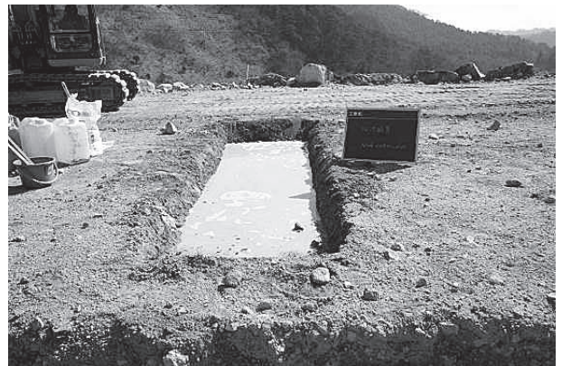
写真-4 石灰水の貯留状況
