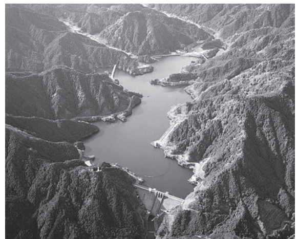
写真-1 安濃ダムと、その貯水池「錫杖湖」
