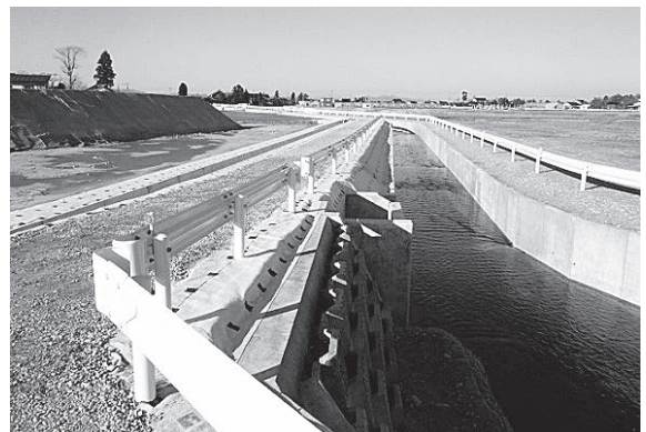
写真－2 事業の実施状況 (岸渡排水路)
