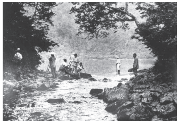
写真-2 制水門築造前の流出口(銚子口)
