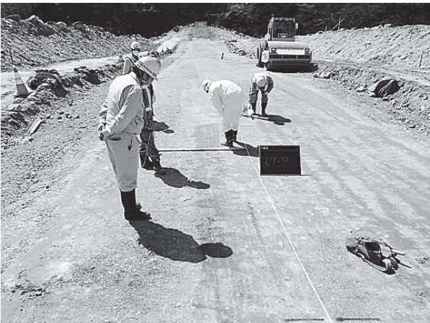
写真-11 計画撤去面のクラック確認状況 (クラック無し)
