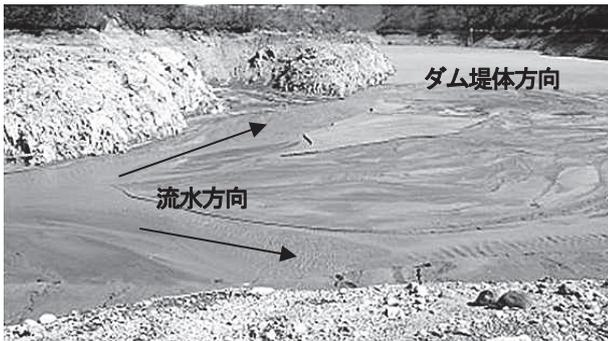
写真-5 貯水池堆積物浸食状況 (平成28年3月)
