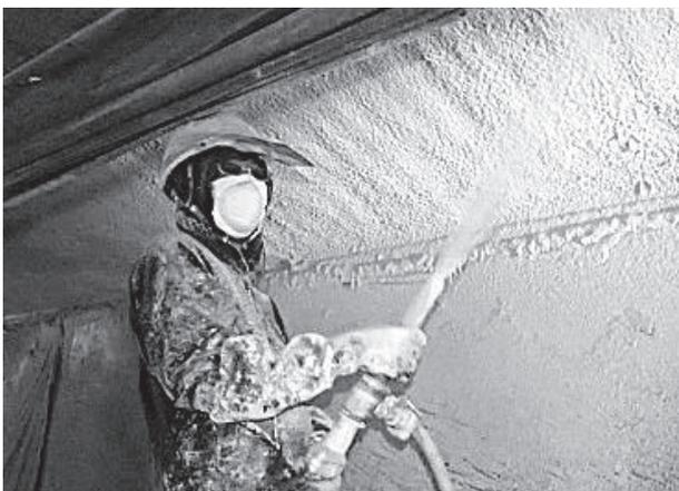
写真-2 吹き付け作業状況
