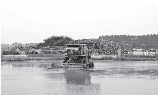
写真－6 復旧状況（瓦礫除去後の除塩作業）
