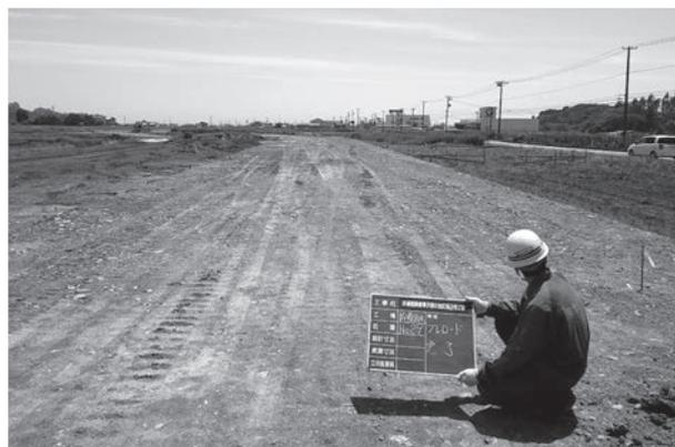
写真-8 プレロード施工の完了状況
