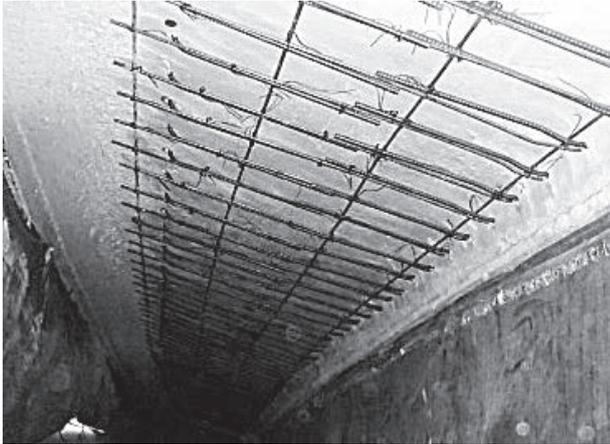
写真-1 補強鉄筋配筋状況
