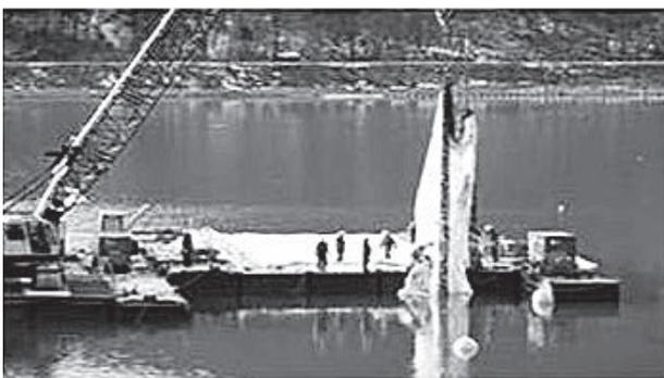
写真-3 沈下式汚濁防止フェンス
