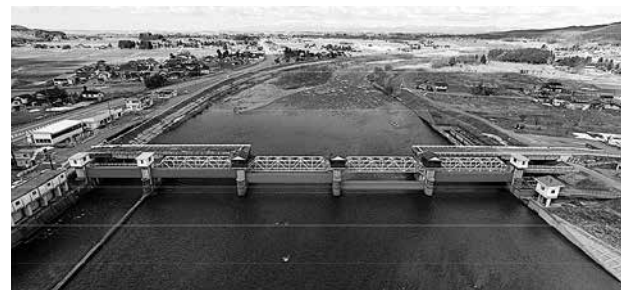
写真－1 赤川頭首工 全景（手前が上流側）
