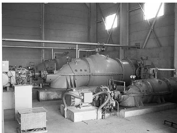
写真-2 旧本郷排水機場ポンプ室
