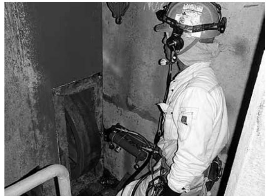
写真-12 油圧ジャッキ（30t）による作業状況
