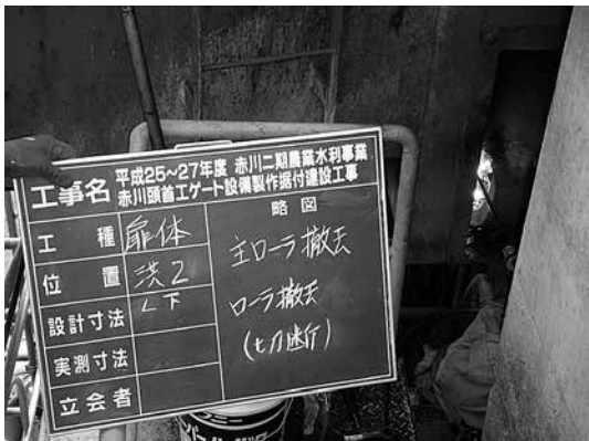
写真-15 スーパーランス工法によるローラ切断状況
