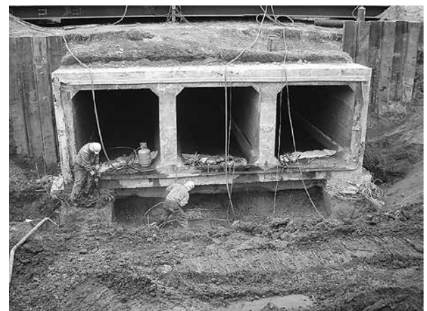
写真-7 人力はつり状況（既設利用の樋函）
