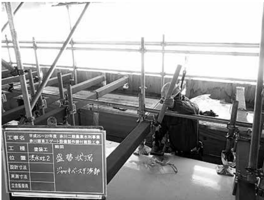
写真-3 未塗装部のジャッキ取り外し
