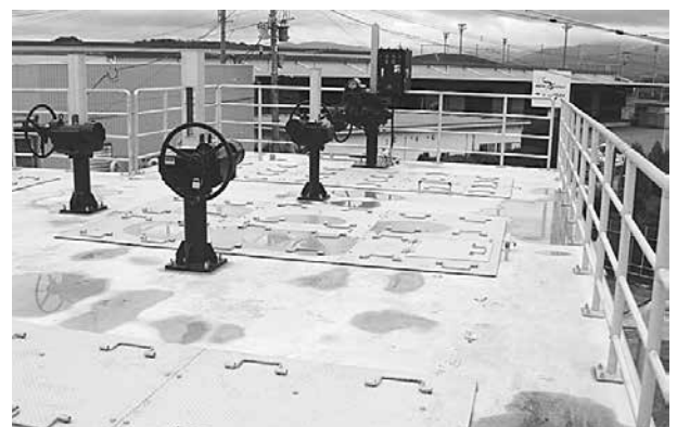
写真-2 鋼製防音蓋の設置状況
