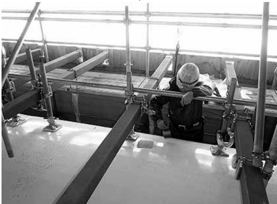
写真-5 未塗装箇所の塗装実施
