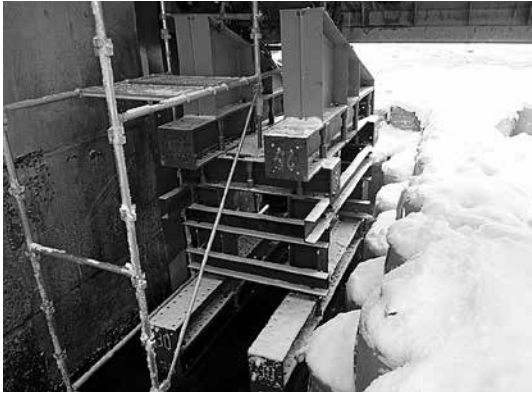
写真-9 ベンド設置状況
