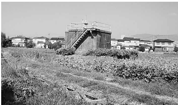
写真-1 改築前のスタンド分水工
