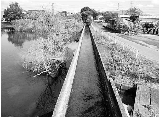
写真-5 青池隣接部の状況（整備前）
