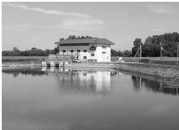
写真-1 旧本郷排水機場
