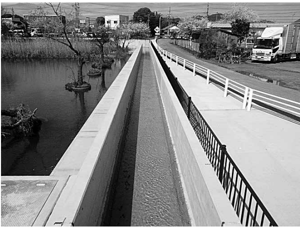
写真-6 青池隣接部の状況（整備後）
