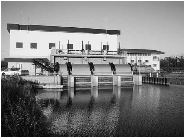
写真-4 新設本郷排水機場外観 (奥側右は旧本郷排水機場)
