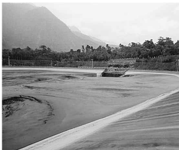
図-5 浚渫機の(a)実施前および(b)実施後1か月における貯水池の土砂
