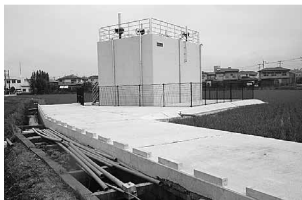
写真-7 写真-1のスタンド分水工の改築後
