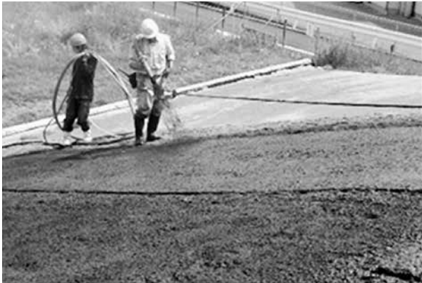
写真-4 施工状況
