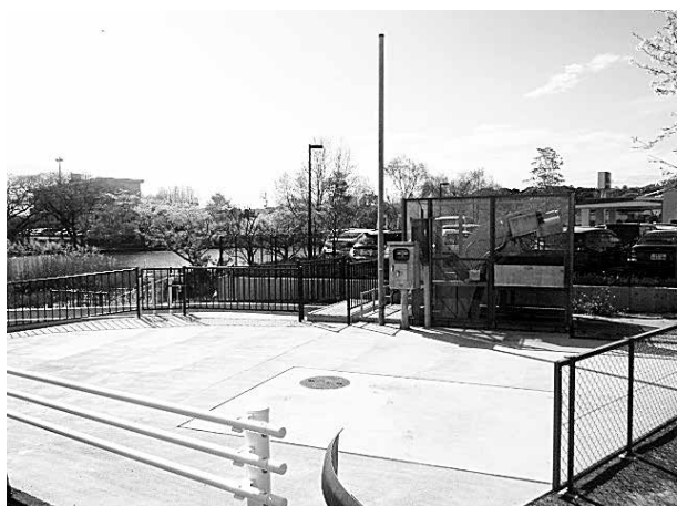
写真-4 除塵機周辺の状況（整備後）
