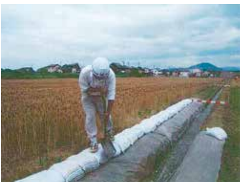
⑤復旧状況1 (水路の復旧)
