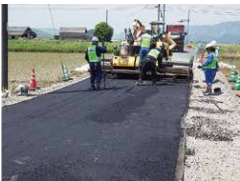
⑥復旧状況2 (農道の復旧)
