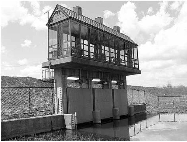
写真-3 現況の本郷樋門
