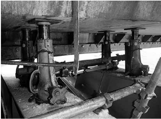
写真-10 扉体仮置き状況
