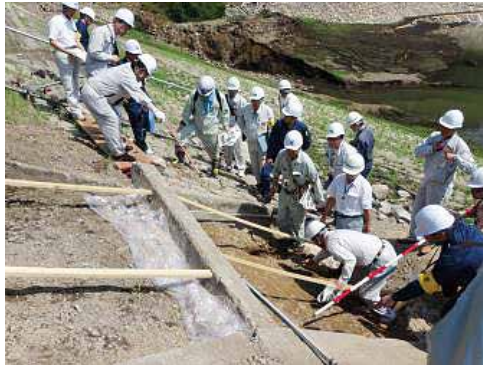
④調査状況2 (ため池堤体法面の被災状況調査)
