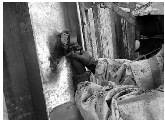
写真-7 素地調整実施状況
