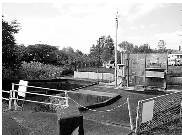
写真-3 除塵機周辺の状況（整備前）
