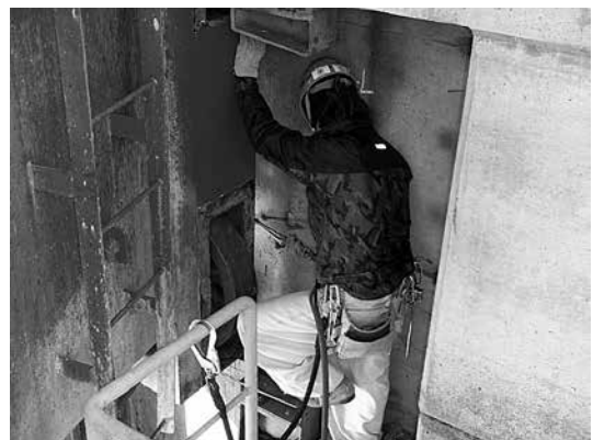
写真-13 ローラ軸加熱状況
