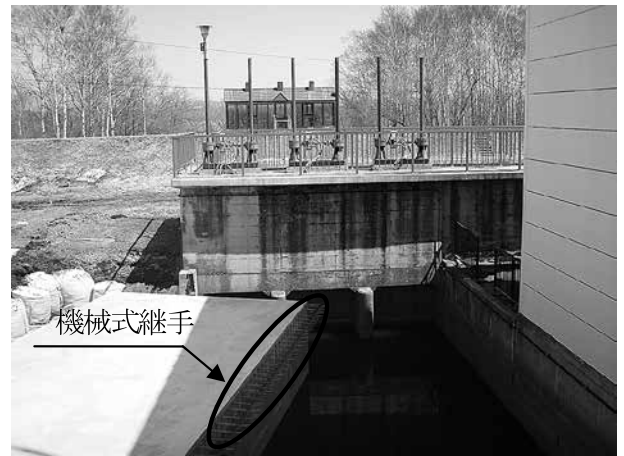
写真-6 1年目工事完了 (接続函渠より旧吐水槽及び本郷樋門を望む)
