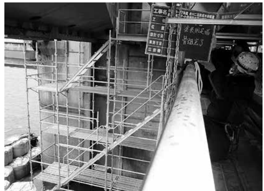
写真-6 戸当り施工時の足場構造
