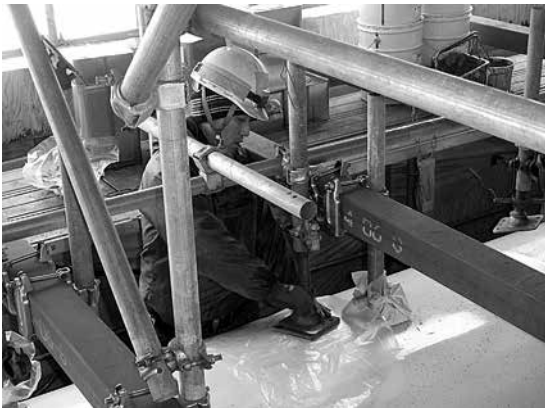
写真-4 盛り替え用ジャッキ設置
