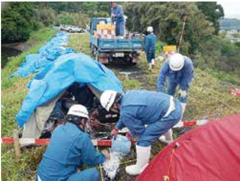
③調査状況1 (電気探査による亀裂深調査)
