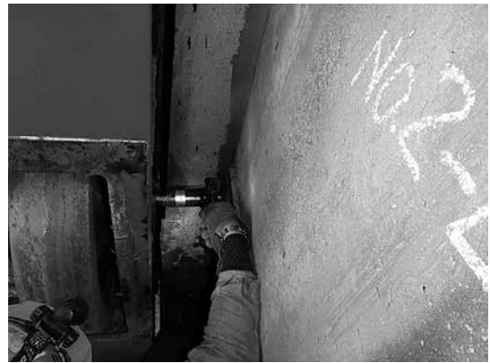
写真-11 油圧ジャッキ（2t）による作業状況
