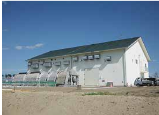
② 東日本大震災から5年（復旧した排水機場）
