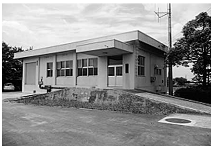
写真-1 東部幹線揚水機場
