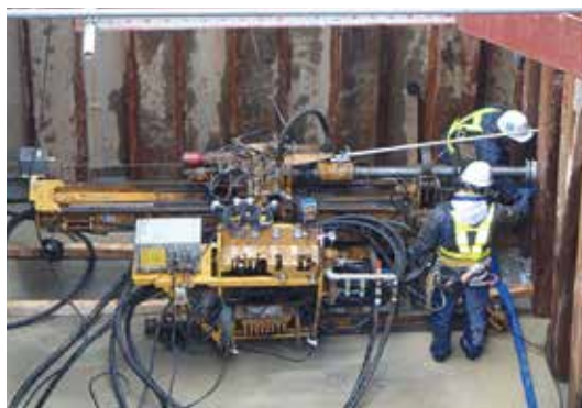
⑥ ロータリーパーカッションによる削孔状況
