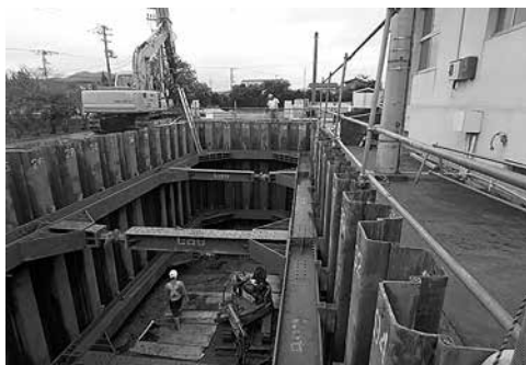
写真-2 立坑設置状況
