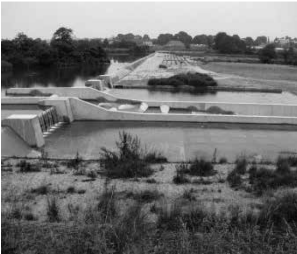
写真－6 頭首工（日野用水）
