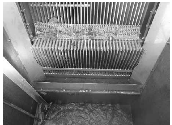
写真-9 除塵機のスクリーン (改修後)
