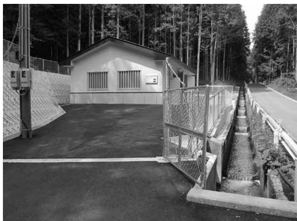
写真-1 発電所建屋と小郷用水路
