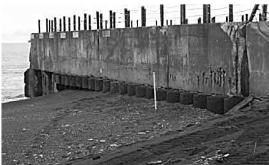
写真-2 開渠工河口部全景
