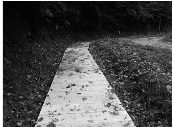
写真-7 水路に設置した蓋
