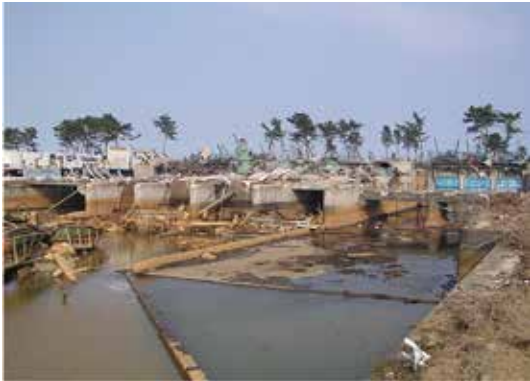
① 東日本大震災から5年（被災直後の排水機場）
