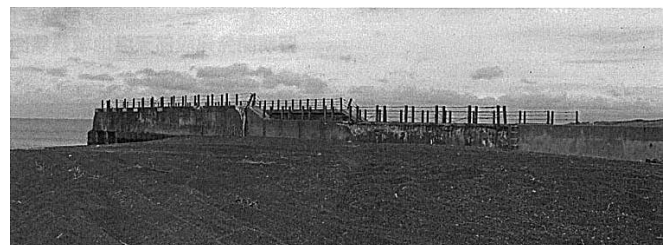
写真-1 開渠工全景
