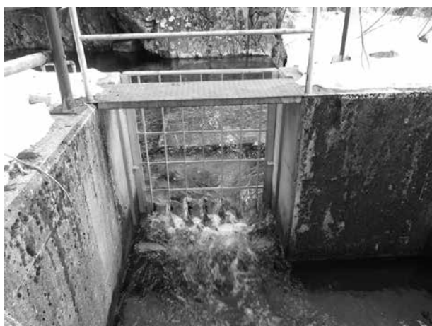
写真-11 頭首工スクリーン（改修後）
