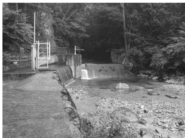
写真-2 小郷用水頭首工
