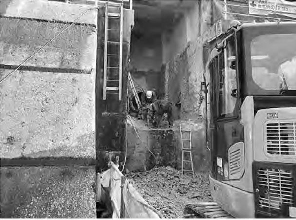
写真-2 放流バルブの既設コンクリート破碎状況
