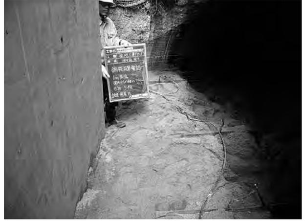
左側のコンクリート壁は、発電所機場下部の放水庭。右側は埋戻を行う水路トンネルで、埋戻し時に1m間隔で銅版を設置して接地(アース)工事を施工した。
