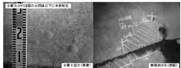
写真-3 3号水路橋 水膨れ拡大、新たな浮き
