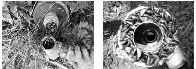
写真-2 給水栓、ストレーナーの閉塞
