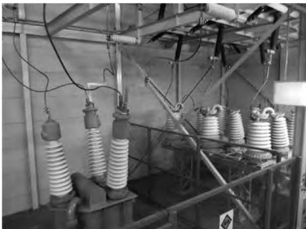
写真-6 特別高圧受変電設備の現状
