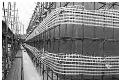
【ひび割れ抑制工法】
