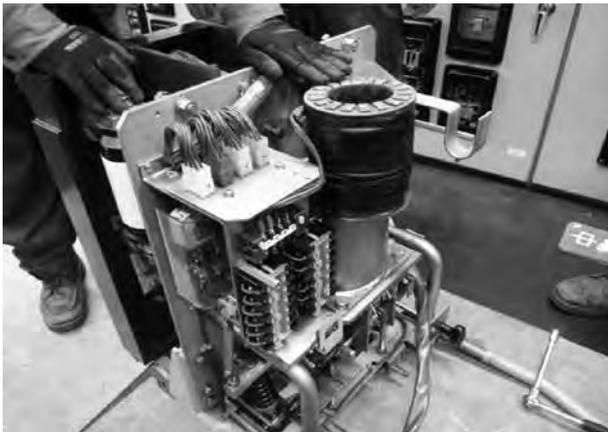
写真-1 高圧配電設備の真空遮断機
