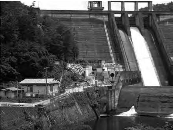
発電に必要な取水のための主放水バルブ移設、取水管及び水圧管の設置や発電所機場下部の工事が完了。
