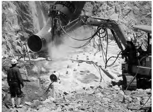
クローラードリルにより削孔後、薬剤と電導線が内蔵された薬筒を挿入し、点火機から高電流を通電させて燃焼波により岩盤を破碎
