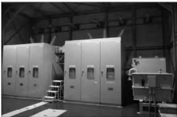
写真-7 特別高圧受変電設備の完成後のイメージ(他施設)
