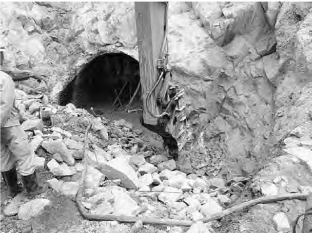
水路トンネルは、上流からダム堤体まではコンクリートにより閉塞されていた。閉塞していない発電所建設予定地は、湧水があるため水替しながら掘削を行った。
