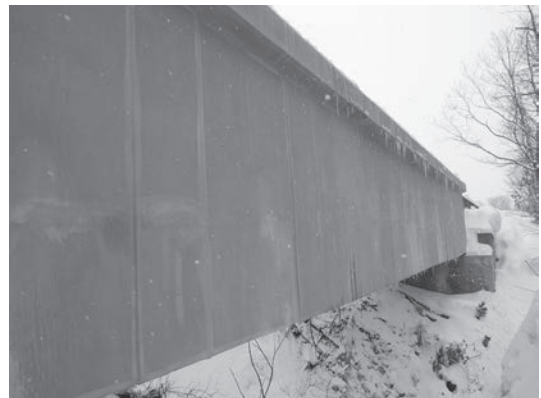
② 施工後 (外面)
