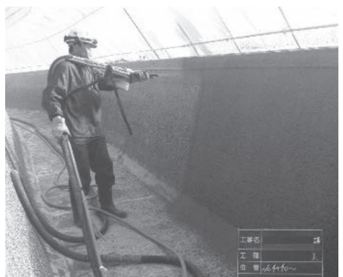
写真-3 表面被覆工の施工状況
