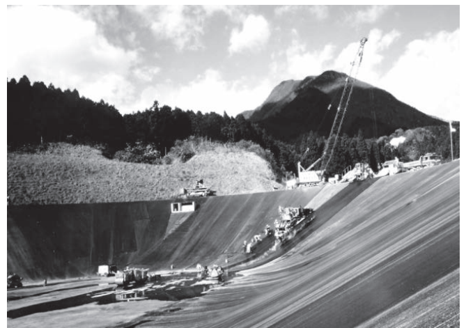
写真-1 アスファルトライニング(建設時)
