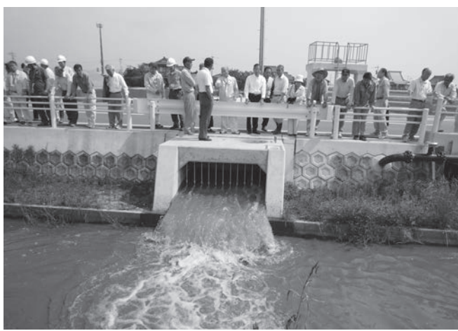
写真-9 平成24年 嘉瀬川ダムからの初めての導水
