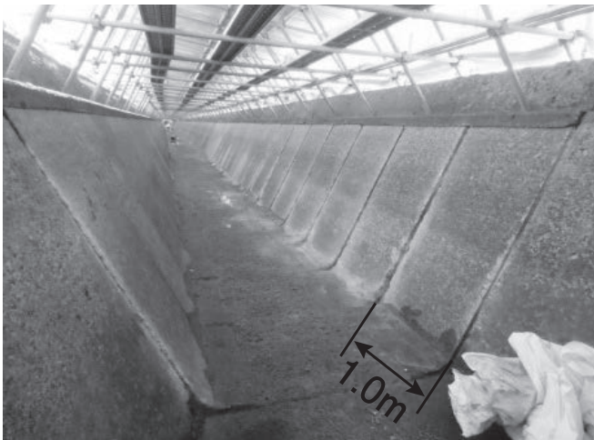
写真-2 L形ブロック現況
