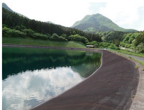
③ アスファルトライニング（供用時）
