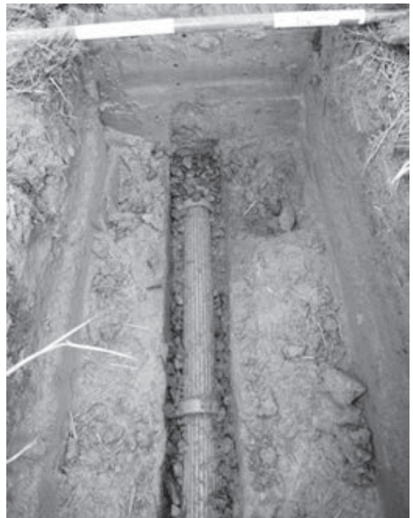
写真-2 既設暗渠排水試掘調査状況
