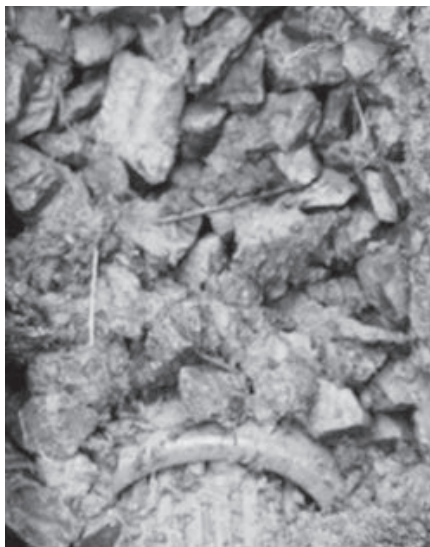
写真-4 碎石（金気による変色なし）
