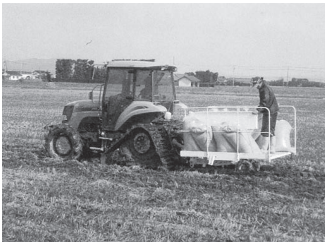
写真-1 モミサブローによる補助暗渠施工状況(直江地区)
