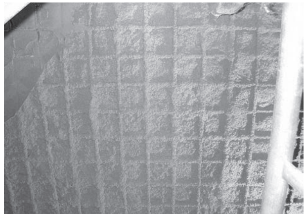
写真-5 PCM吹き付け
