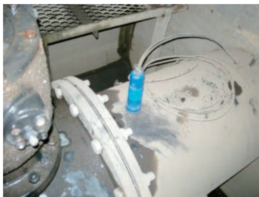
② 漏水音の測定状況
