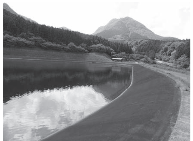
写真-2 アスファルトライニング(供用時)
