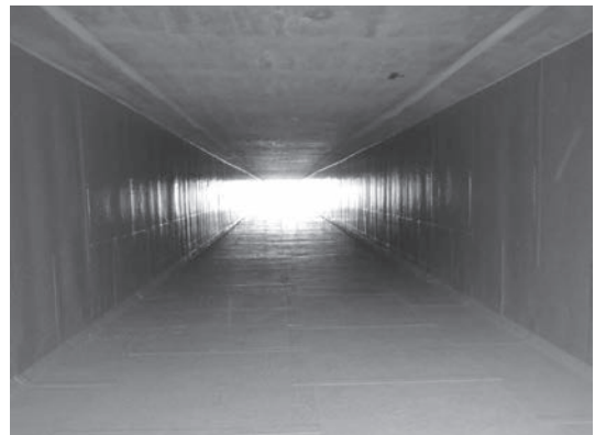
④ 施工後 (内面)
