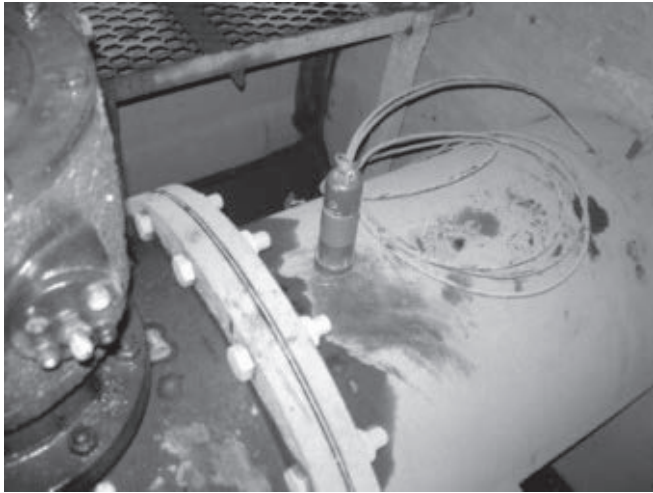
写真-1 漏水音の測定状況
