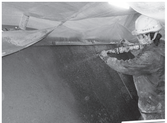
写真-3 表面被覆の施工状況
