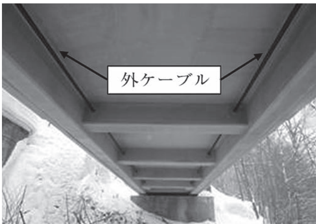
写真-3 外ケーブル完了
