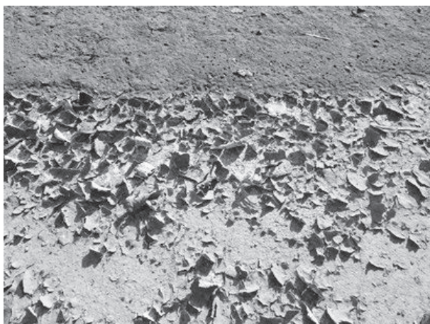
写真-9 マッドカーリング現象
