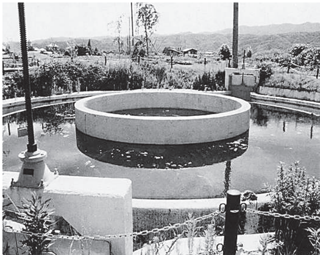
写真-3 大山大鳥居円筒分水工
