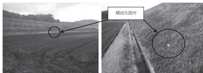
写真-5-1 法面からの横流失状況（試験ほ場）
