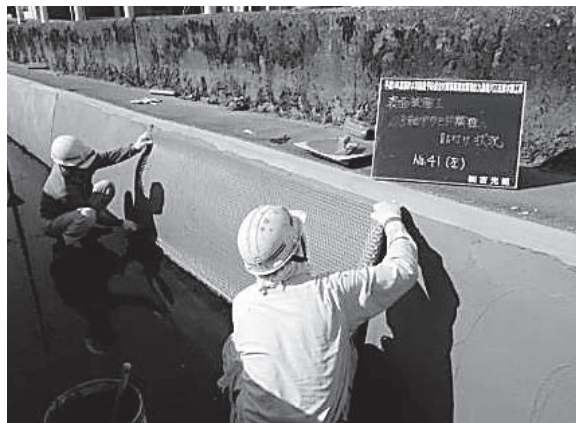
写真-4 メッシュシート貼付状況
