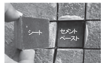
写真-14 B工法門柱部
