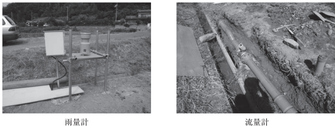
写真-5-3 試験ほ場における観測施設の設置状況
