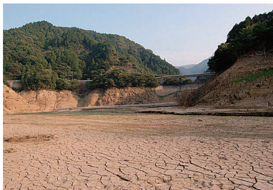
④ 貯水地内堆砂状況
