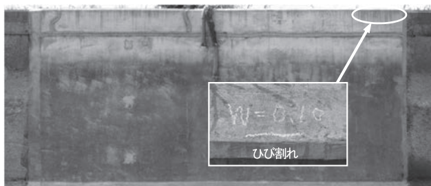
写真-3 A工法の用水路側壁面
