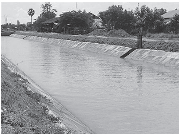
写真-9 改修後の水路の通水状況 (2014.8)
