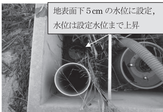
取水側の水位設定 (用水供給弁：地表面下5cm) 写真-5-4 水位の設定状況
