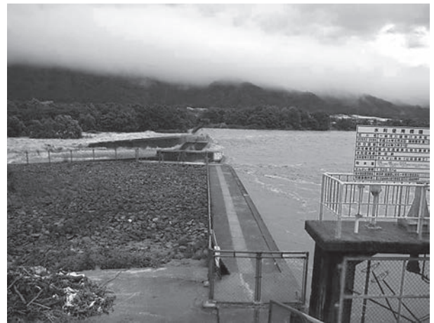
写真－1 山田頭首工被害状況写真 (左岸から右岸へ望む撮影)
