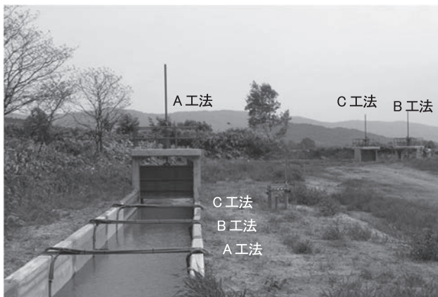
写真-2 表面被覆工法の施工状況
