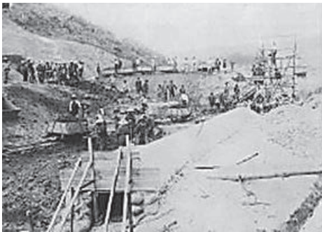
写真-1 当時のため池工事の様子（1922年頃）
