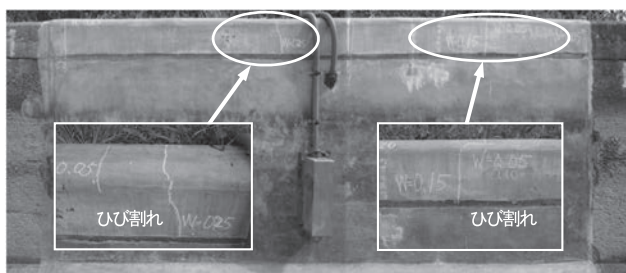
写真-4 B工法の用水路側壁面
