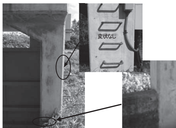
写真-6 A工法の門柱の状態
