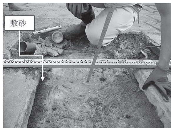
写真-5 健全パネル背面の状況
