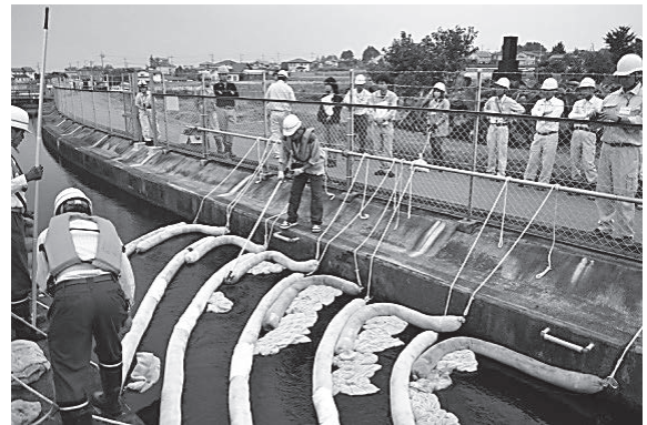
写真-5 オイルフェンス設置状況 (水質事故対応訓練時)
