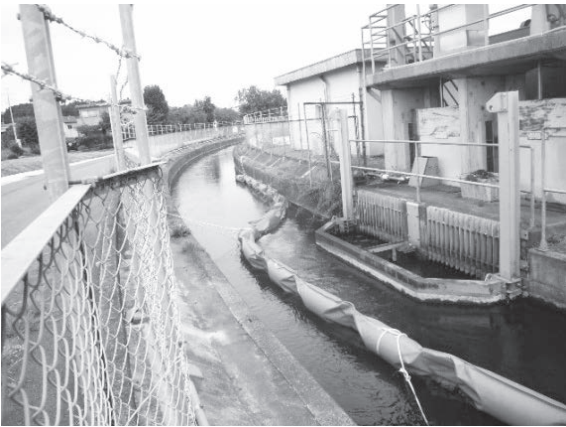
写真-7 オイルフェンス設置状況 (分水口前)
