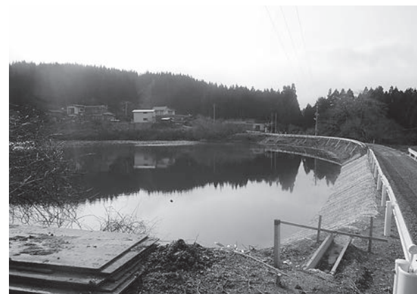
写真－5 復旧後の男鹿市真山地区
