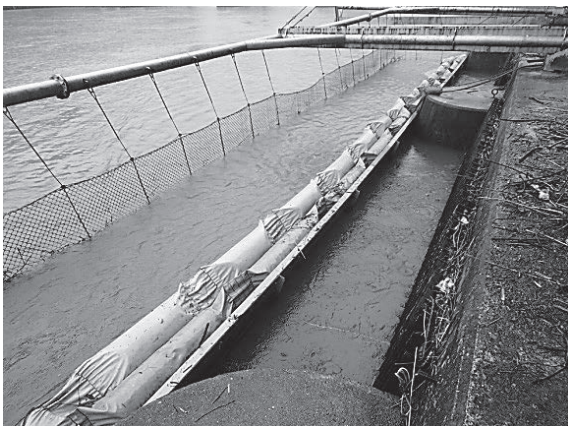
写真-4 取水口オイルフェンス設置状況
