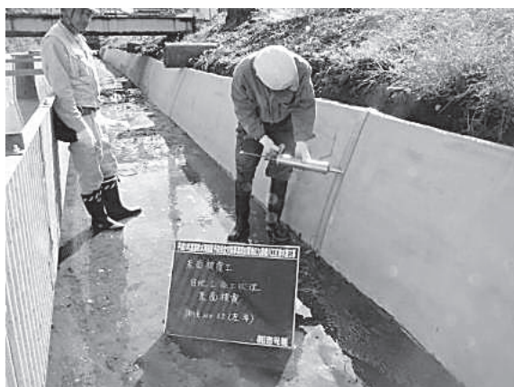
写真-6 目地注入状況
