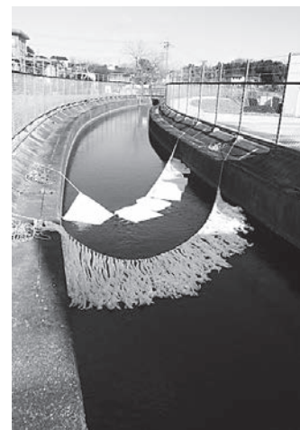
写真-6 オイルフェンス設置状況 (吹き流しタイプ)
