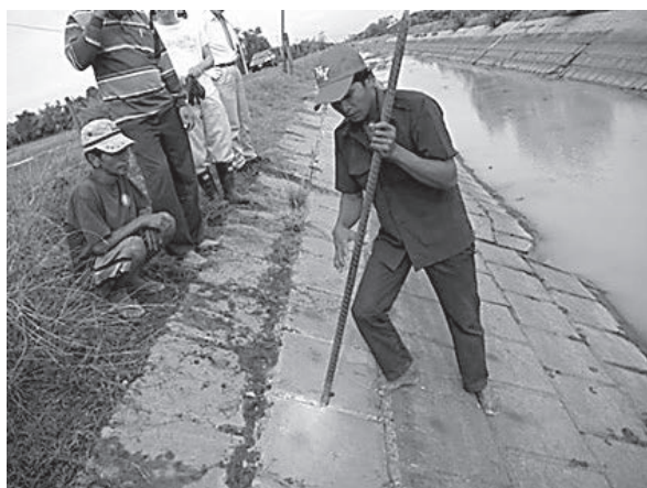
写真-4 パネルを外す前の状況
