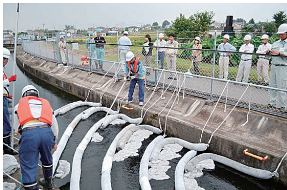
① オイルフェンス設置状況（水質事故対応訓練時）
