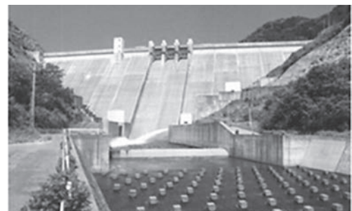
写真-1 安濃ダム
