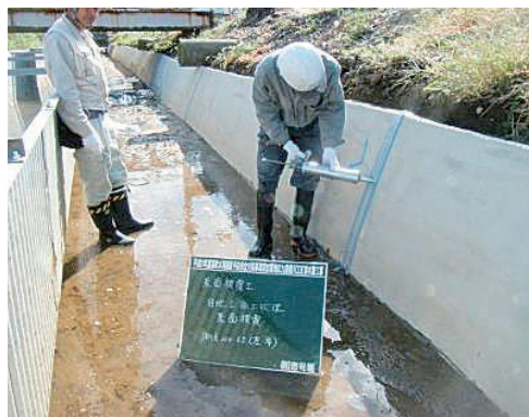
③ 目地注入状況
