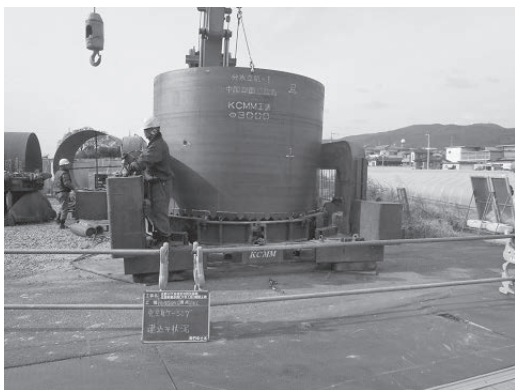
写真-1 ケーシング建込み(ケコム工法)
