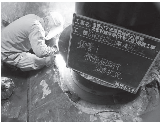
写真-7 分岐部補強板取付状況
