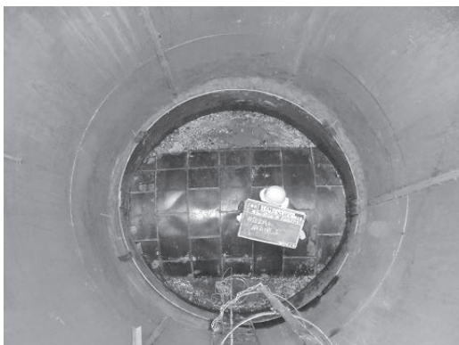
写真-3 セグメント露出状況(ケコム工法掘削完了)
