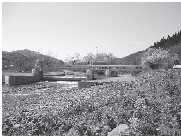
写真-7 大野川頭首工（平成24年改修）
