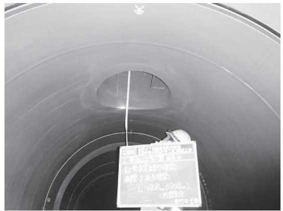
写真-10 塗装済状況 (本管内側部分)
