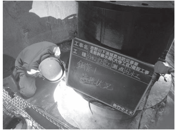
写真-6 鋼管1溶接状況
