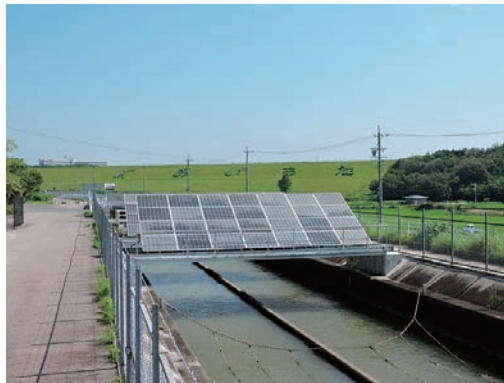
④ 水路上部空間に設置した太陽光発電 (事例2)
