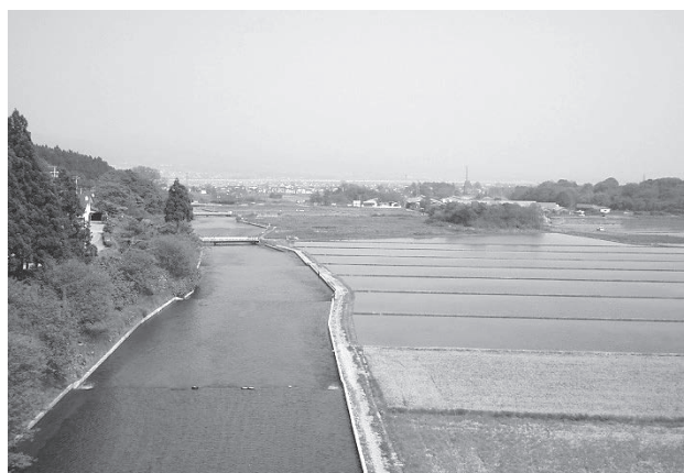
写真-8 大野川幹線用水路（広幅水路：上流からの全景）
