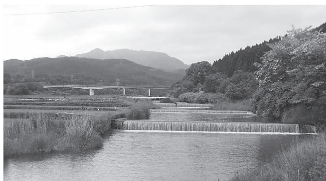
写真-9 大野川幹線用水路（広幅水路：下流からの全景）
