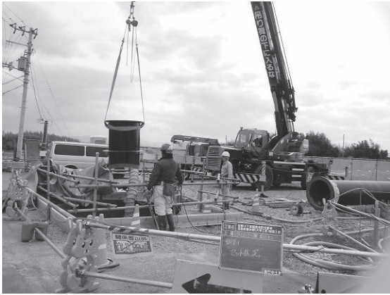
写真-5 鋼管1吊込状況
