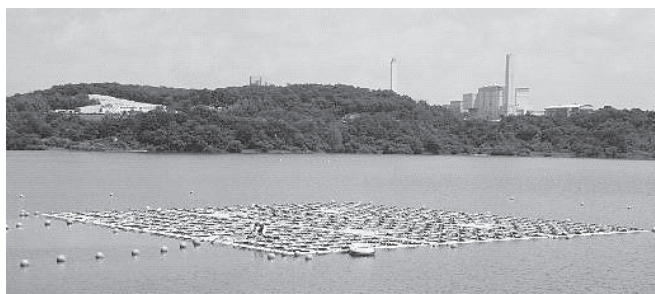
写真-2 水上浮体ユニット全景
