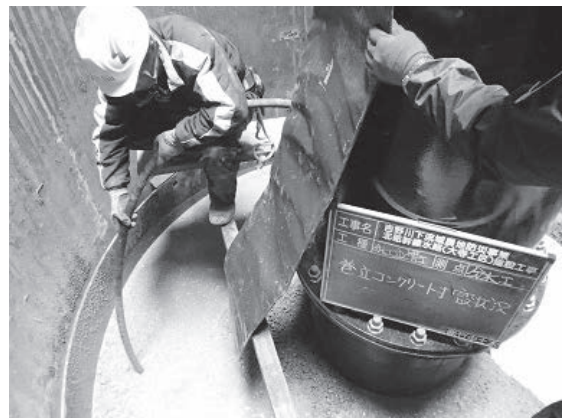
写真-12 巻立コンクリート施工状況
