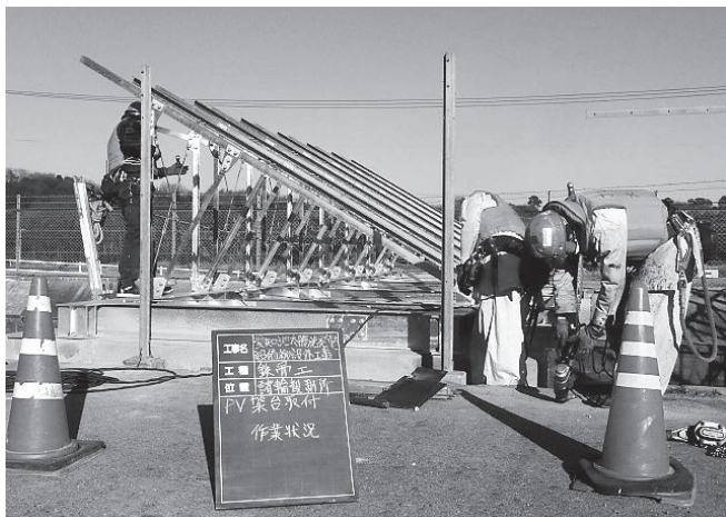
写真-4 架台設置工事中
