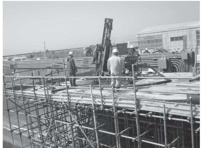
写真-1 足場上での削孔状況
