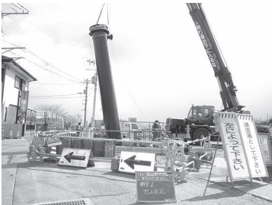
写真-11 鋼管2・3吊込状況
