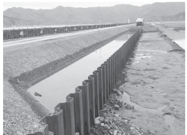
写真-4 現地の矢板の設置状況 (2013.3)
