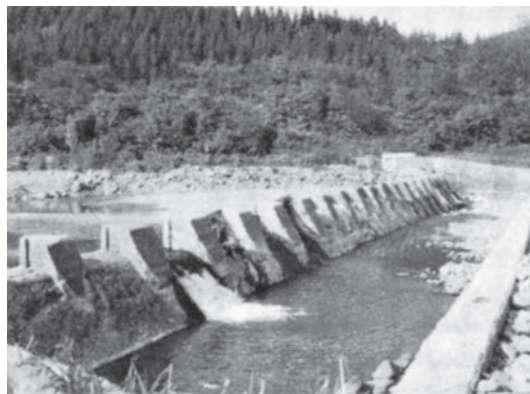
写真－5 大野川大堰 (改修前)
