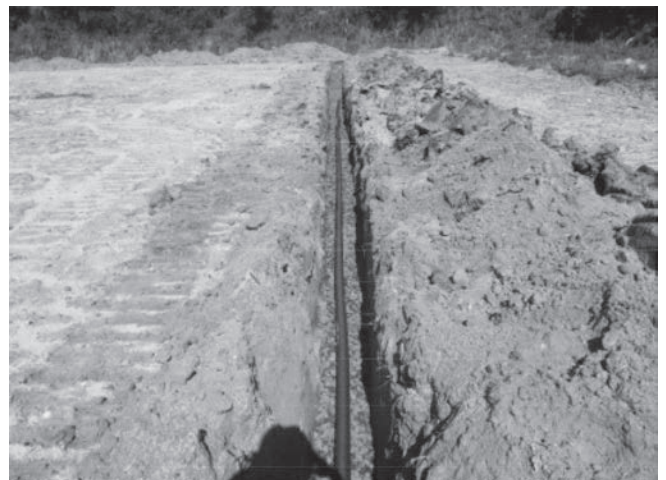
写真－9 暗渠排水
