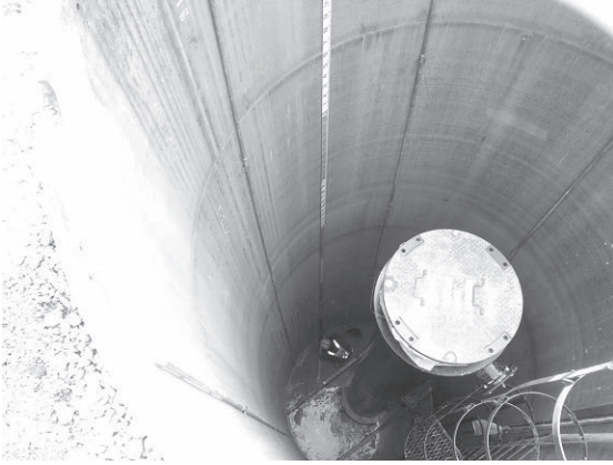
写真-13 立上管設置状況
