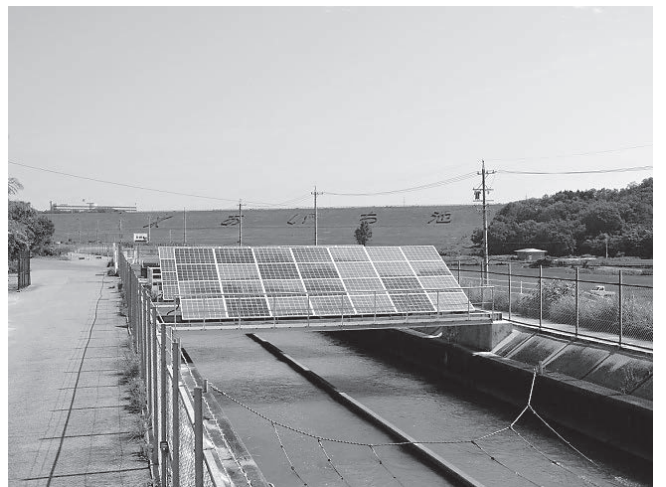
写真-6 水路上部空間に設置した太陽光発電 (事例2)
