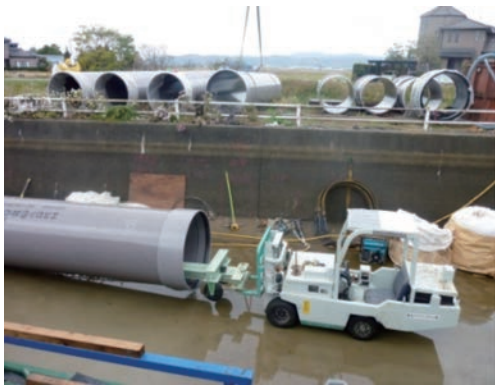
① バッテリーカーによる運搬
