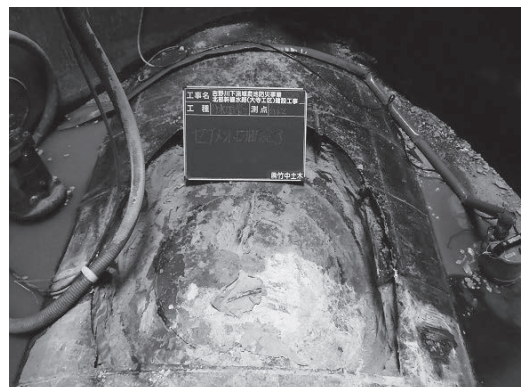
写真-4 セグメント・中込材撤去状況
