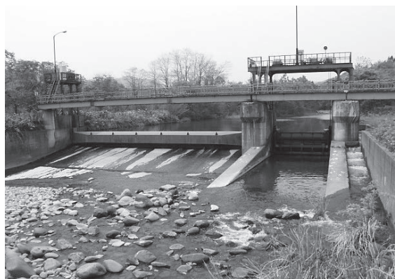
写真－6 大野川頭首工 (昭和47年完成)
