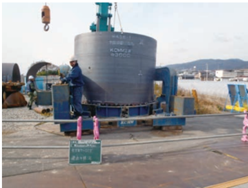
③ ケーシング建込み (ケコム工法)
