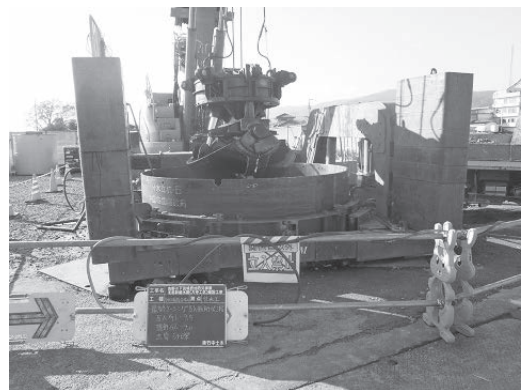
写真-2 掘削状況(ケコム工法)
