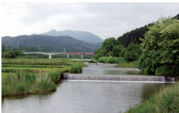
⑤ 大野川幹線用水路 (広幅水路: 下流からの全景)
