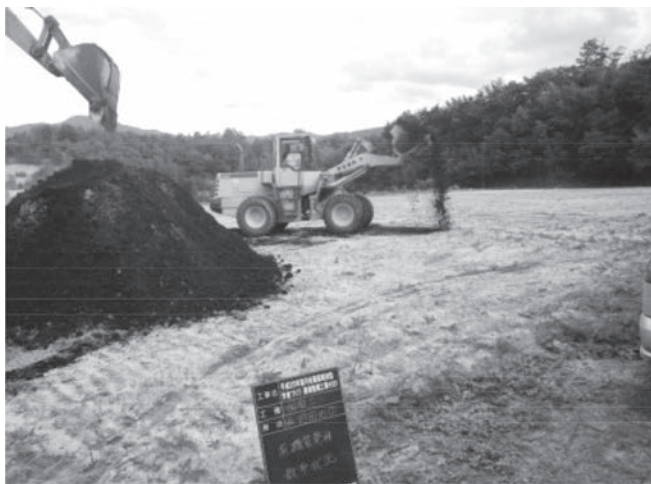
写真－7 土壌改良材（堆肥）投入
