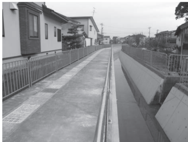
写真-7 管理用道路の様子
