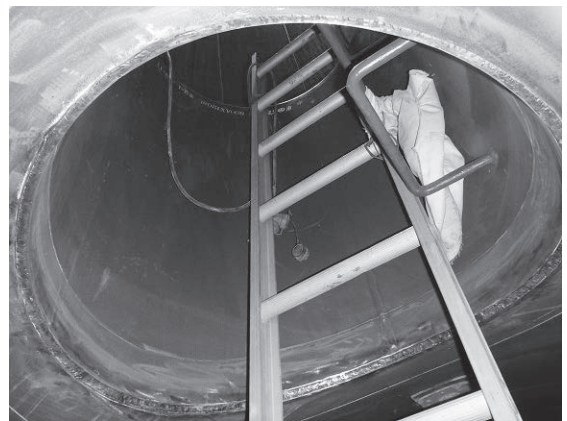
写真-8 本管分岐部溶接状況 (本管内側部分)
