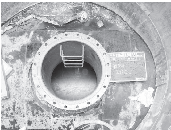
写真-9 鋼管1設置状況
