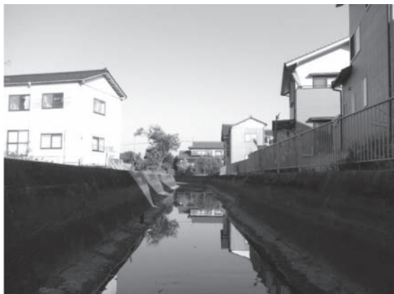
写真-1 住宅地内の現況水路
