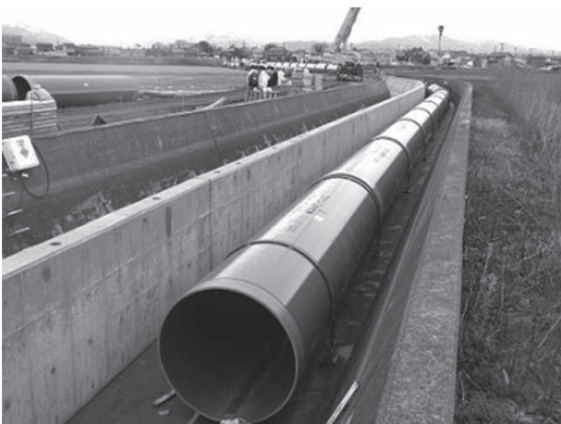
写真-5 浮上防止バンド設置状況
