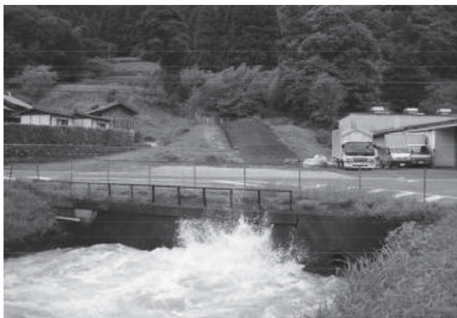
写真-1 改修前の落差工
