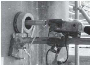
写真-6 コンクリートコアドリル
