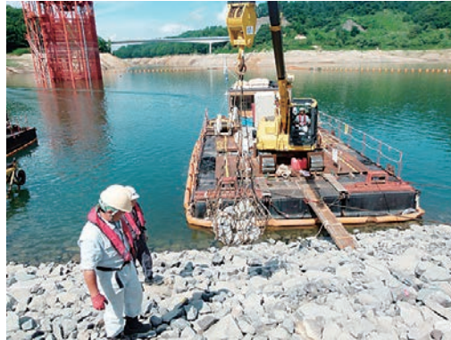
②クレーン付き台船による新材設置
