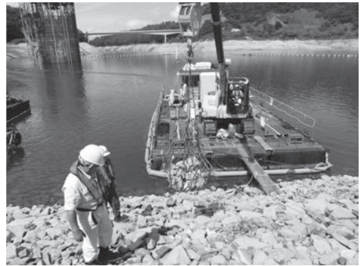
写真-1 クレーン付き台船による新材設置
