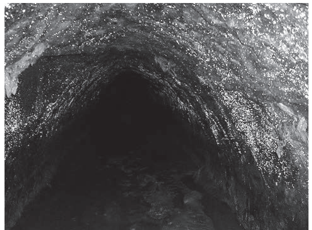
写真-1 大江用水路の隧道
