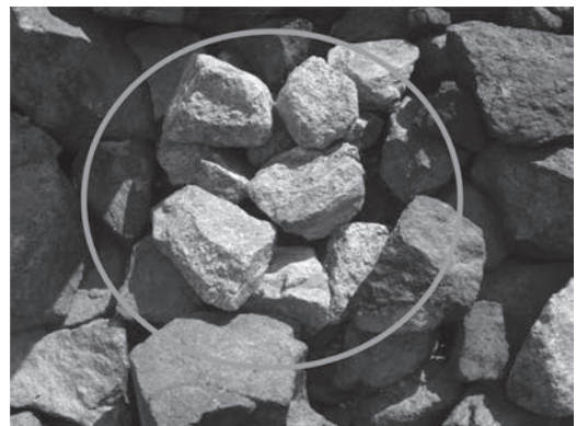
写真-2 新材設置後
