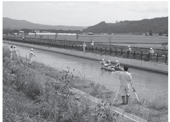
写真-1 水路底のレベル測量概況（通水時）
