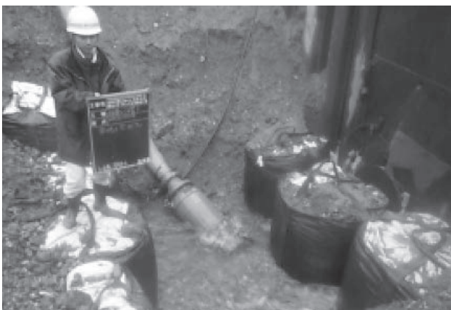
写真-6 水替え工状況
