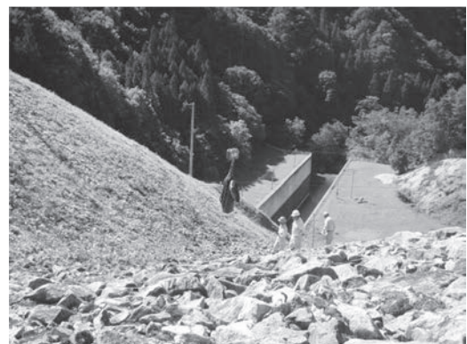
写真-4 ケーブルクレーンによる新材吊り下げ状況
