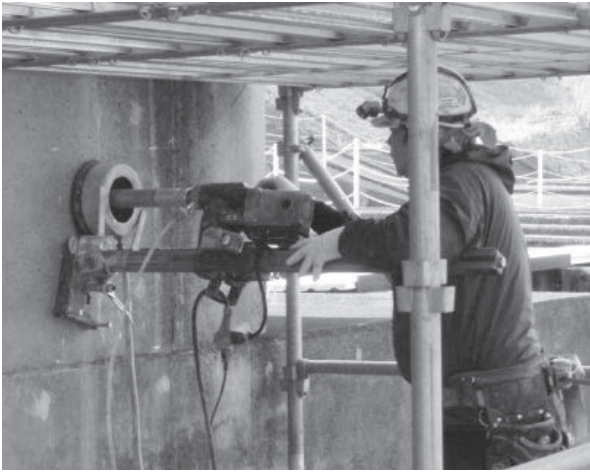
写真-8 削孔状況
