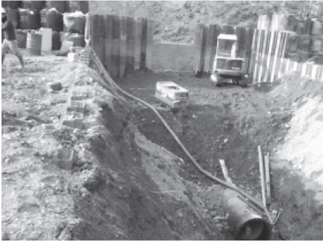
写真-4 右岸管布設
