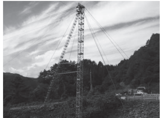
写真-3 ケーブルクレーン上部右岸鉄塔
