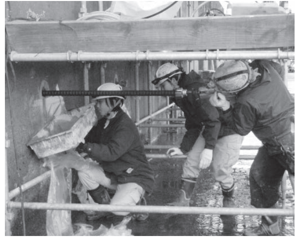
写真-10 補強鉄筋の打ち込み状況
