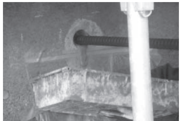
写真-11 モルタルの充填状況
