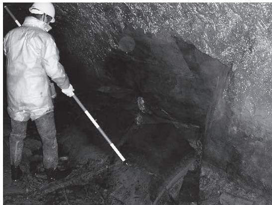
写真-6 鴉ヶ島隧道の側壁の状況
