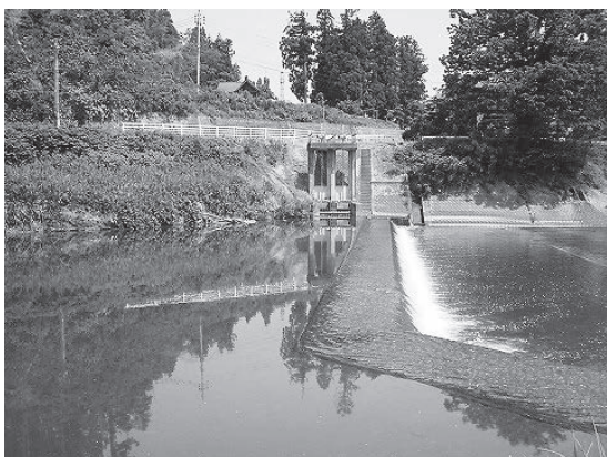
写真-2 鴉ヶ島頭首工 (L=70m)
