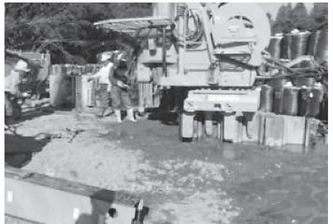
写真-2 遮水矢板打設（左岸）
