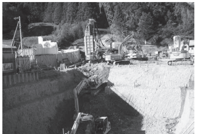
写真-6 発電室掘削状況
