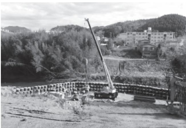
写真-1 遮水矢板打設（左岸）
