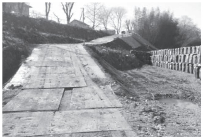
写真-3 右岸工所用道路
