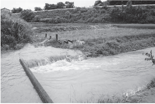
写真-7 山地からの排水流入状況 (平成25年7月30日)
