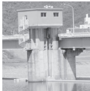
写真-3 第4堰柱 (右岸上流より)
