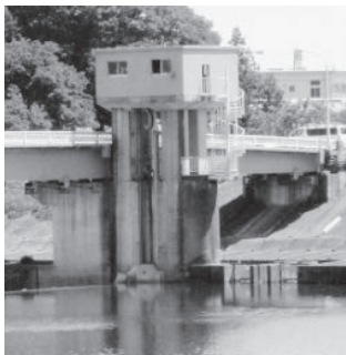
写真-2 第1堰柱 (左岸上流より)
