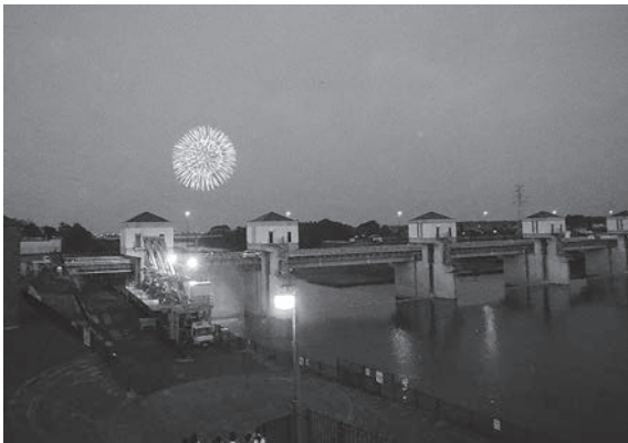
写真-7 深谷市花火大会と六堰頭首工
