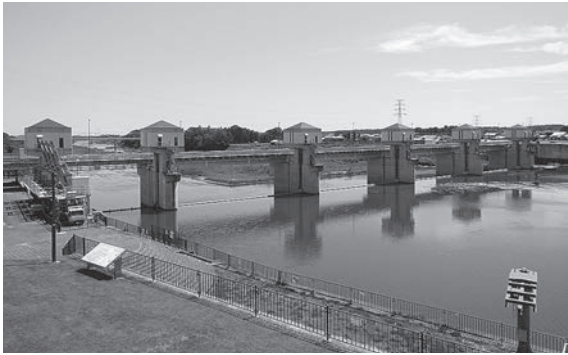
写真-3 平成15年3月に完成した新六堰頭首工
