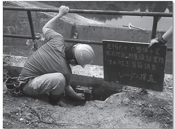
写真-4 配筋調査
