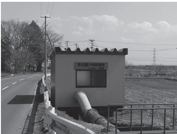
写真-9 現在の発電設備
