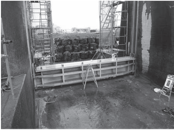
写真-7 土砂吐ゲートの設置
