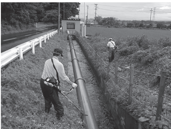
写真-10 転落防止策の設置
