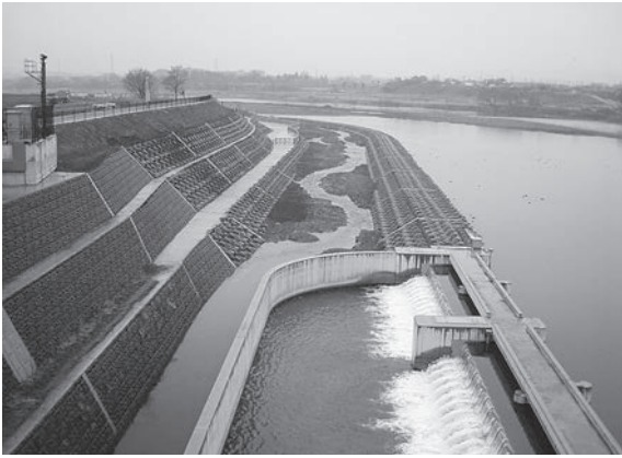
写真-6 緩勾配魚道（左），流水改善水路（右）
