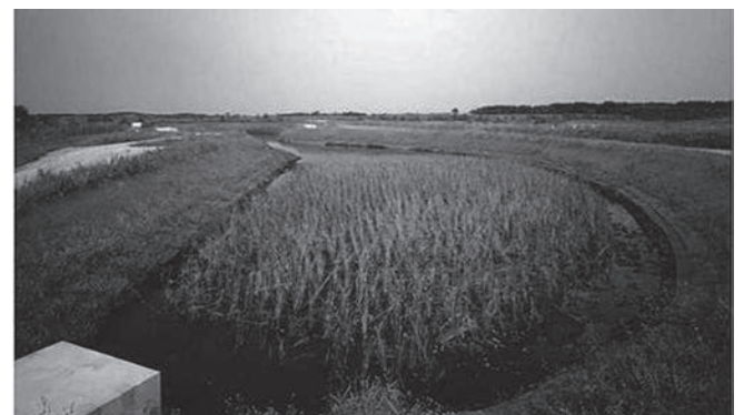
写真-6 整備された遊水池（植性域）
