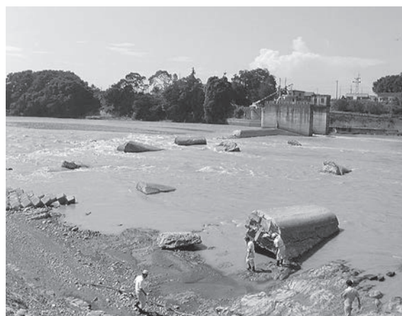
写真-2 洪水で決壊した旧六堰頭首工
