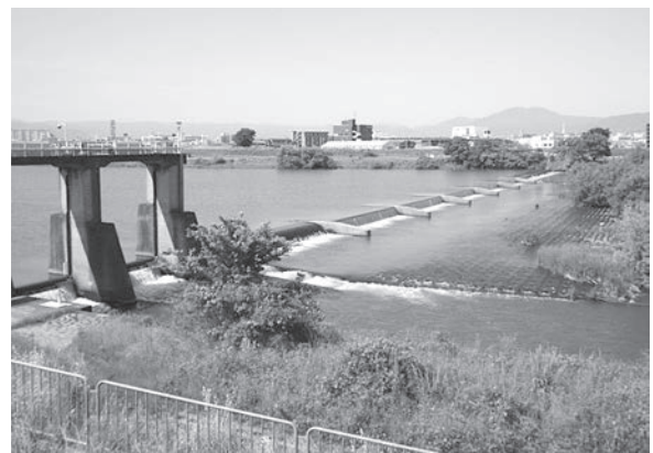
写真-1 久我堰全景(右岸側から)
