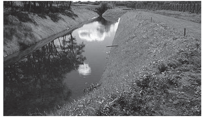
写真-4 整備された排水調整池
