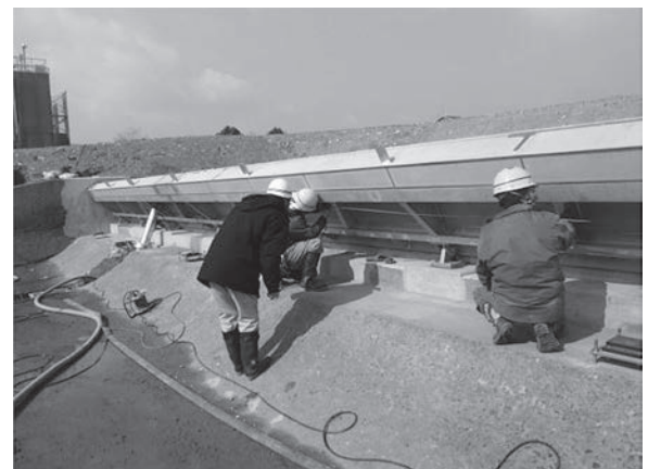
写真-6 洪水吐ゲートの設置
