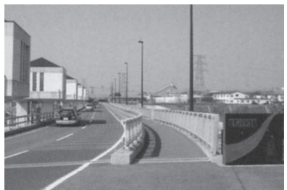
写真-5 農道橋（重忠橋）
