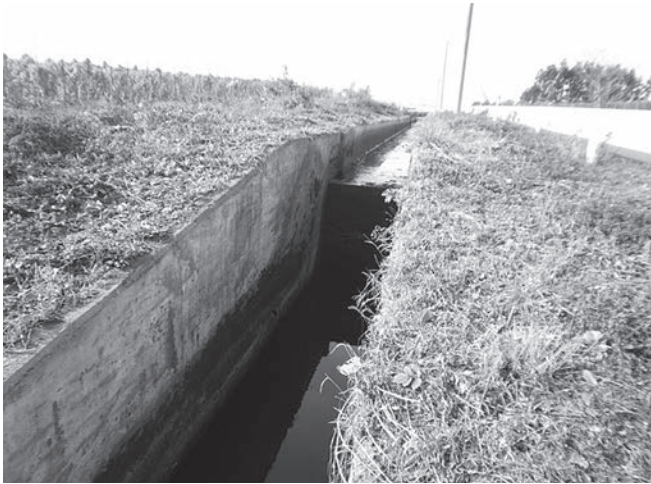
写真-1 第13号落差工（落差1.53m）
