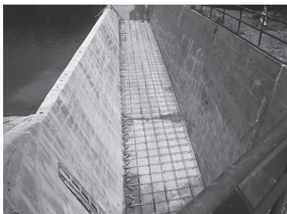
写真-6 既設構造物補修・補強区間施工状況
