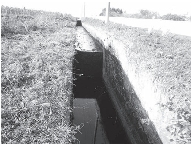
写真-2 第14号落差工（落差1.32m）
