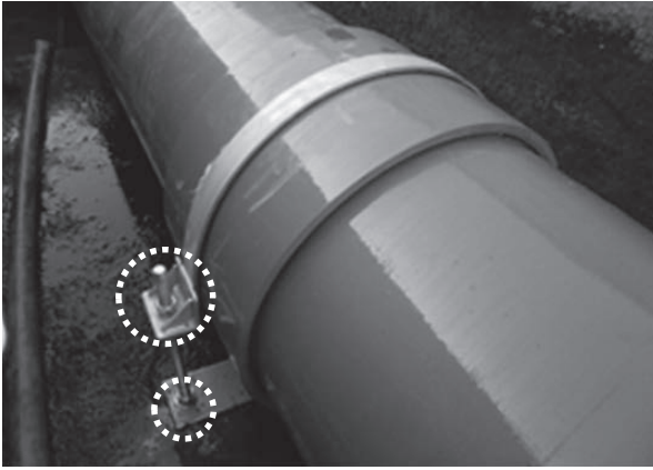
写真-8 ダブルナット止めによる補強
