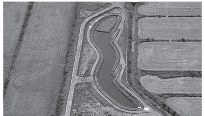
写真-5 整備された遊水池
