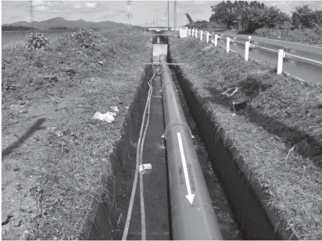
写真-4 既設水路への導水管の設置
