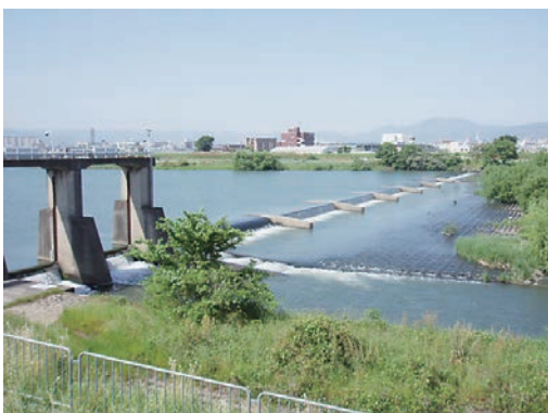
④ 久我堰全景（右岸側から）
