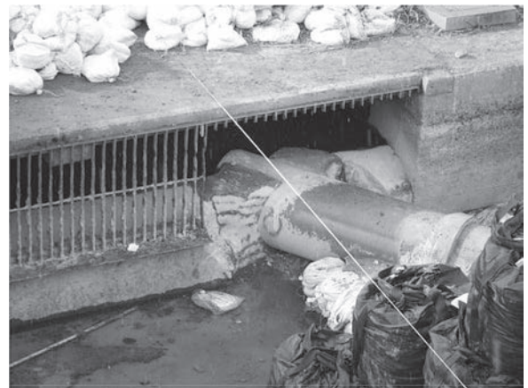
写真-11 仮取水管の設置
