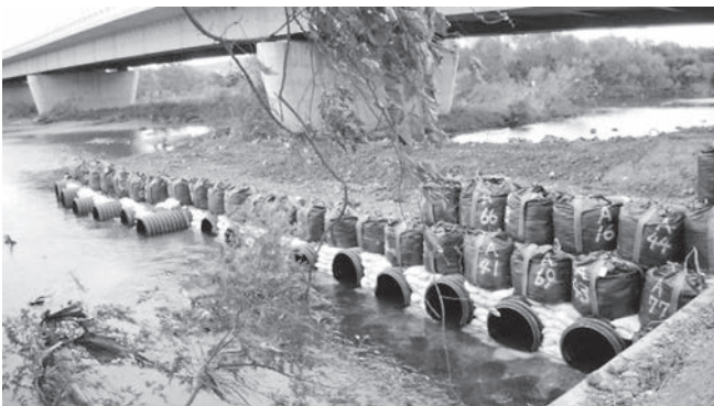
写真-13 コルゲート管の設置
