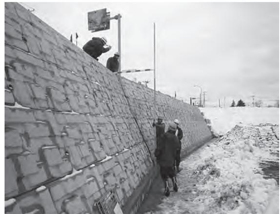
写真-4 完成後の護岸(大型積ブロック)
