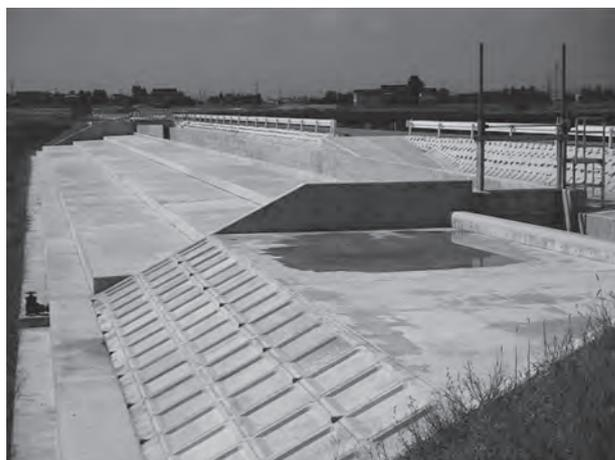
写真-4 延長100mの横越流部 (下流から)
