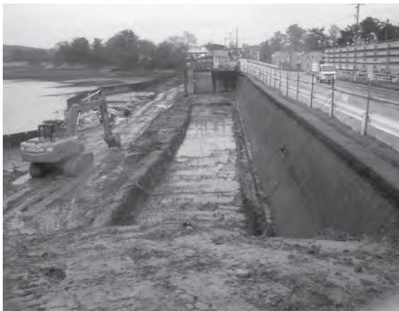
写真-5 仮締切内施工状況
