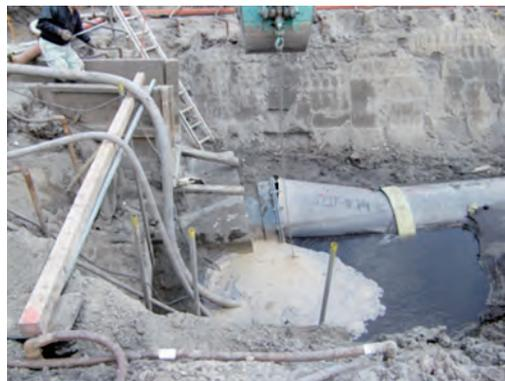
② 東日本大震災の被災状況（管継手部の離脱）
