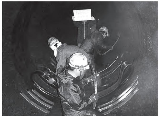
写真－2 内面バンド施工状況（北部幹線用水路副水路）
