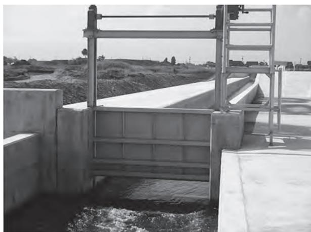
写真-5 下流端堰上げゲート (下流から)
