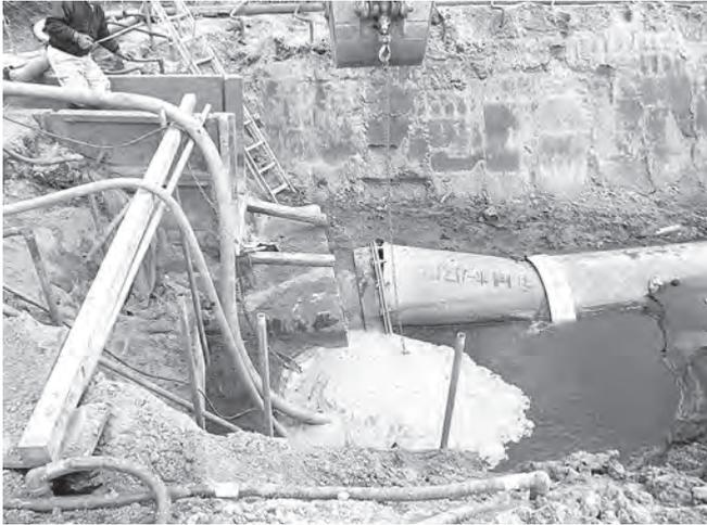
写真－1 管継ぎ手部（φ1,350）の離脱状況
