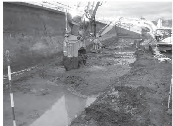
写真-3 パワーブレンダーによる地盤改良
