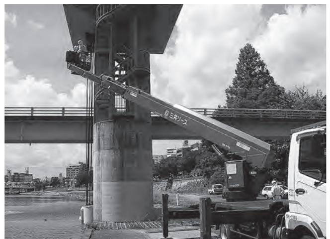
写真-2 高所作業車による調査状況
