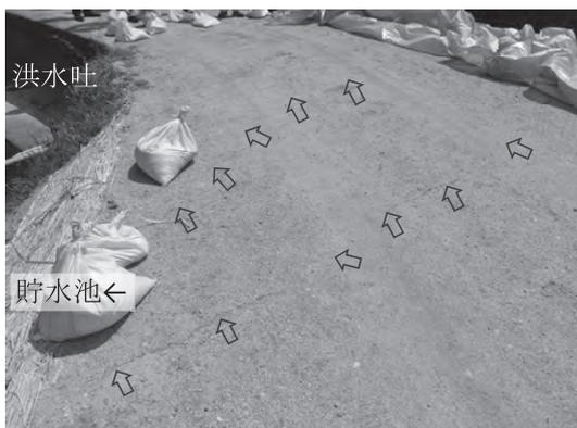
写真-2 天端の横断方向クラック
