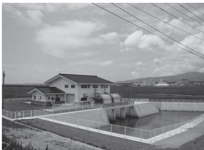
写真-2 金井排水機場
