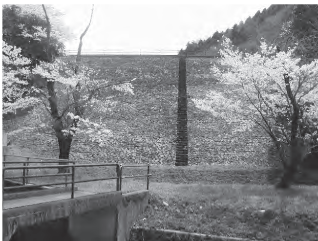
写真-1 小淵防災ダム
