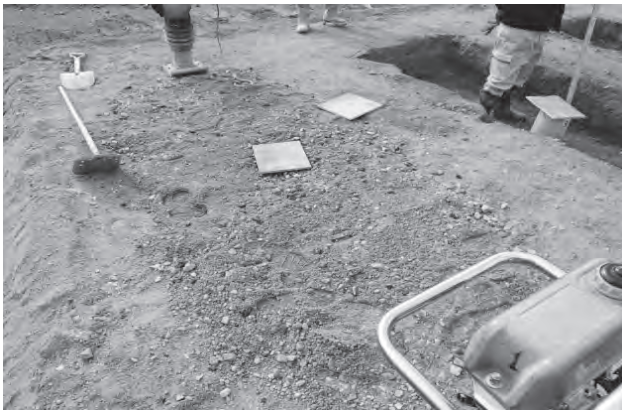
写真-3 RC材のまき出し状況
