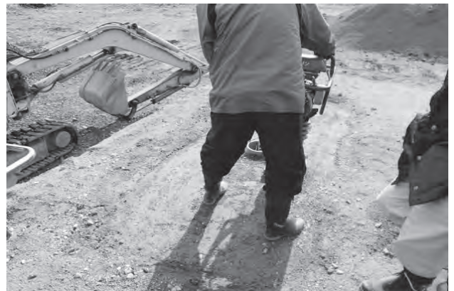
写真-4 RC材のタンパ転圧状況
