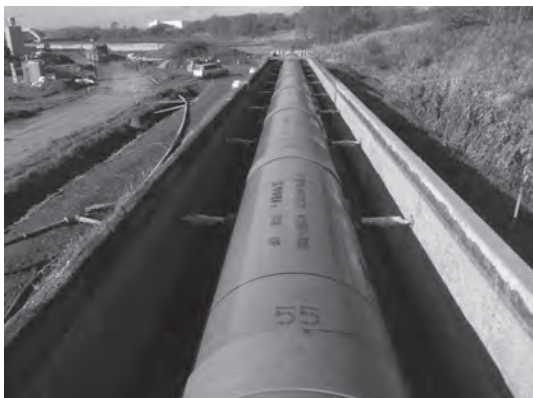
写真-3 パイプサポート設置状況2
