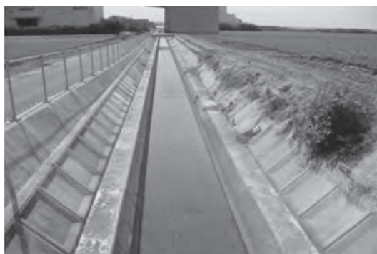
写真-4 海岸近くの幹線水路のライニング状況
