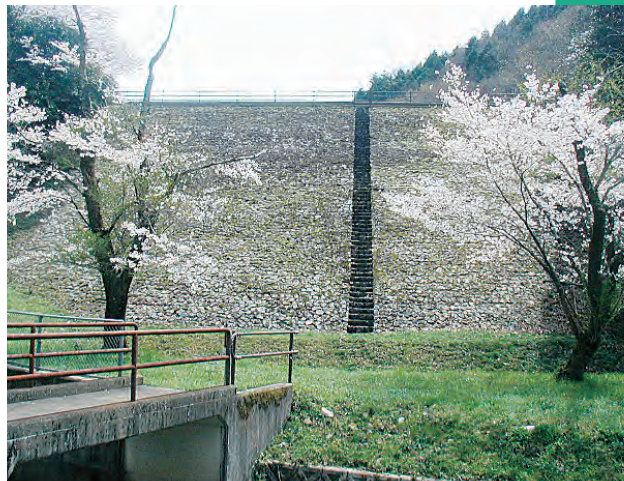
⑥ 小淵防災ダム
