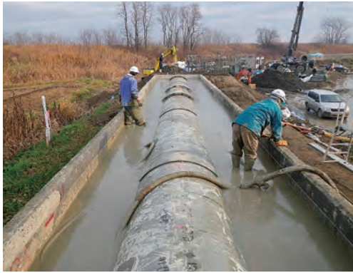
① 流動化処理工法の施工状況
