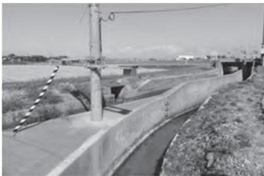
写真-3 超音波水位計の設置状況
