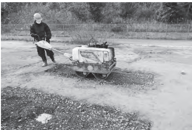
写真-5 一般材の振動ローラ転圧状況
