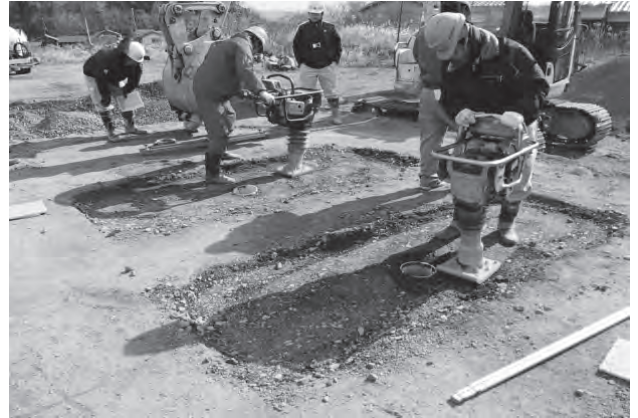
写真-2 一般材のタンパ転圧状況
