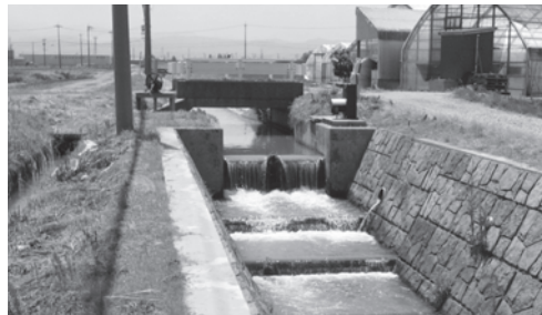
④ 幹線水路に設置された取水堰
