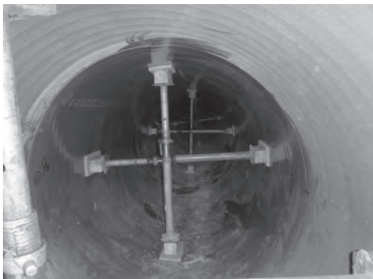
写真-2 パイプサポート設置状況1
