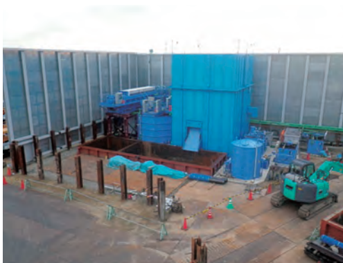
⑤ 泥圧式シールド掘削土の分離処理状況
