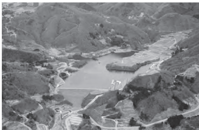
写真-1 小倉ダム
