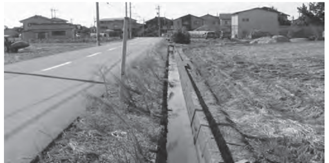
写真-1 末端排水路のライニング状況
