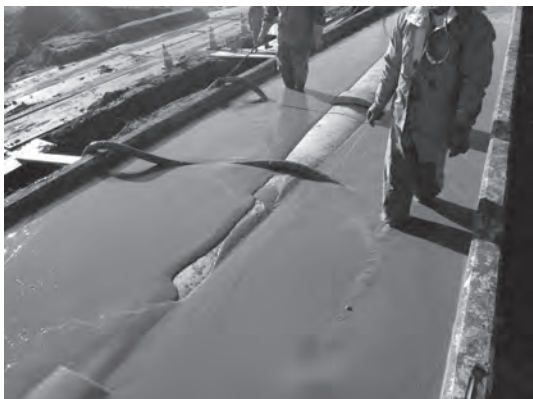
写真-5 流動化処理土打設状況2
