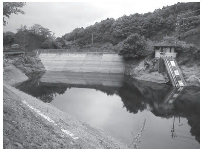
写真-4 堤体及び取水施設
