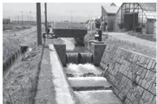
写真-2 幹線水路の取水堰
