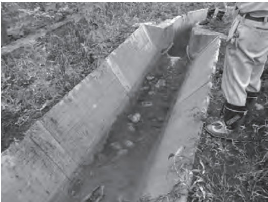
写真-1 コンクリート柵渠 (パネル)
