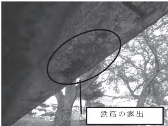
写真－1 水路橋上部工下面状況
