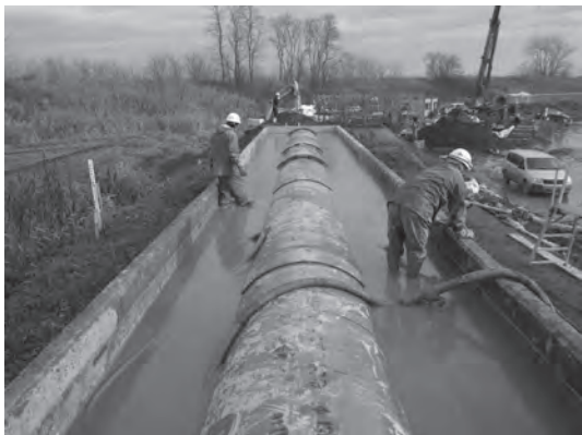
写真-4 流動化処理土打設状況1
