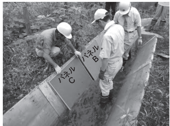
写真-2 壁紙設置状況
