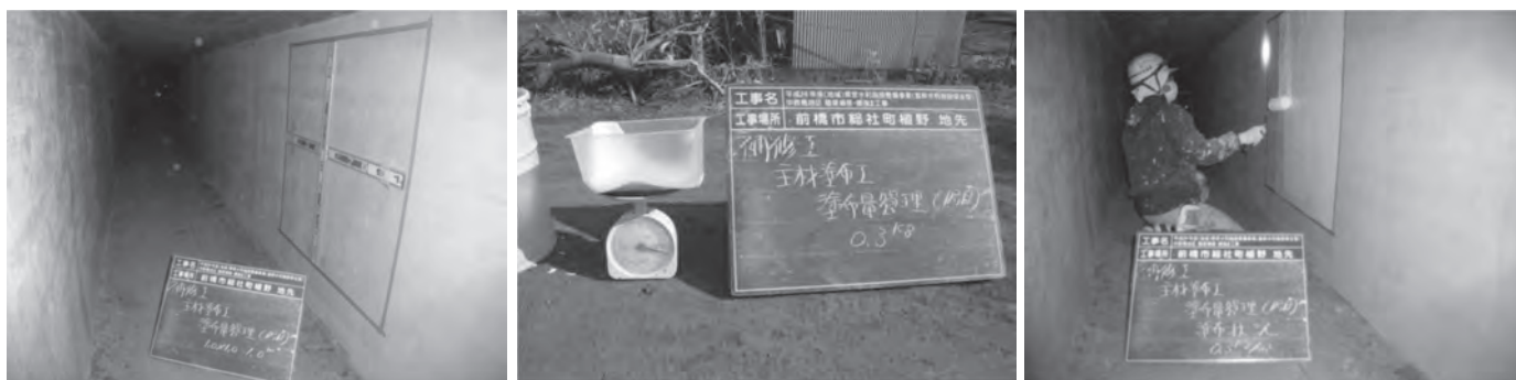
写真-5 表面保護工施工管理
