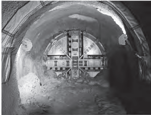
写真－8 接合部掘削（NATM工区）
