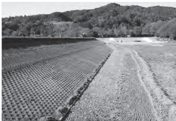
写真-3 西大谷ダムの改修前の堤体上流側の状況
