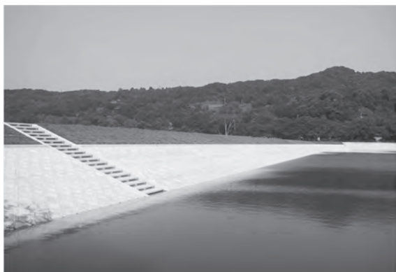
写真-4 西大谷ダムの改修後の堤体上流側の状況
