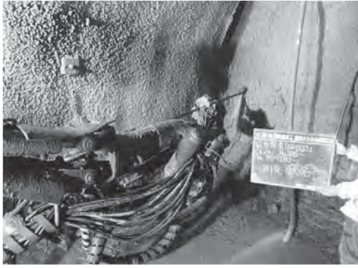
写真-5 ドリルジャンボによる穿孔
