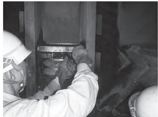
写真-1 ローラーカッター設置状況
