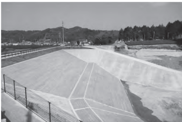
写真-6 谷田大池の改修後の堤体上流側の状況
