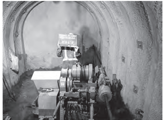
写真-4 水平ボーリング施工状況
