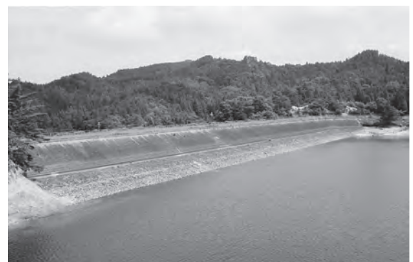
写真-1 大原ダムの改修前の堤体上流側の状況
