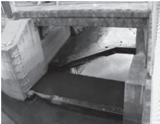
写真-1 調査地点1 (排水路合流部)
