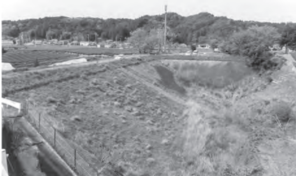
写真-5 谷田大池の改修前の堤体上流側の状況
