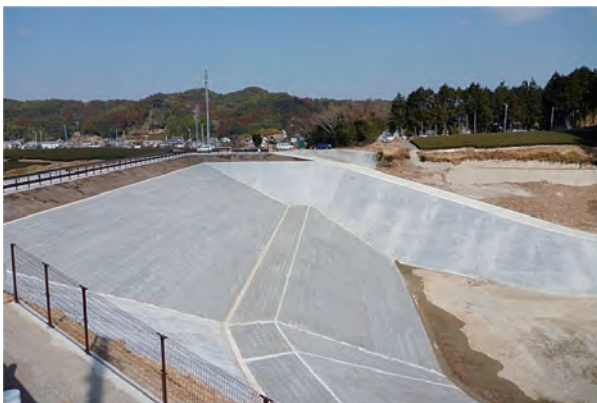
① 改修後の堤体上流側（谷田大池）
