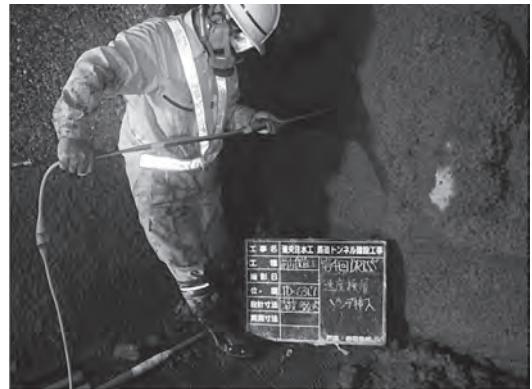
写真-6 ドリルジャンボ穿孔穴による速度検層
