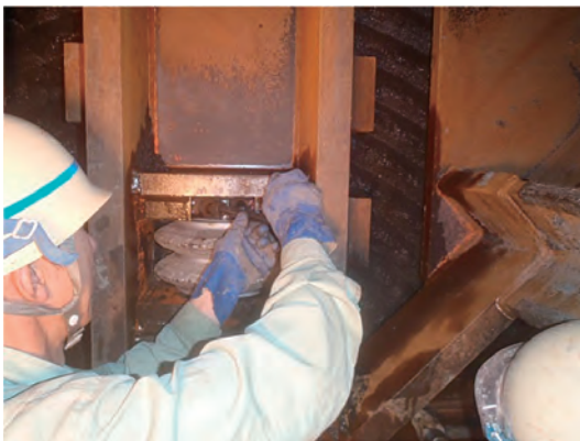
② ローラーカッター設置状況
