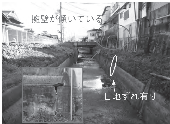
写真-1 施工区間全景（下流より）
