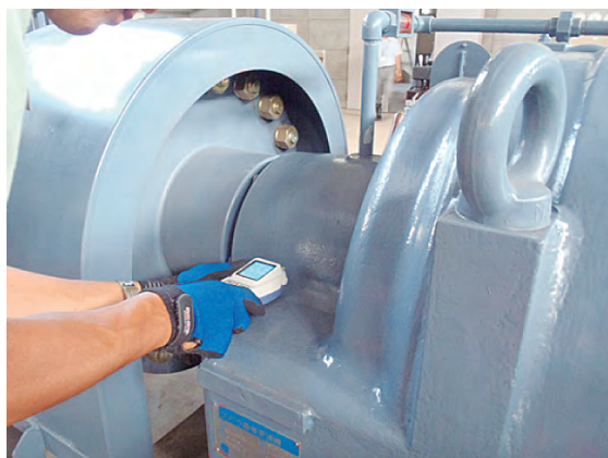
② ポンプ設備の振動調査作業
