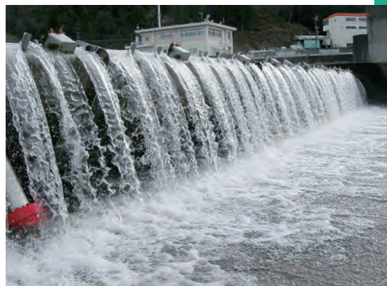
④ 低周波音対策後の越流状況 (細川頭首工)
