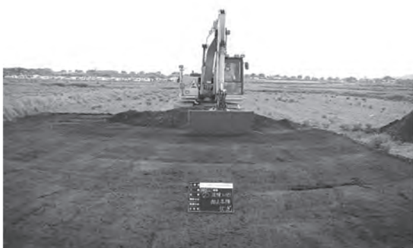
写真-3 堆積土砂の鋤取り撤去状況
