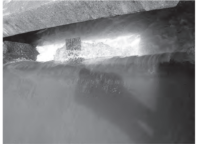
写真-4 放流工起伏ゲート
