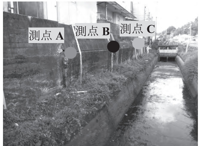
写真-4 施工中の調査測点
