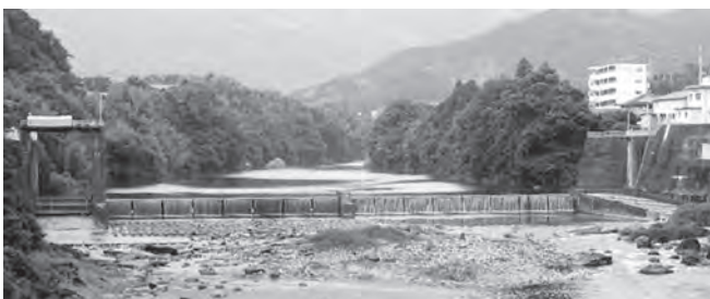
写真-3 現在の物部川合同堰(下流からの風景)
