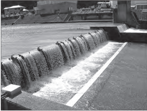
写真-2 洪水吐起伏ゲート
