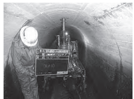
ボーリング調査
