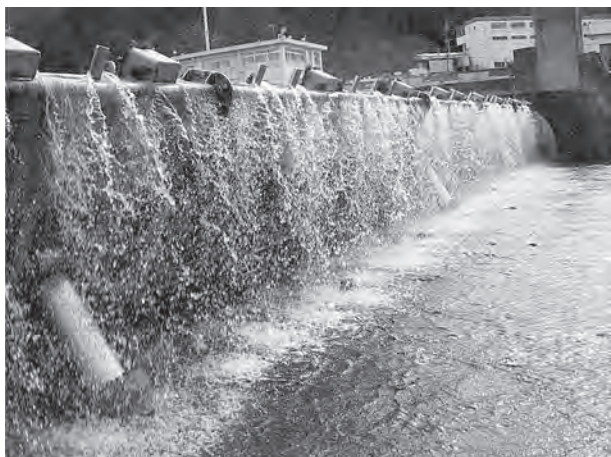
写真-8 スポイラ設置後の越流状況 (1)
