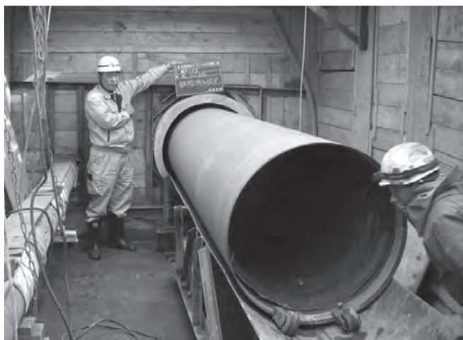
写真-5 PIP工法の事例
