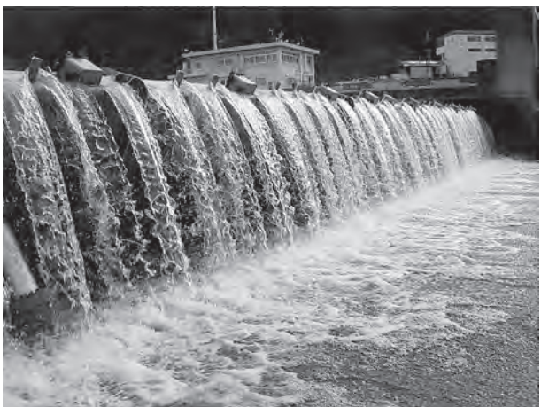
写真-10 スポイラ設置後の越流状況 (3)
