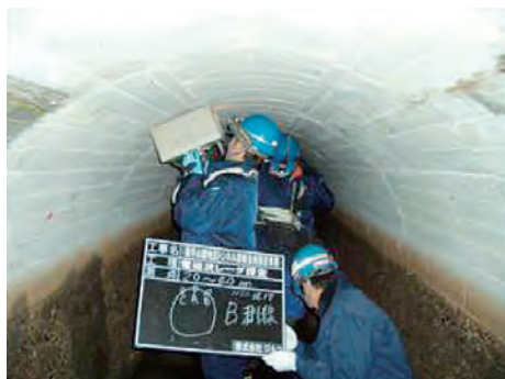
③ 水路トンネルの電磁波レーダー探査
