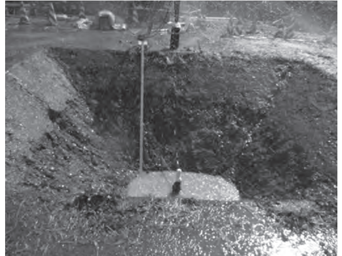
写真-2 人工降雨試験中の掘削底面
