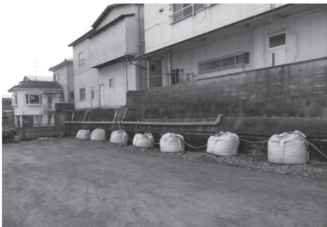
写真-5 大型土のう設置状況
