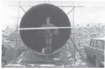
写真-2 宮竹サイホン鋼管の全景（造成時）
