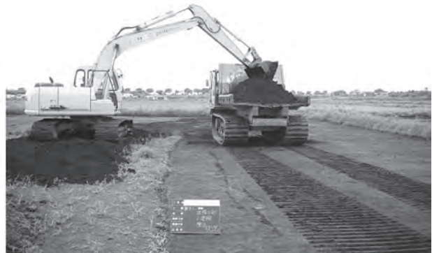
写真-3 堆積土砂の鋤取り撤去状況
