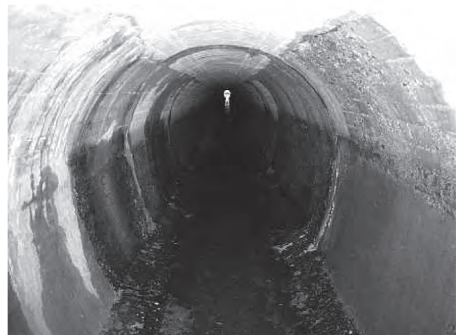
トンネル内部状況写真
