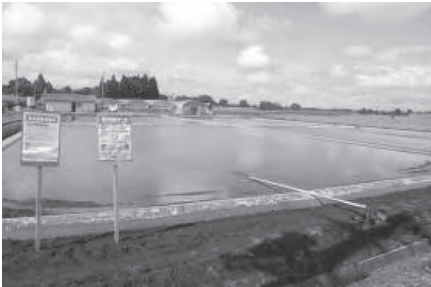
写真-9 湛水防除の実施状況
