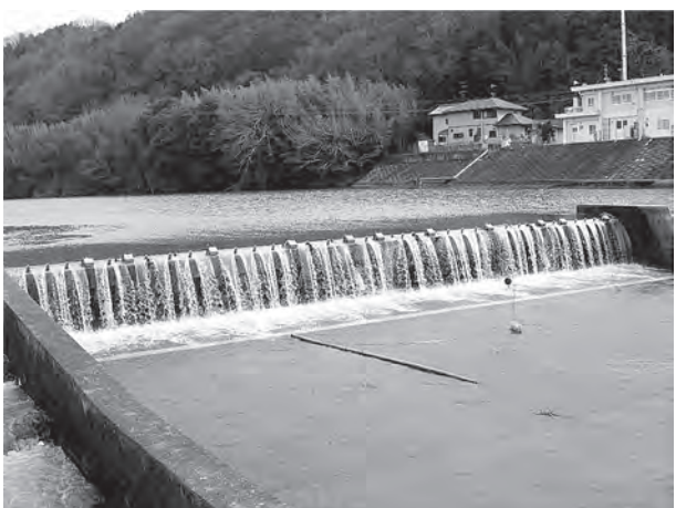
写真-9 スポイラ設置後の越流状況 (2)
