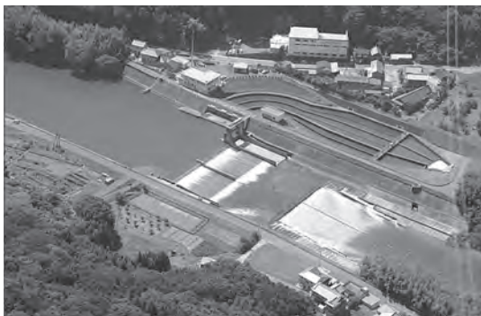
写真-1 細川頭首工
