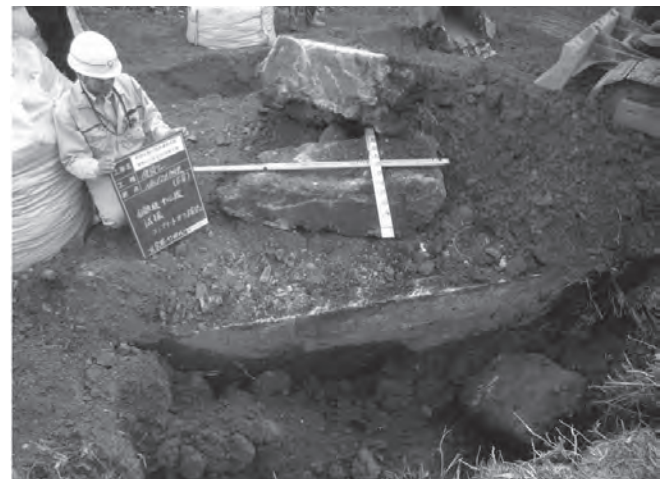
写真-2 試掘で確認されたコンクリート殻
