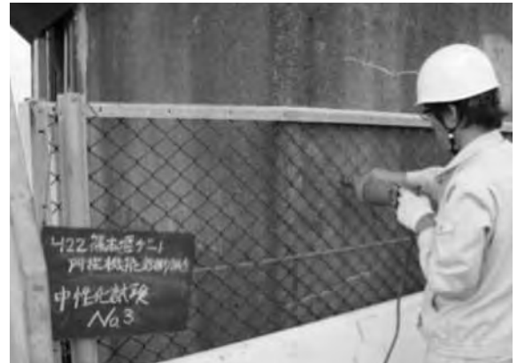
写真-2 コンクリート中性化試験（ドリル法）
