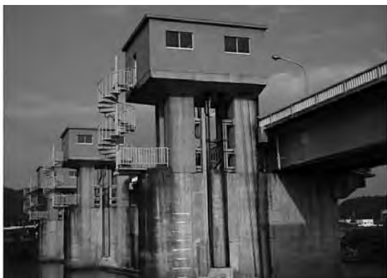
写真-3 堰柱写真(右岸より)
