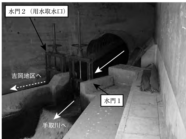
写真-1 現況取水口（下流より）
