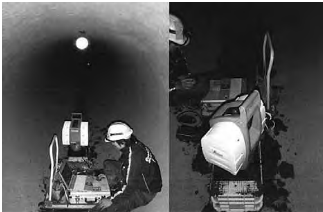
写真-2 3Dレーザー計測の状況
