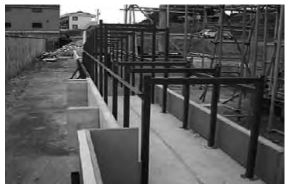
写真-1 架台組立・模型レベル出し
