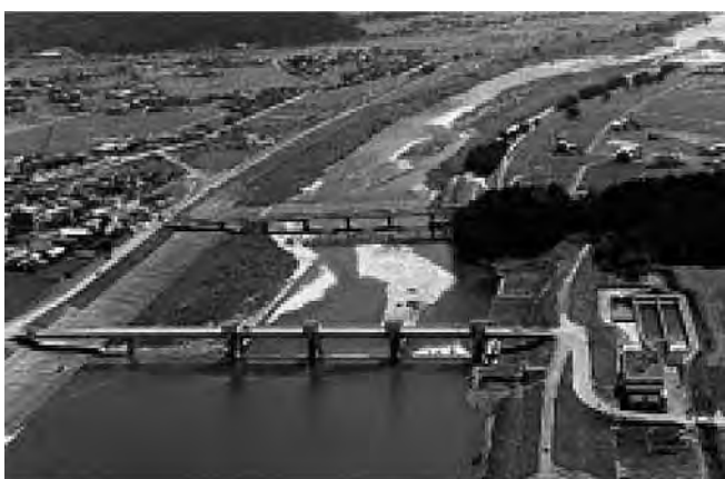
写真-1 岡島頭首工航測写真
