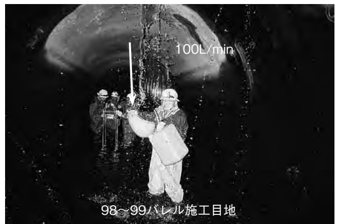
写真-2 毎分約100Lの浸入水の状況
