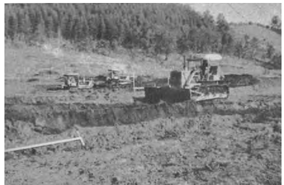
写真-2 遊水地の整地状況
