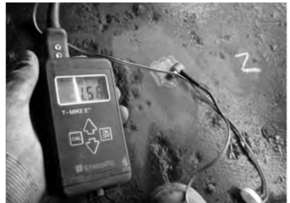
写真-3 扉体主桁板厚測定（2号ゲート）
