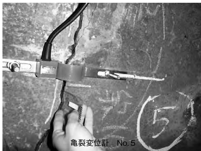
写真-6 亀裂変位計設置状況（近景）
