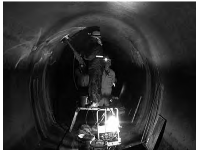
写真-3 トンネル坑内からのボーリング
