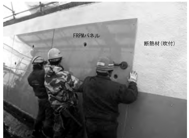
写真-3 FRPMパネル工法(吹付断熱)の施工状況
