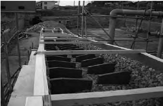
写真-3 導壁設置・完成
