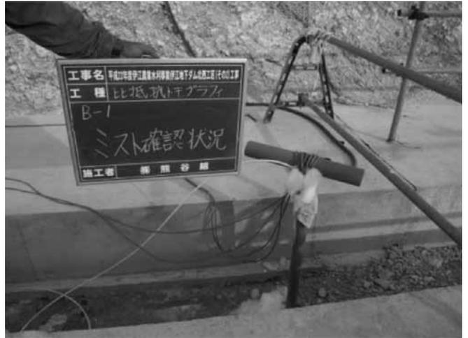
写真-3 ボーリング孔内ミスト充填
