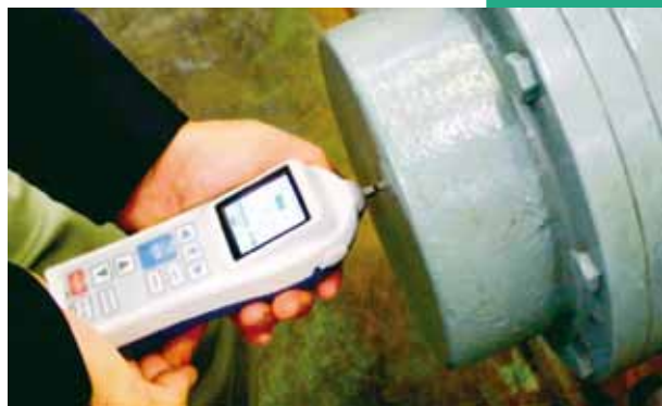
④ ポンプの振動計測
