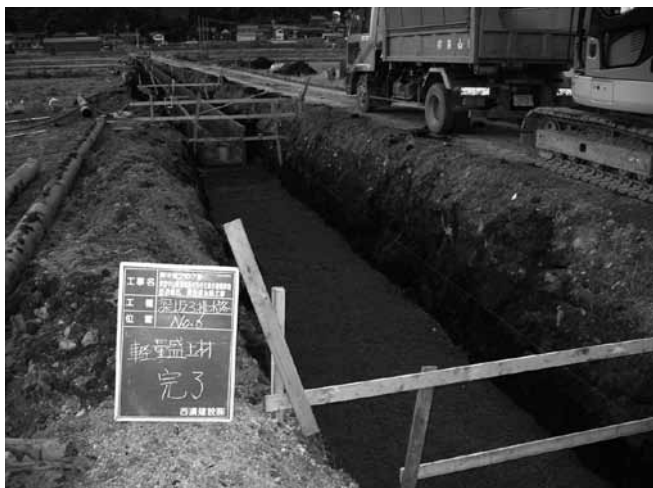
写真-5-2 深坂3排水路施工状況
