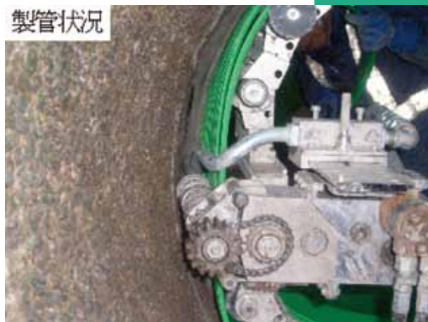
⑤ サイフォン改修状況
