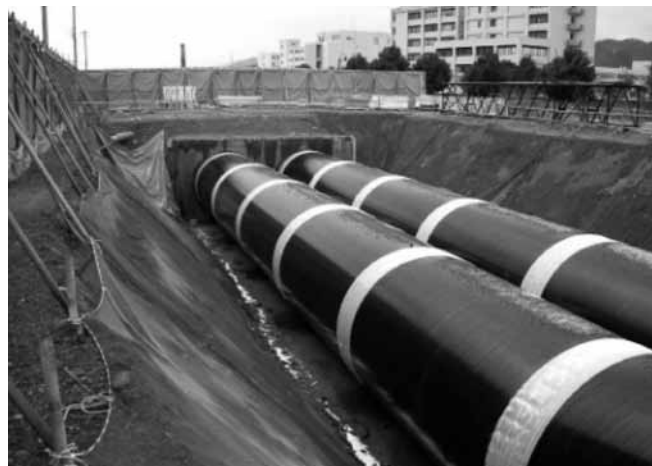
写真-1 右岸幹線用水路鋼管布設状況 (φ2,800mm×2連施工)
