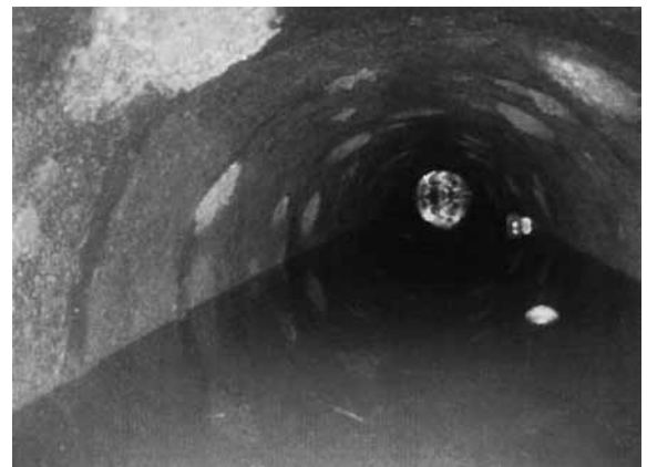
改修前 サイホン内写真1
