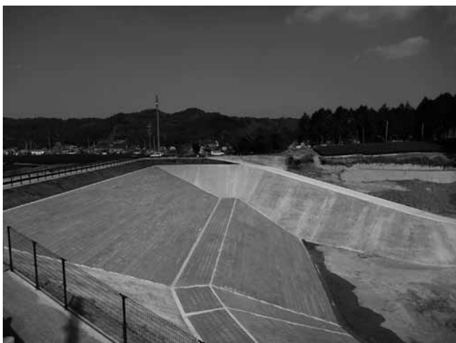
写真二 改修工事実施後の堤体上流側の状況
