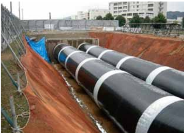
① 幹線水路鋼管敷設状況
