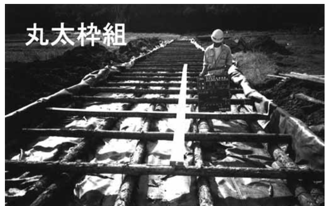
写真-3-1 丸太枠組ALC工法施工写真
