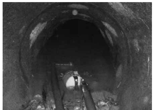
改修前 サイホン内写真2
