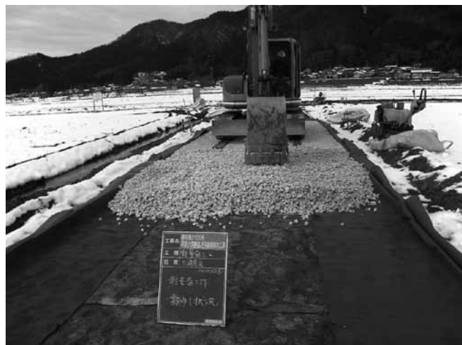
写真-5-1 大洞農道施工状況（H21年度）
