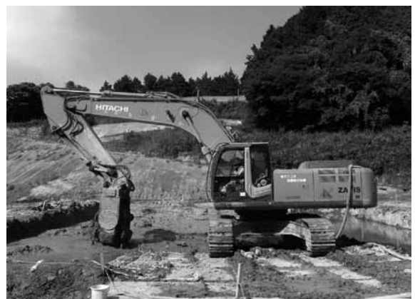
写真-4 混合混凝土の初期固化状況
