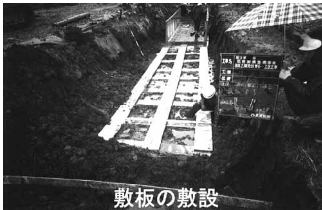
写真-3-2 敷板丸太杭工法施工写真
