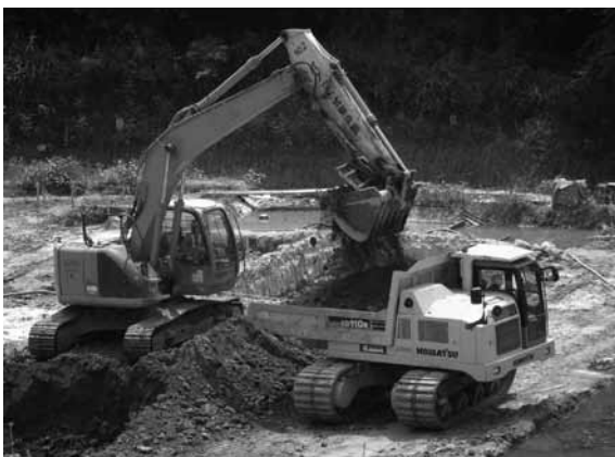
写真-5 初期固化土の掘削・解砕・積込み状況
