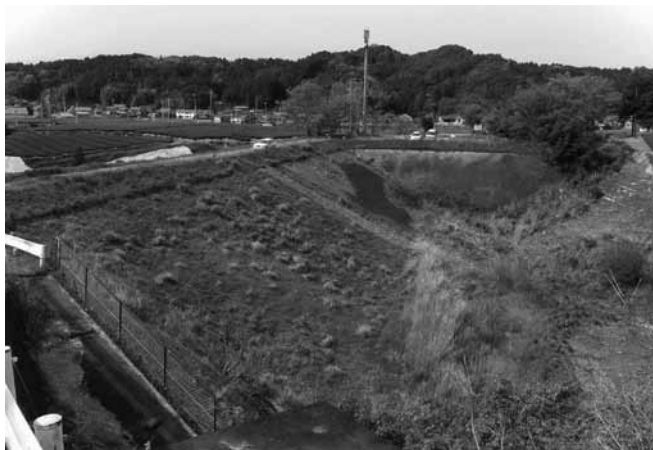
写真一 改修工事実施前の堤体上流側の状況
