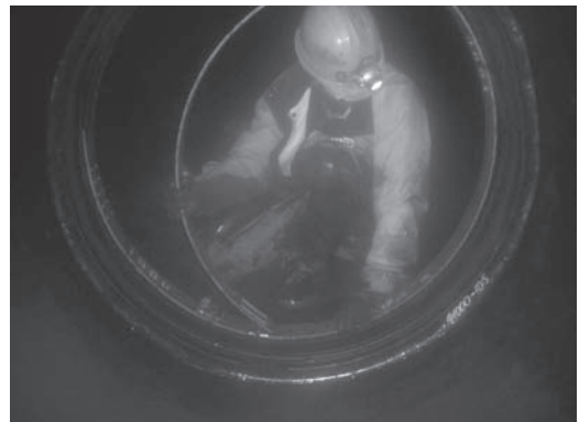
写真-3 継目補修材取付
