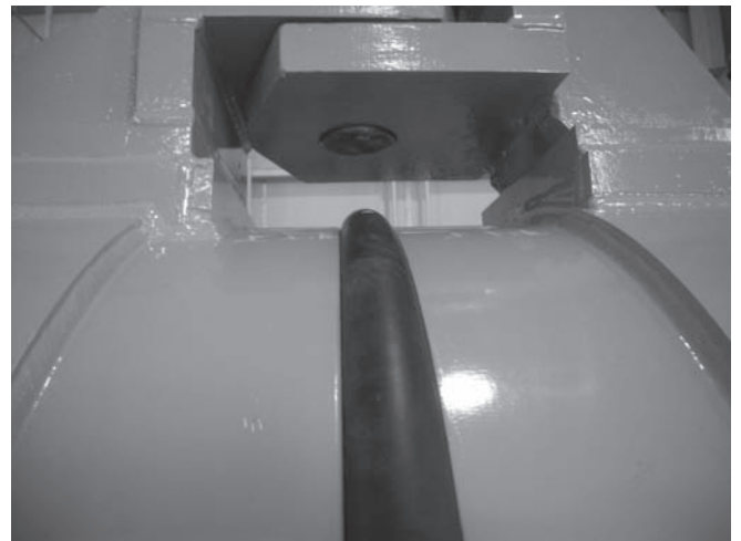
写真-9 膨張測定状況
