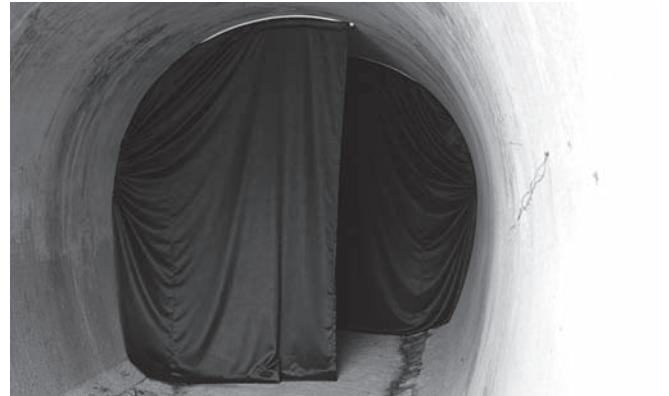
写真-9 遮蔽幕の設置状況
