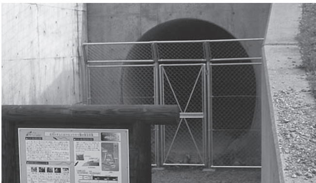
写真-8 バットゲートの設置状況
