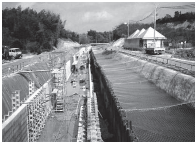
写真-5 半川通水による本体片側施工
