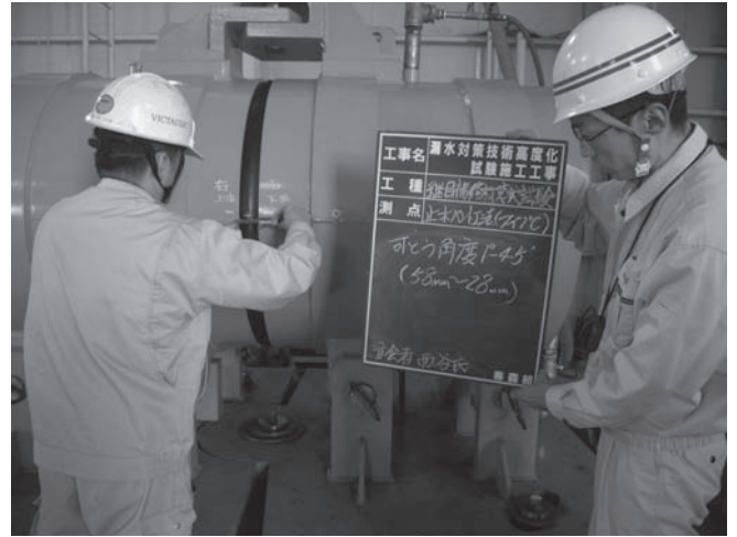
写真-8 内圧試験状況
