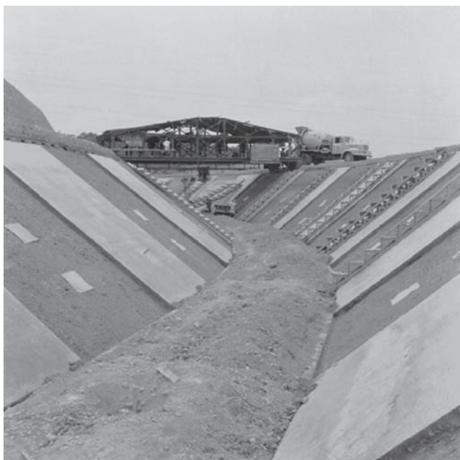
写真-2 一期の開水路施工状況
