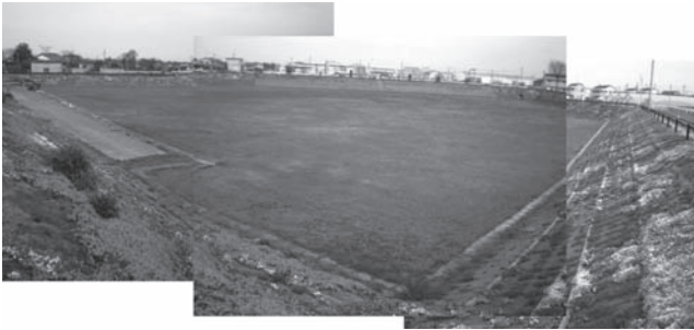
写真-4 大谷幹線遊水池（新設）
