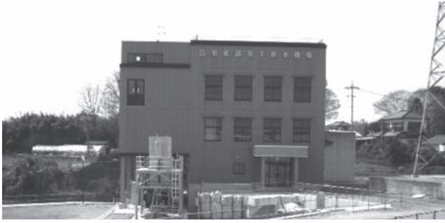
写真-3 邑楽東部第1排水機場（改築後）
