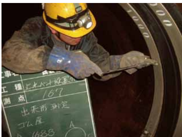
② 管継ぎ目補修
