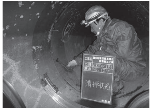
写真-2 継目取付部清掃
