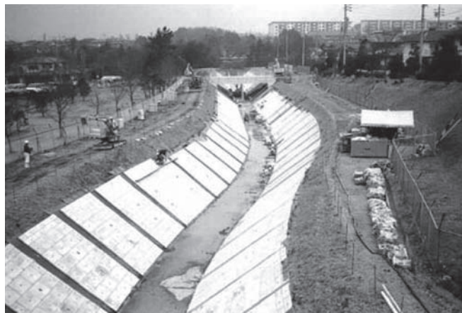
写真-6 農業専用区間（コンクリートブロック上張り）
