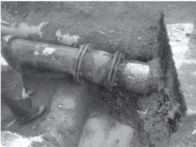
写真-1 漏水箇所
