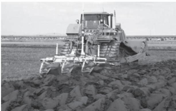
写真-2 反転均平工法作業状況
