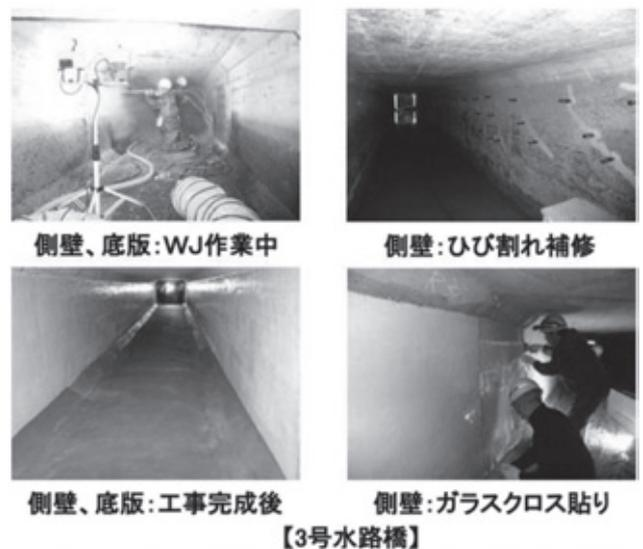
写真-3 施工状況 (3号水路橋)
