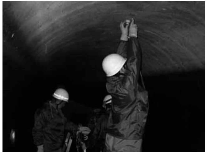
写真-2 衝撃弾性波測定調査状況
