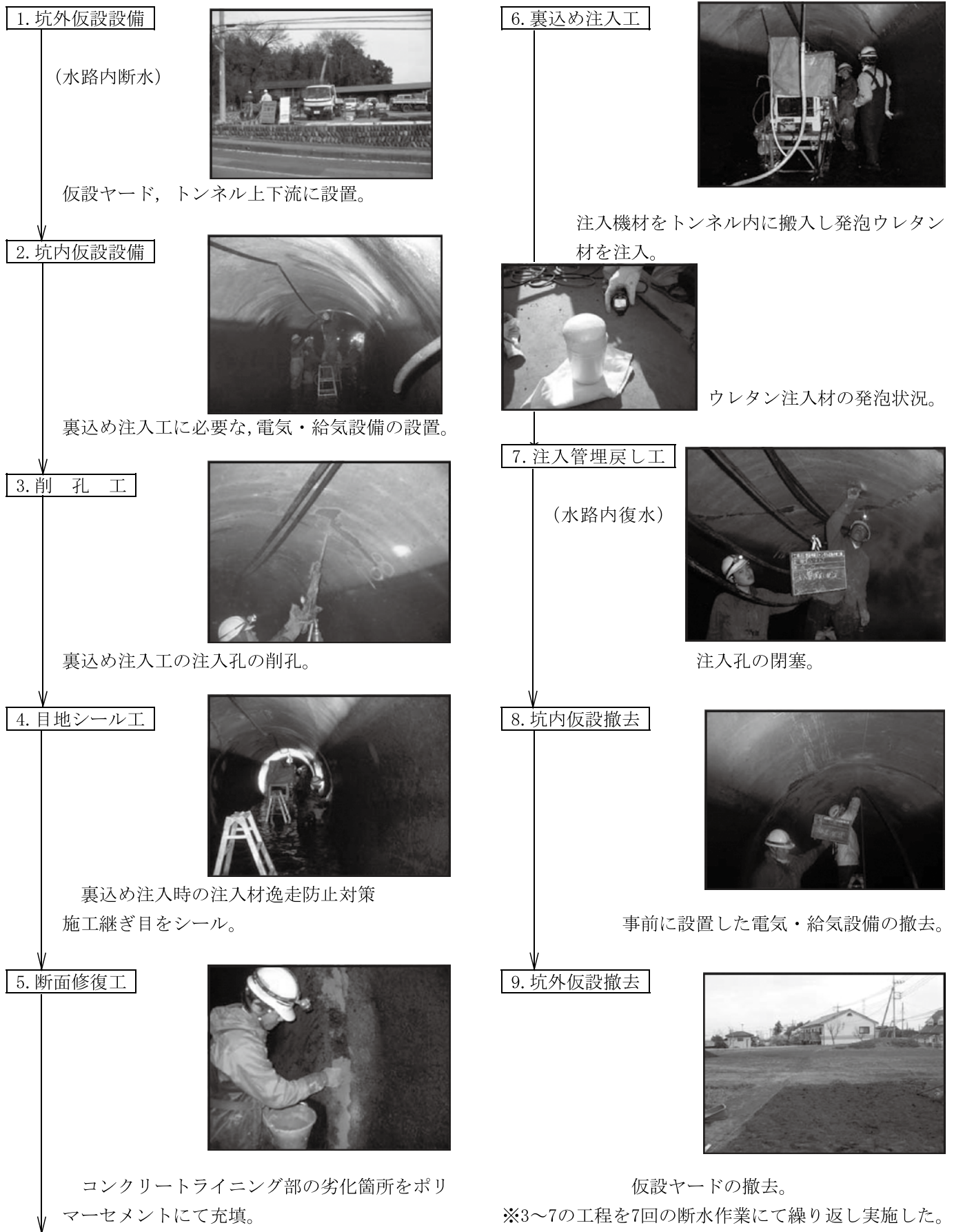
図-6 対策工の施工フロー
