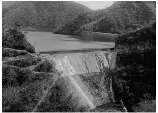
写真-5 完成した溜池（余水吐より望む）
