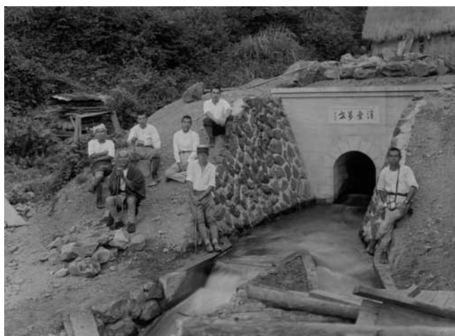
写真-2 隧道の出口
