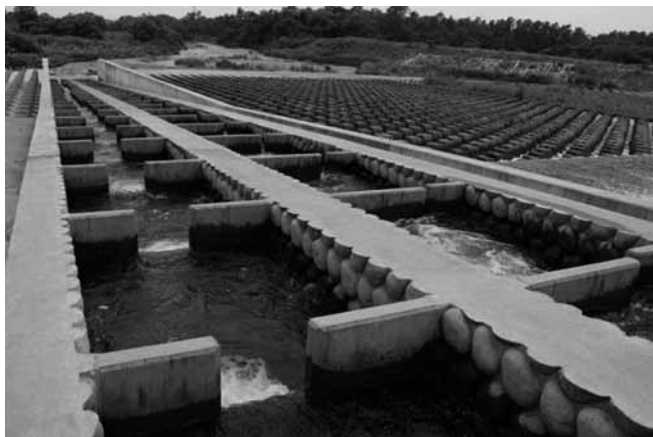
写真-2 三丁目頭首工の魚道 (上流側から下流方向)
