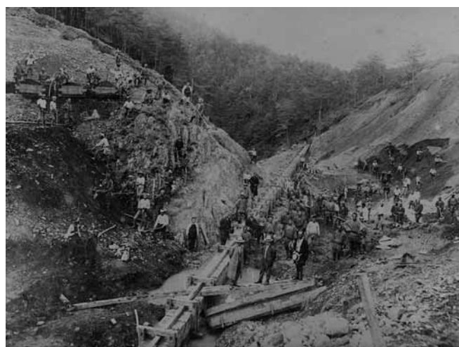
写真-3 溜池工事中（底樋と思われる）
