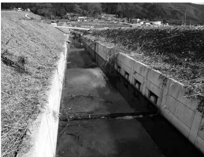
写真-3 生態系配慮型水路
