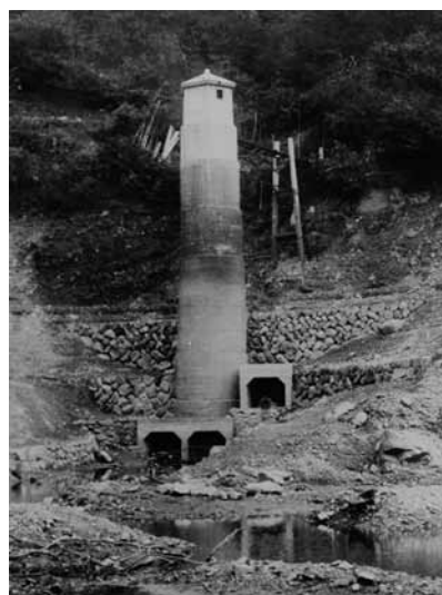
写真-4 溜池工事中（取水塔）
