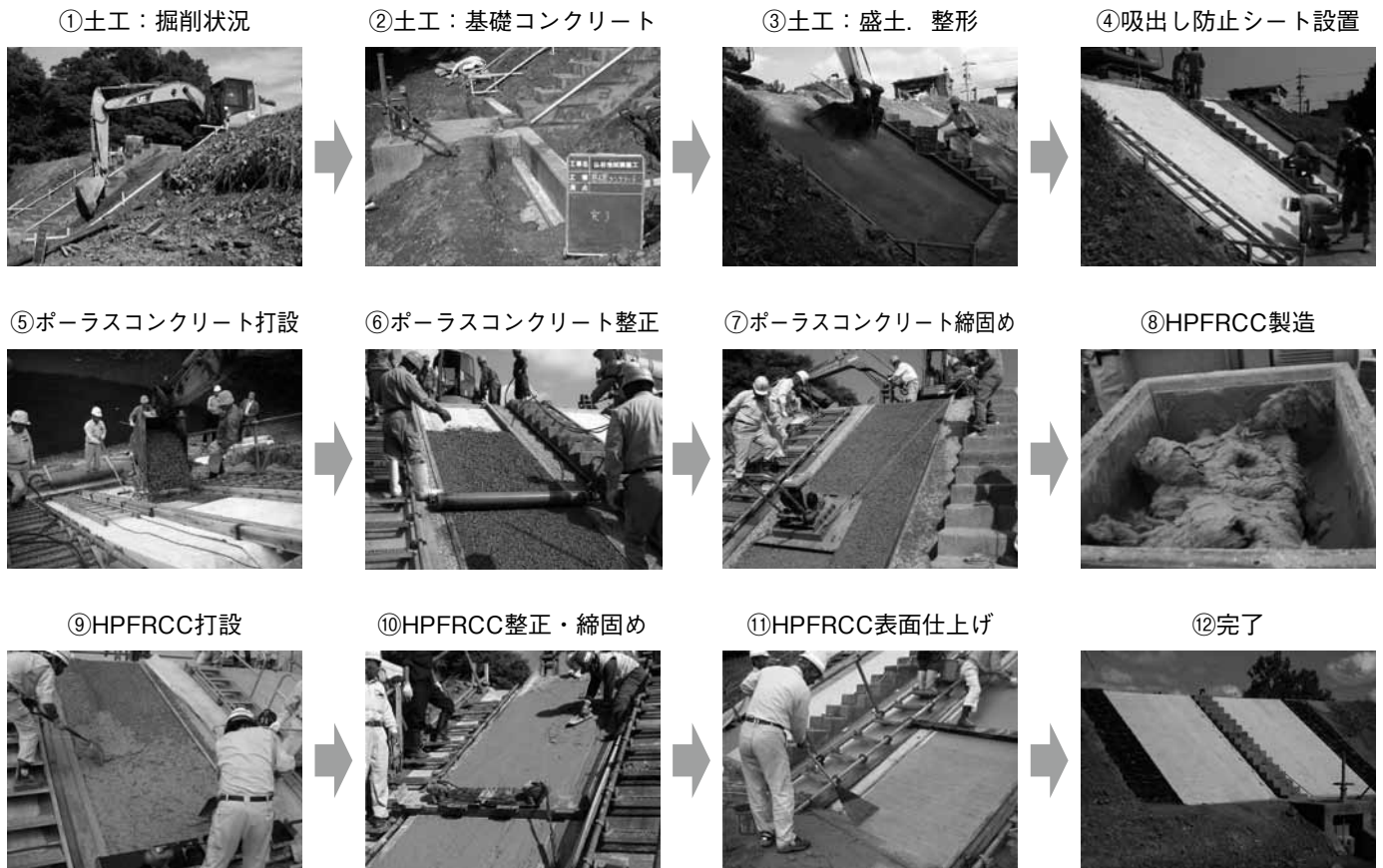
写真-4. 1 施工状況
