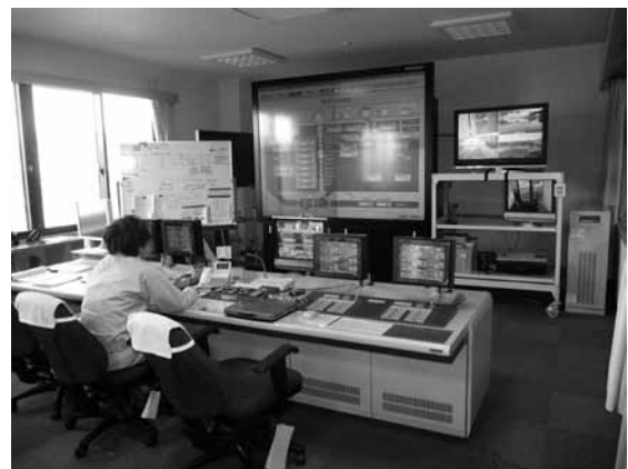
写真-2 更新された管理施設
