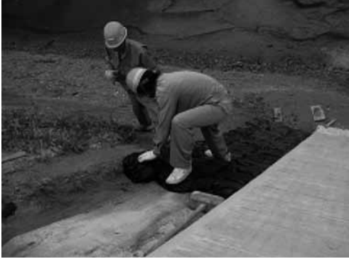
写真-4. 3 UV土嚢設置状況
