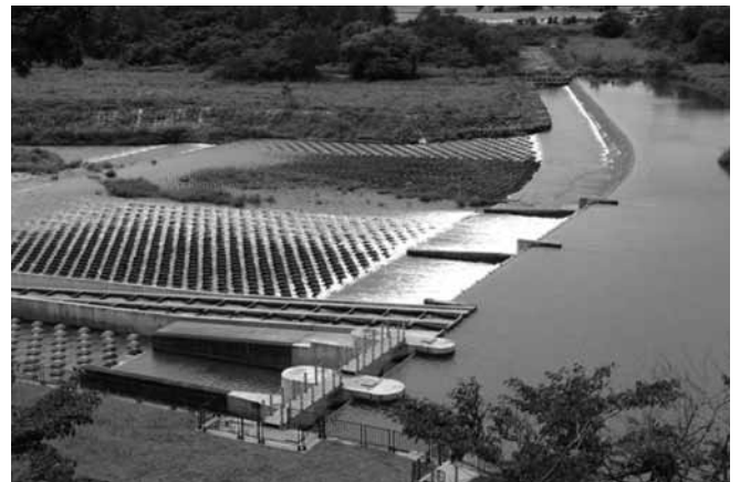
写真-1 三丁目頭首工全景
