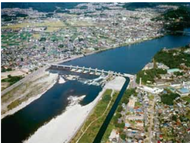
③ 犬山頭首工全景（新濃尾地区）
