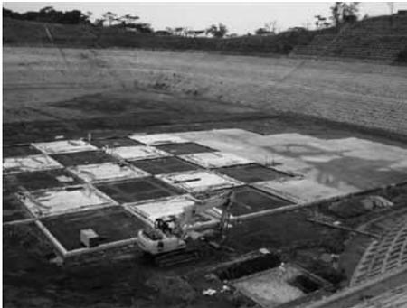
写真-3 キャップコンクリート打設状況
