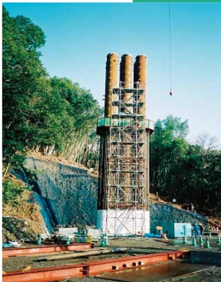
④ 鋼管コンクリート複合構造橋脚
