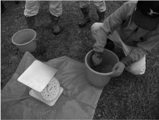
①量りを使用してインスタントモルタル5kgに水650ccを加えて混合する
