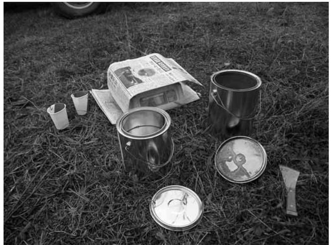
②量りを使用して主材と硬化剤を1：1.5の割合で混合
