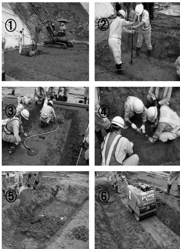
図-4 ワイヤレス埋設計器の設置手順
