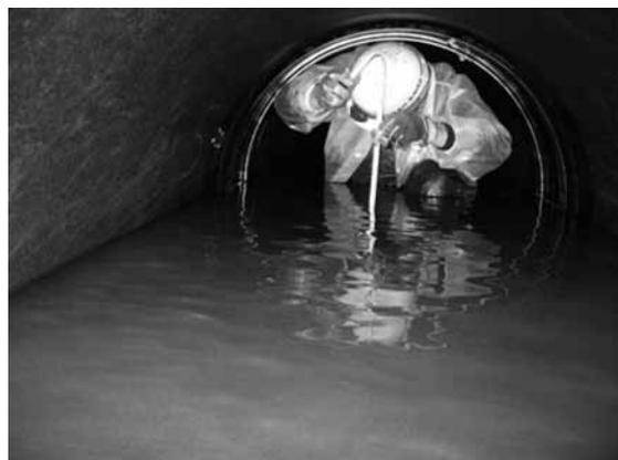
管径の1/2を越える沈下
