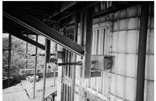
写真-7 型枠支保工
