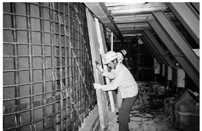
写真-8 型枠取付
