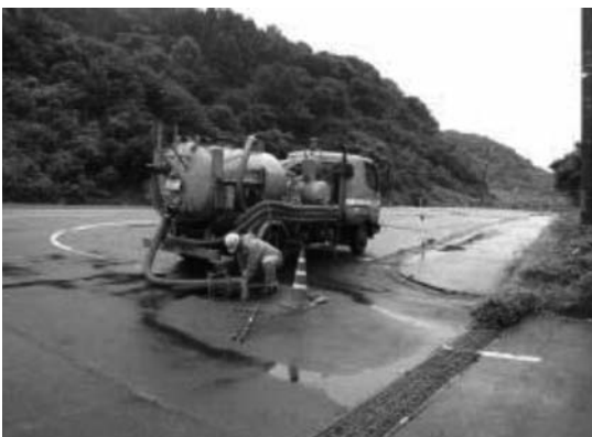
写真-6 バキューム車対応状況
