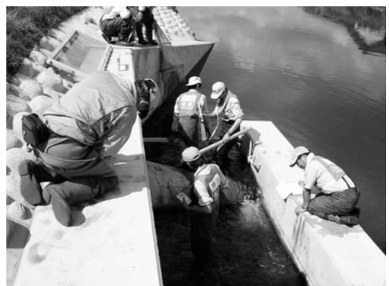
写真-1 魚道調査状況写真
