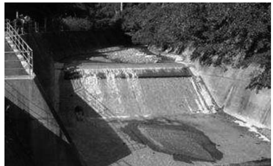
写真-6 員弁川取水工改良前（チロル型）
