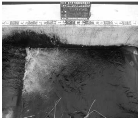
写真-3 石堰魚道内の流況
