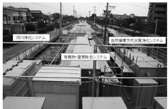
写真-1 実験施設
