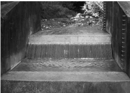
写真-5 冷川取水工改良後（チロルⅡ型）
