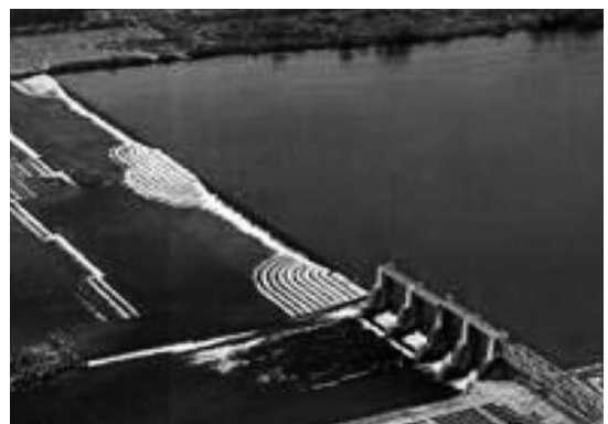
写真-4 高梁川合同堰
