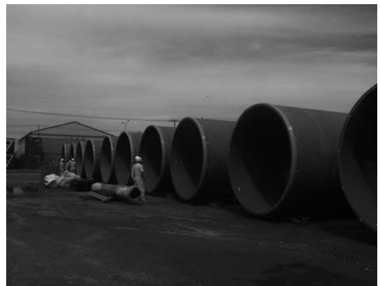
写真-2 資材置場における保管状況の確認
