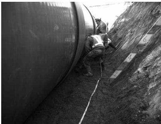
写真-1 人力による管底部の転圧状況
