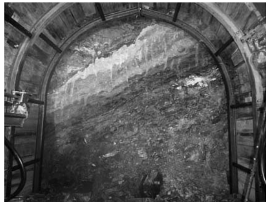
写真-1 トンネル切羽で確認された地すべり粘土
