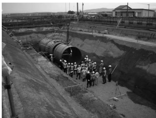
写真-3 現場作業員を対象とした講習会の実施状況
