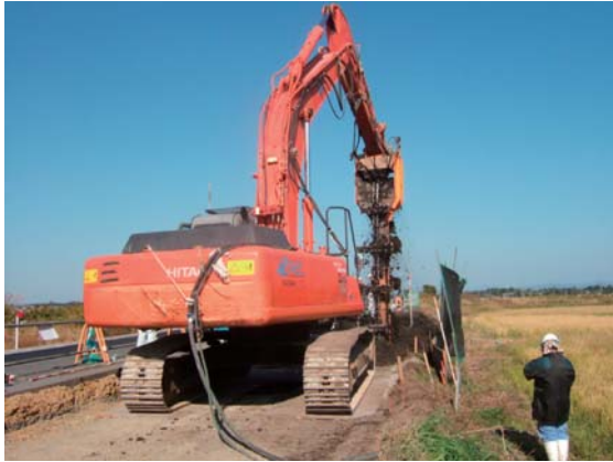
原位置土攪拌状況（後方より）
