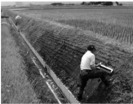
写真-5 削溝器による溝切り作業
