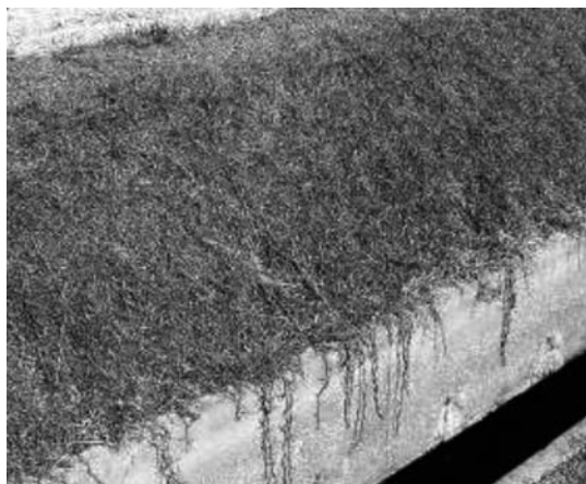
写真-2 ほふく茎が水路内に侵入した状況
