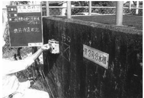
写真-1 鉄筋探査状況
