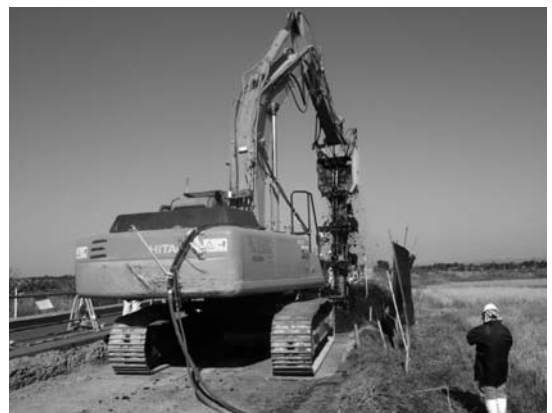
写真-3 原位置土攪拌状況（後方より）
