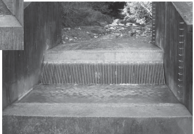
冷川取水工改良後 (チロルⅡ型)
