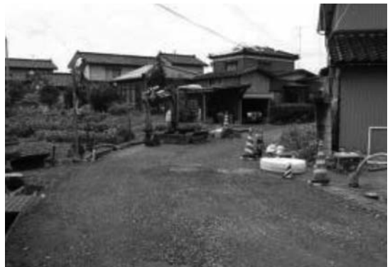
写真-7 仮配管による応急復旧状況
