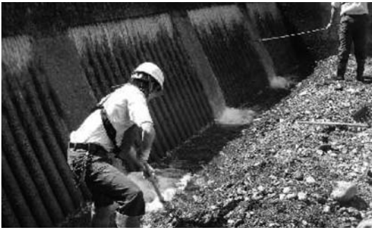
写真-2 人力による河内谷川取水工土砂撤去状況
