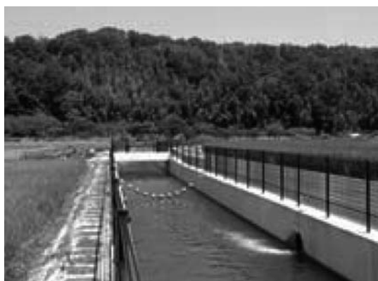
写真-6 改修された湛井十二ヶ郷用水路
