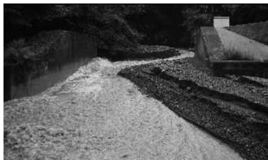
写真-8 冷川取水工取水堰状況(9月3日)
