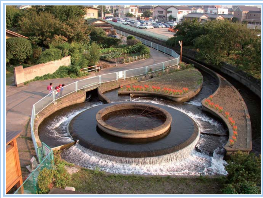
円筒分水堰（群馬県長野堰用水）
