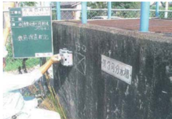
鉄筋探查状況
