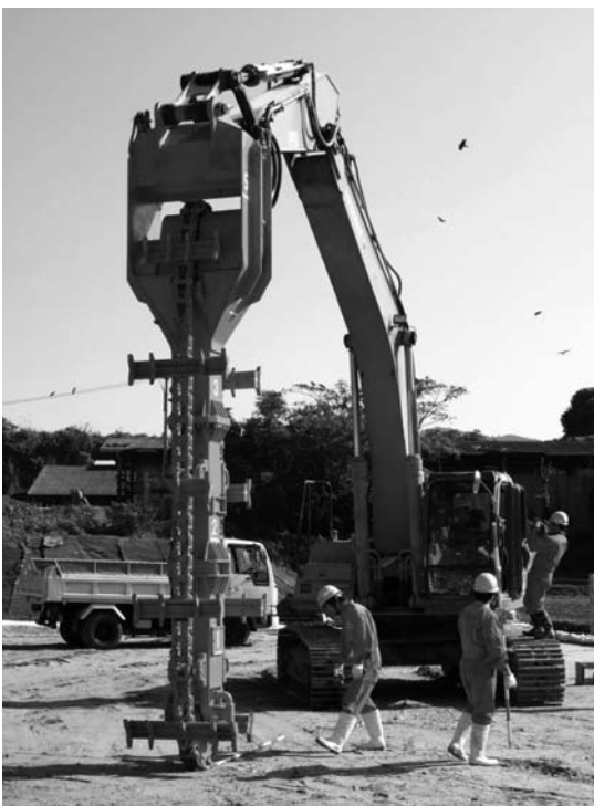
写真-1 攪拌機械全景
