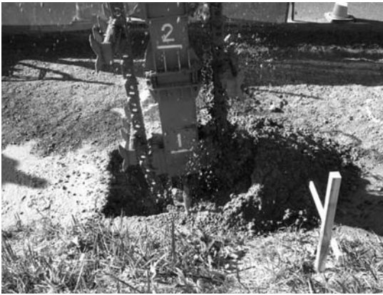
写真-4 原位置土攪拌状況 (近景)
