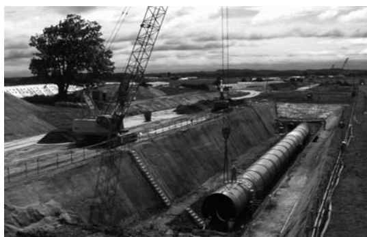
写真-4 大口径FRPM管の布設状況
