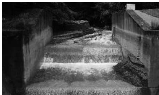
写真-9 冷川取水工取水堰状況(9月4日)
