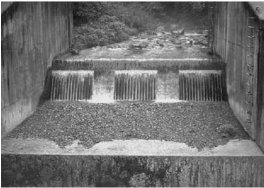
写真-4 冷川取水工改良前（バックストリーム型）
