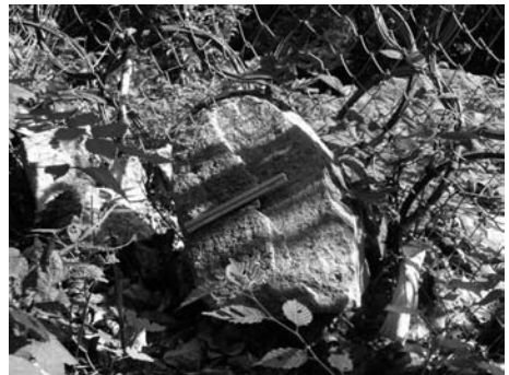
写真-14 施工済の高エネルギー吸収柵で捕らえた20×30×20cm程度の転石
