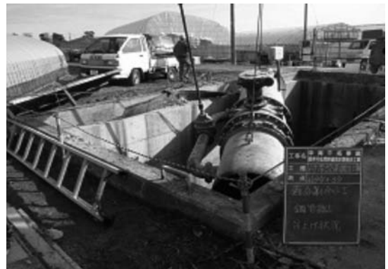
写真-7 分水管撤去状況
