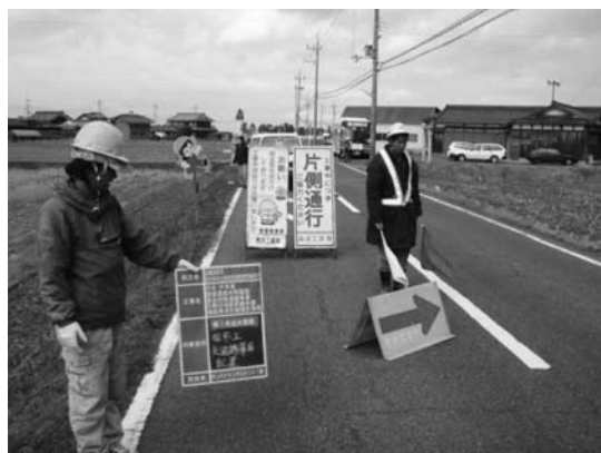
写真-4 交通誘導状況
