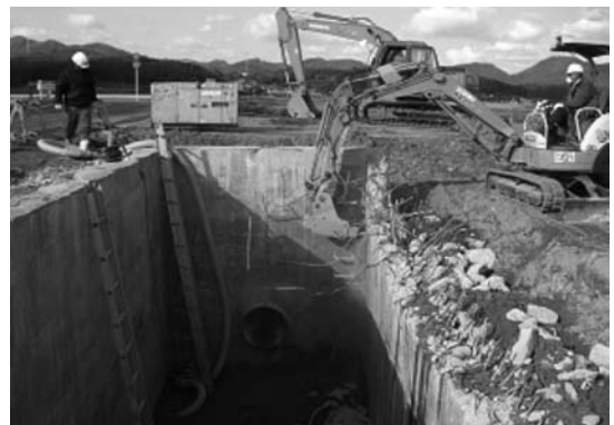
写真-8 分水管撤去状況
