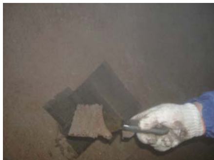
付着汚泥除去状況
