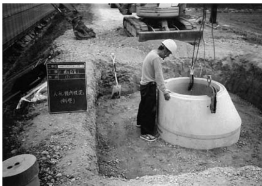
写真-3 追加人孔設置状況
