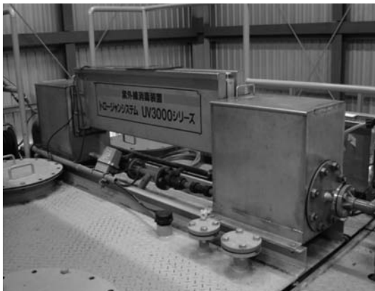
写真-1 紫外線消毒装置
