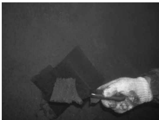
写真-8 付着汚泥除去状況
