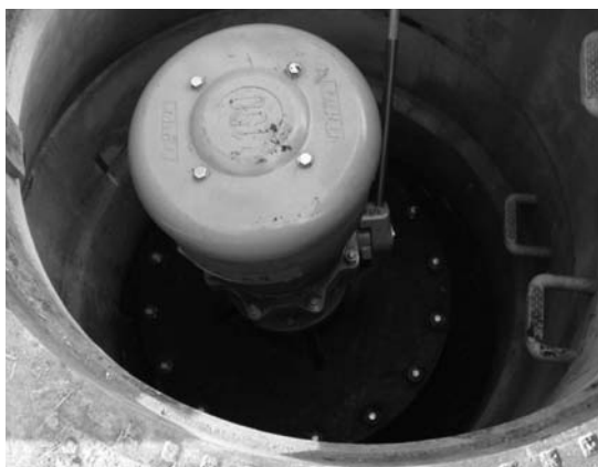
写真-10 ステンレス製ボルトにより再設置
