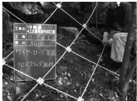
写真-7 ワイヤーロープ等設置状況
