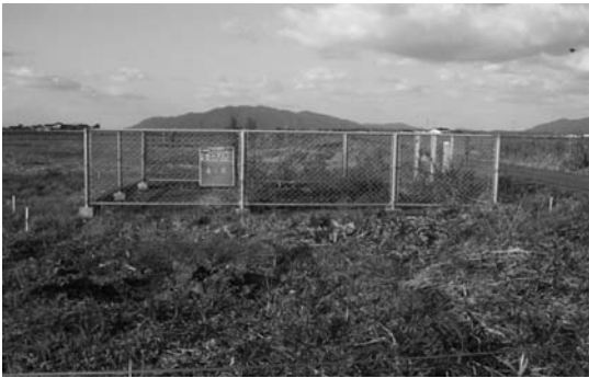
写真-9 流量計室撤去前
