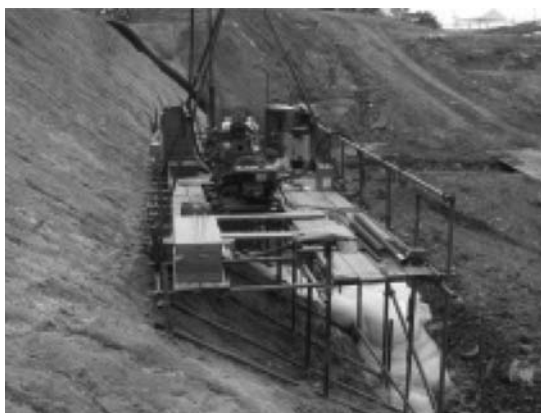
写真-6 気泡ボーリングの施工状況
