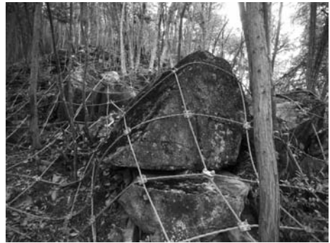
写真-4 ロープ伏工施工後状況
