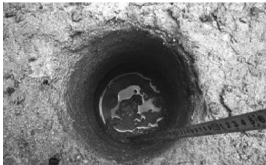
写真-5 現場透水試験状況
