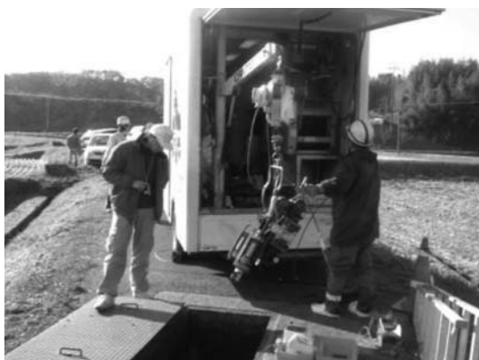
写真-5 自走式TVカメラ設置状況
