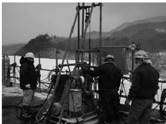
写真-3 グラウチング施工状況
