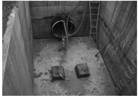
写真-6 充填状況
