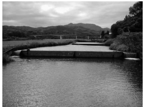
写真-4 大野川幹線用水路
