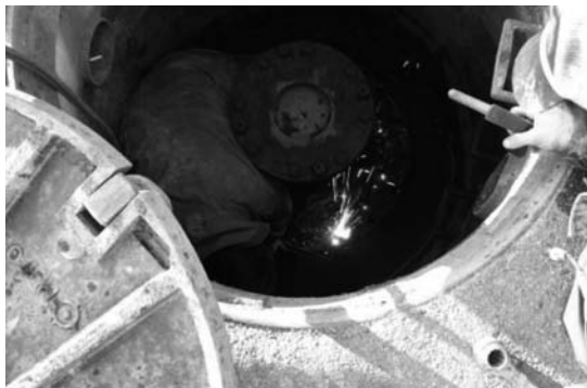
写真-9 鉄製ボルトの切断
