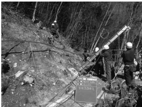
写真-12 支柱設置状況
