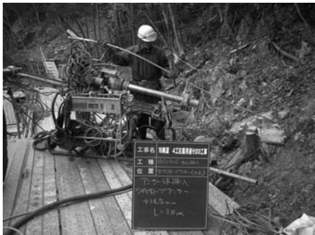
写真-11 アップスロープアンカーの設置状況
