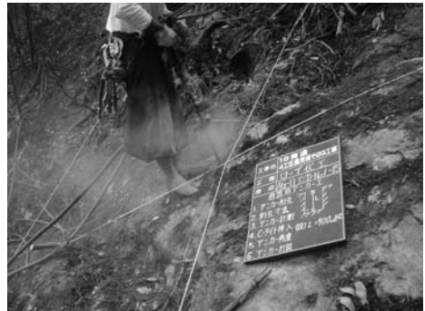
写真-5 岩部アンカー削孔状況
