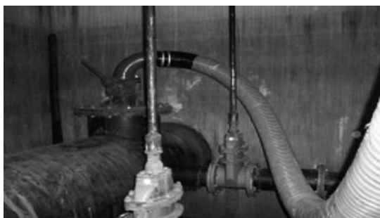
写真-1 充水状況
