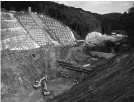
写真-1 施工中の外山ダム (下流から上流を望む)
