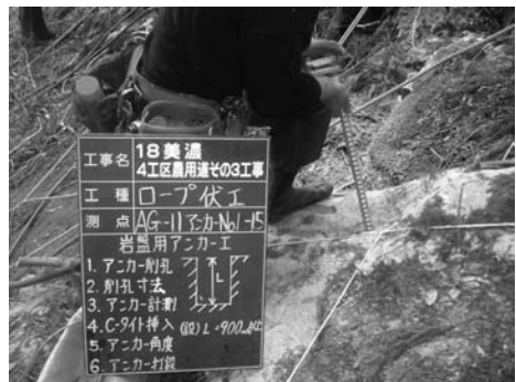
写真-6 岩部アンカー挿入状況
