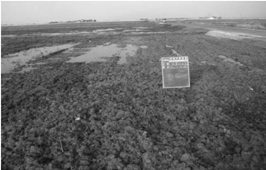
写真-10 流量計室撤去後
