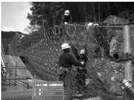
写真-13 リングネット設置状況
