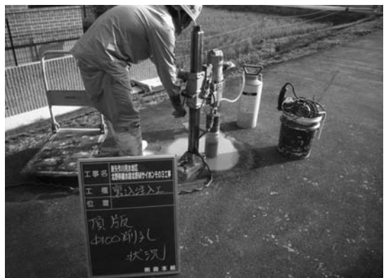
写真-4 注入孔及び確認孔削孔
