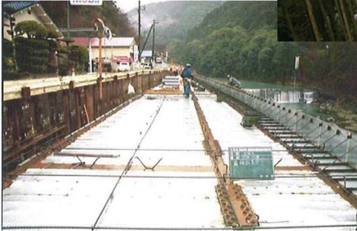
床版鋼製捨型枠の施工例
