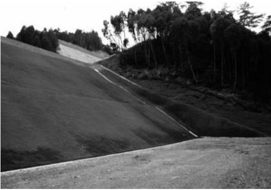
写真-4 吹付完了時法面状況
