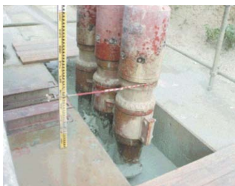
固化液注入時の状況
