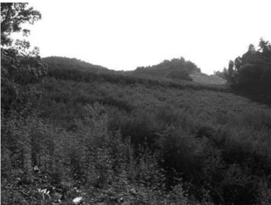
写真-6 施工後1年経過状況
