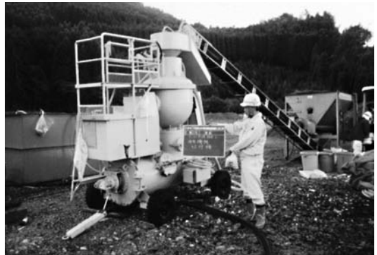
写真-2 吹付材料の投入状況
