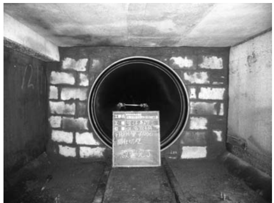
写真-3 間仕切壁設置状況
