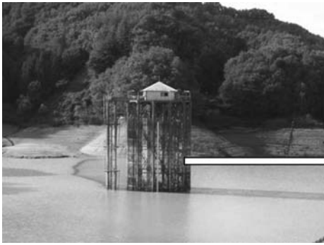
写真-1 取水塔全景
