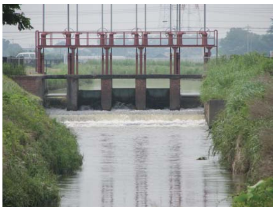
堰全景 (下流より望む)
