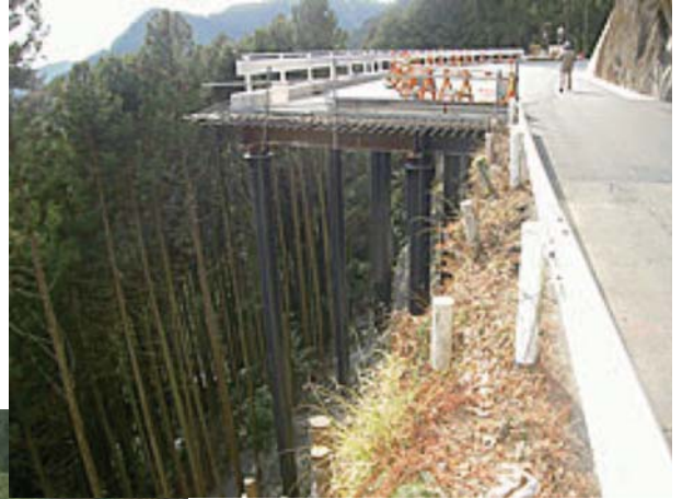
現道確保し道路拡幅した事例
