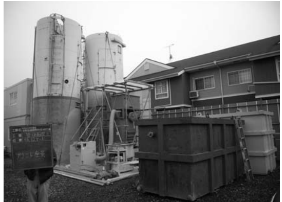
写真-2 注入プラント設置状況
