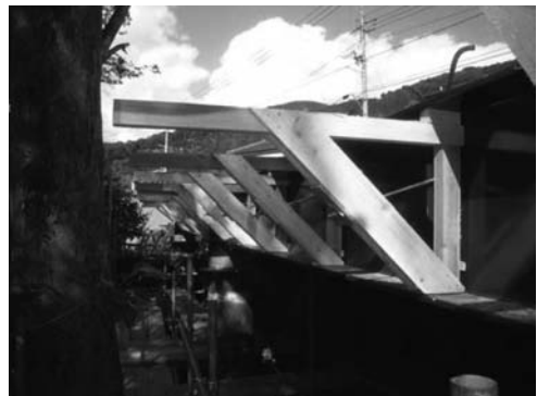
写真-3 張出し部型枠支保工の参考例
