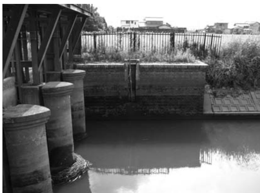
写真-10 右岸取水口
