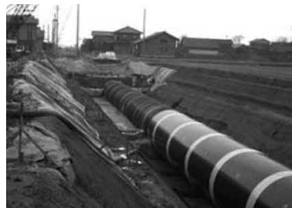
写真-1 オープン開削工法
