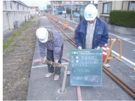
エアモルタル注入
