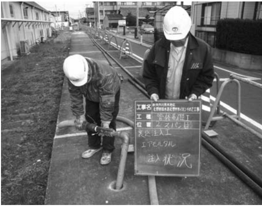
写真-5 エアモルタル注入
