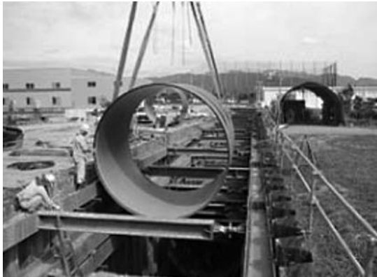
写真-2 矢板工法
