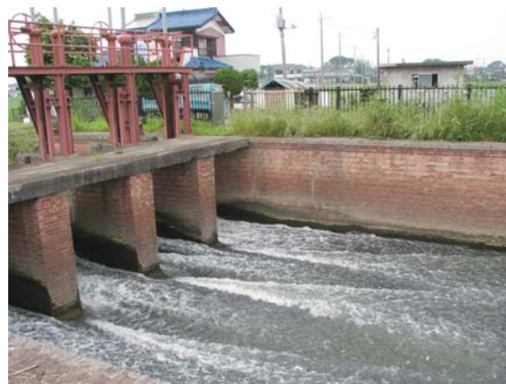
堰下流右岸より望む
