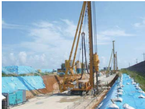
SMW機による施工状況
