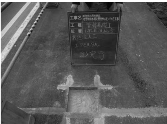
写真-6 エアモルタル充填確認
