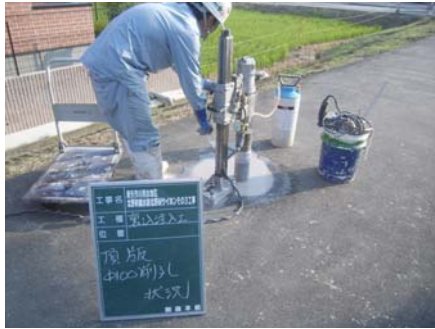
注入孔及び確認孔削孔
