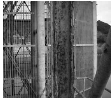
写真-2 鋼材の発生状況
