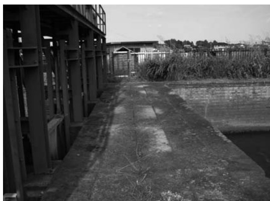
写真-8 渡橋右岸より望む
