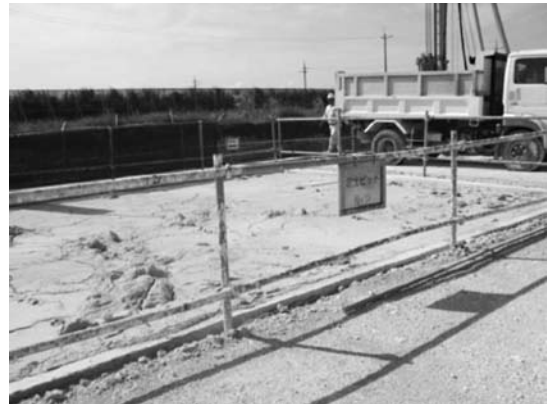
写真-4 汚泥の養生状況
