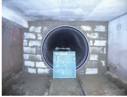
間仕切壁設置状況
