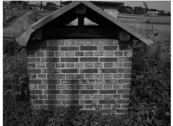
写真-2 格納小屋
