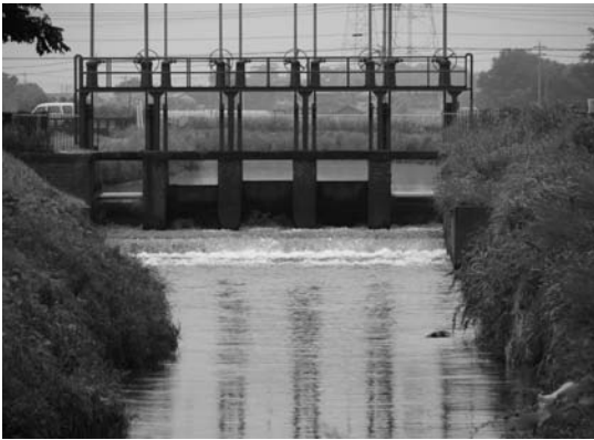
写真-1 堰全景（下流より望む）
