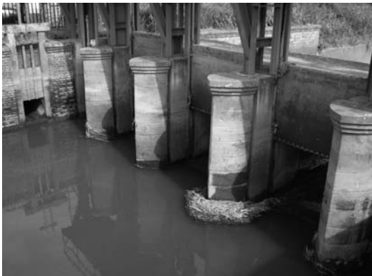
写真-4 堰の水切り状況
