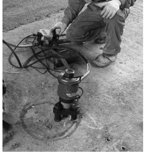
写真-5 浮上防止アンカー引抜試験
