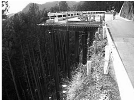
写真-1 現道確保し道路拡幅した事例
