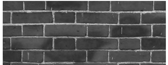
写真-6 フランドル積み (富岡製紙工場)
