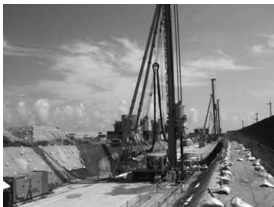
写真-2 SMW機による施工状況
