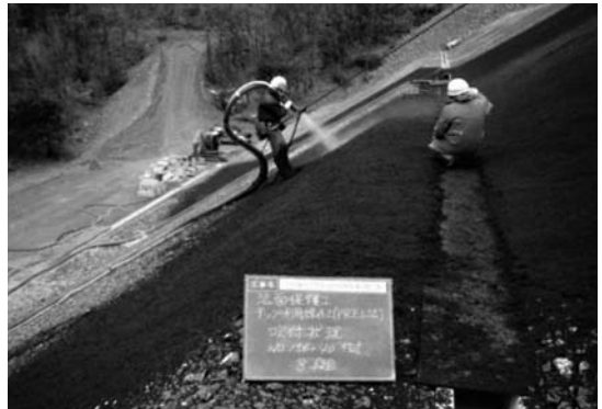
写真-3 吹付状況
