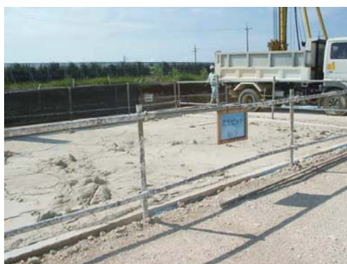
汚泥の養生状況
