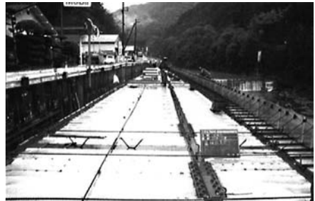
写真-2 床版鋼製捨型枠の施工例
