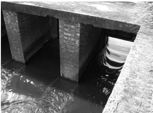
写真-5 煉瓦造りの支柱状況
