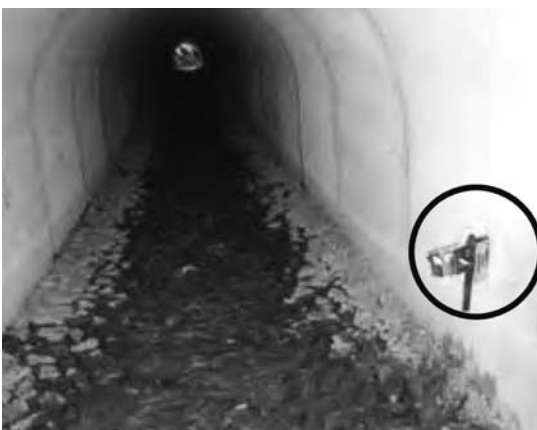
写真-6 撮影装置設置状況②
