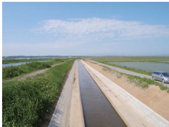
生田排水路 (完成後)
