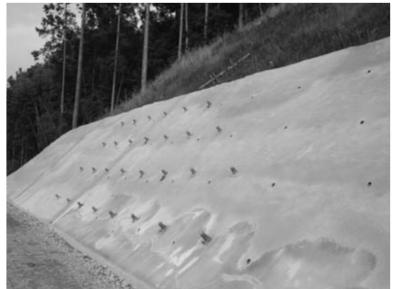
写真-10 ロックボルト施工状況
