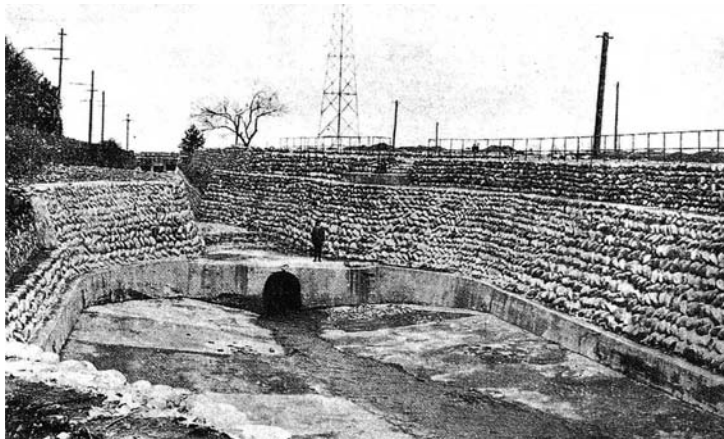
写真-5 旧宮竹用水路沈砂池(昭和25年3月完成。能美市岩本町)
