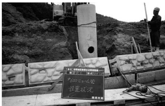
写真-3 巣穴施工時状況
