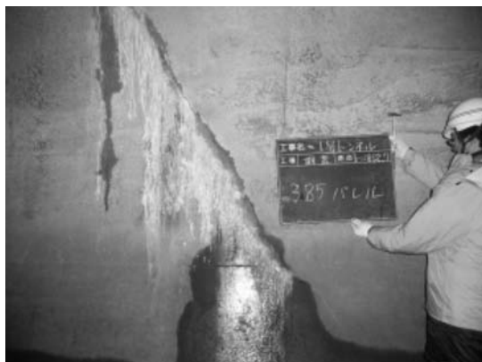
写真-2 トンネル内の状況
