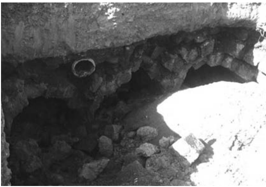
写真-3 旧宮竹用水取水口（アーチ形水路3本）
