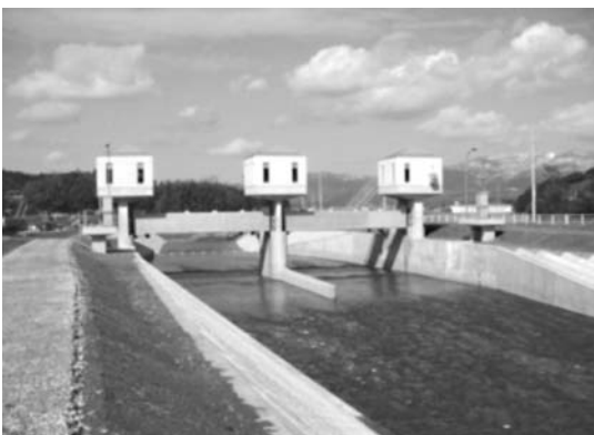
写真-1 小倉川頭首工（上流から望む全景）
