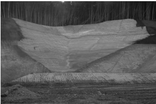
写真-2 暫定法面保護工
