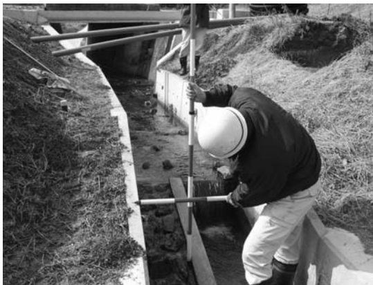
写真-2 水路改修工事区外上流側魚道スロープ
