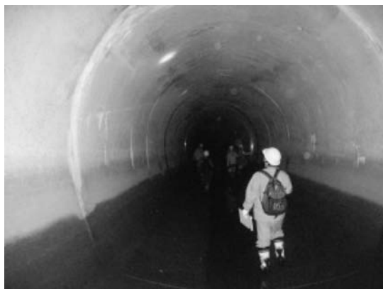
写真-1 目視点検の状況
