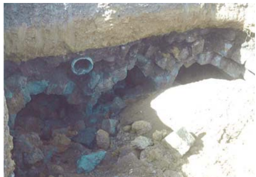
旧宮竹用水取水口 (アーチ形水路3本)
