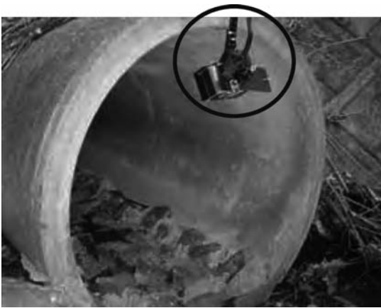
写真-5 撮影装置設置状況①
