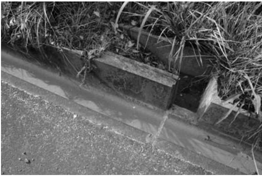
写真-3 這い上がり側溝
