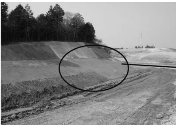
写真-5 右岸仮締切堤の左岸法面
