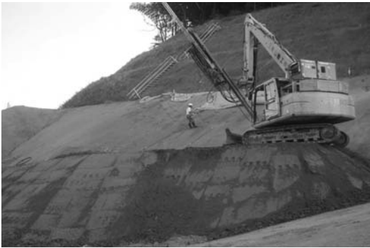
写真-8 ロックボルト打設状況
