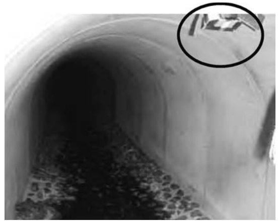
写真-7 撮影装置設置状況③
