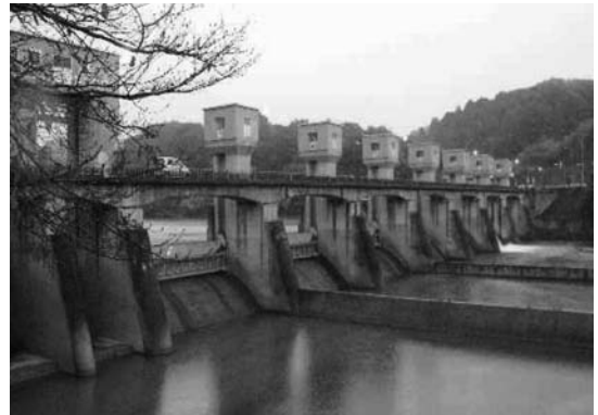
写真-3 C頭首工
