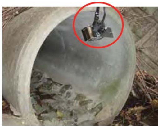
撮影装置設置状況
