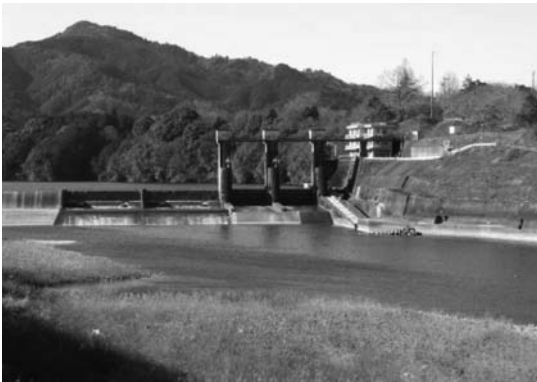
写真-2 E頭首工
