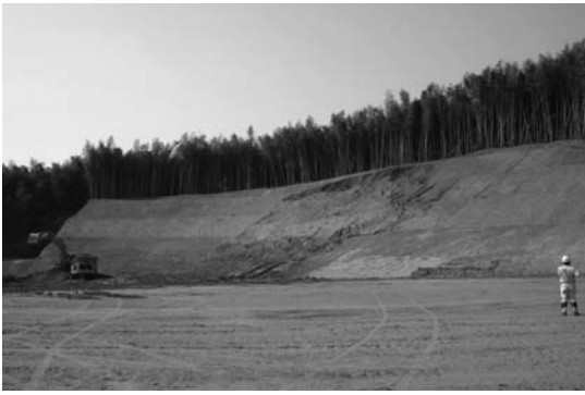
写真-1 すべり状況
