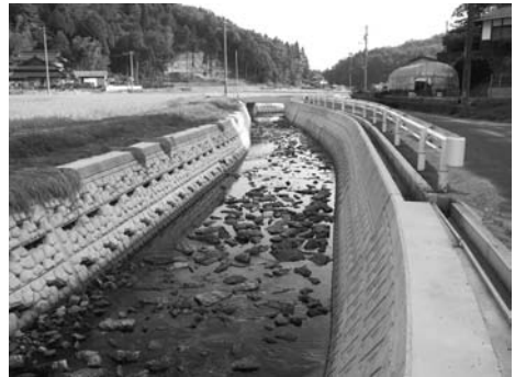
写真-5 水路改修後 状況写真(H19.9月撮影)
