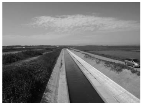
写真-4 生田排水路（完成後）
