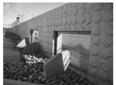
魚道モニタリング施設事例 （石部頭首工）
