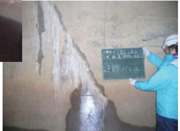
トンネル内の状況
