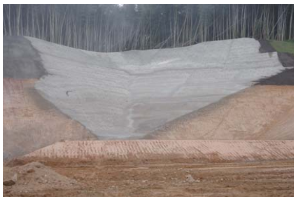
暫定法面保護工
