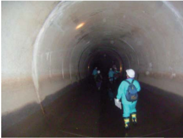
目視点検の状況
