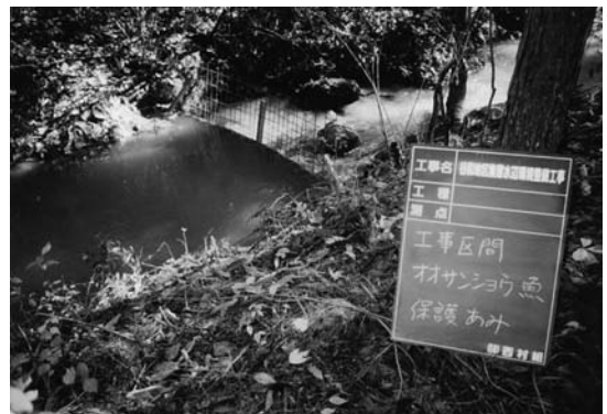
写真-1-3 オオサンショウウオ保護あり設置状況
