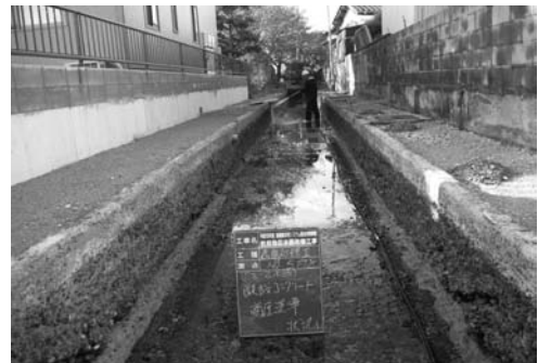
写真-5 既設水路の洗浄状況
