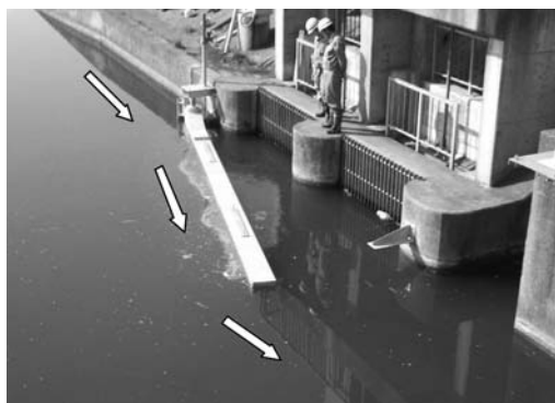
写真-8 平水時における浮遊性塵芥防止装置
