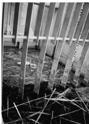
写真-5 人力式除塵スクリーンにおける浮遊性塵芥対策
