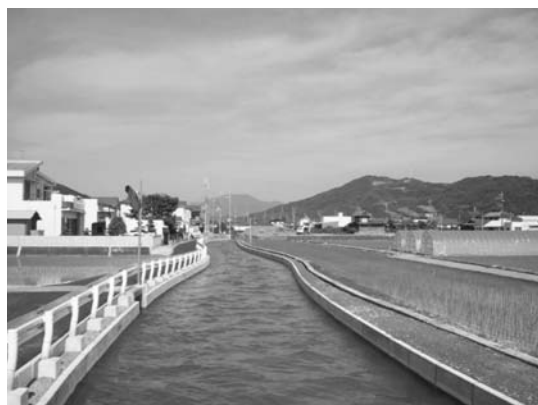
写真-2 紀の川左岸幹線水路（下流より）
