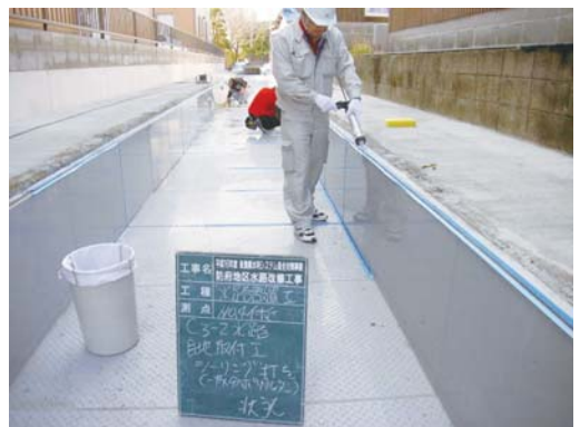
目地取付状況
