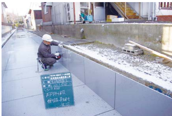
FRPM板取付状況 (側壁)
