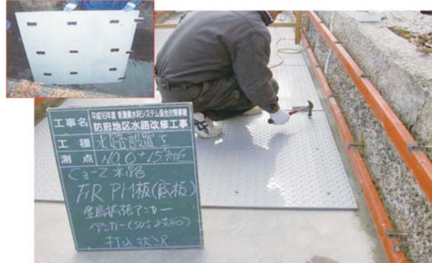
FRPM板取付状況 (底板)
