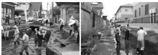
写真-2 農業用水路の維持管理状況
