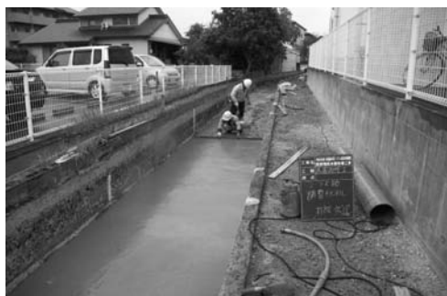
写真-7 調整モルタル打設状況
