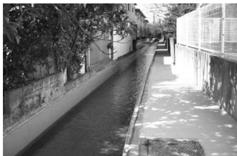
写真-15 完成・通水状況
