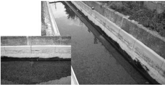
写真－16 通水1年後の状況
