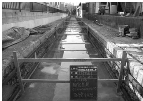
写真-9 固定金物取付状況
