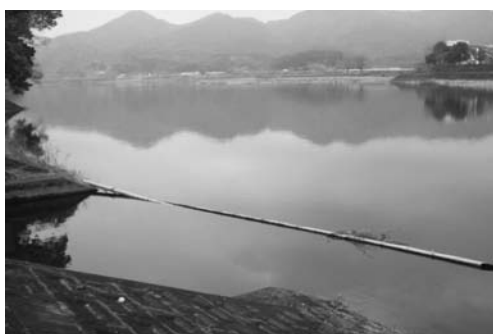
写真-4 竹を利用した浮遊性塵芥の軽減
