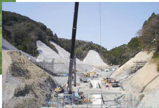
底樋部分施工状況
