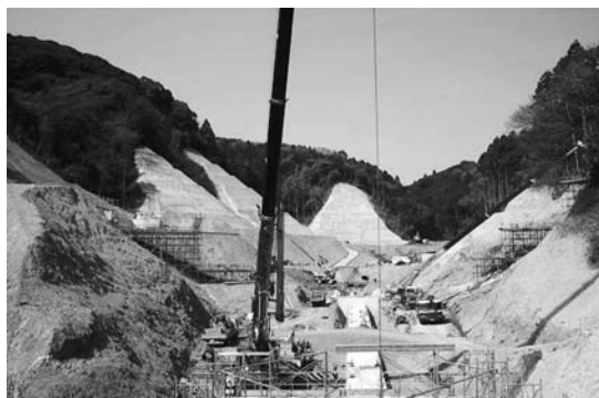
写真-1 底樋部分施工状況
