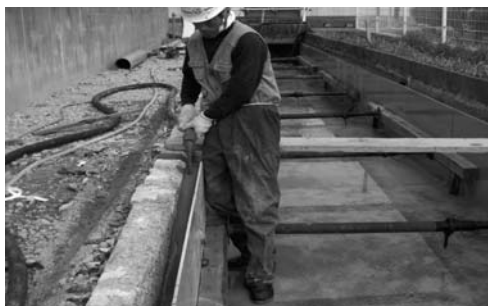
写真-13 空隙充填状況（側壁）
