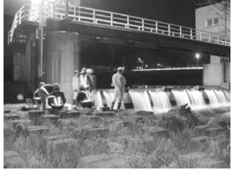
写真-4 調査状況
