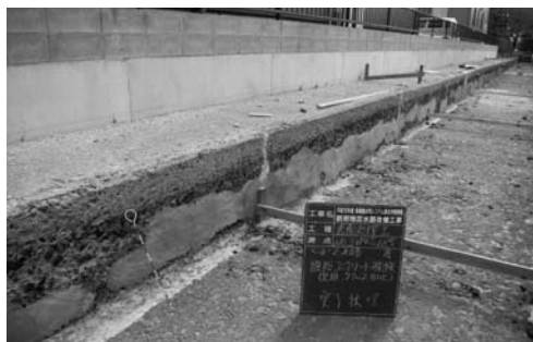
写真-6 壁面補修状況
