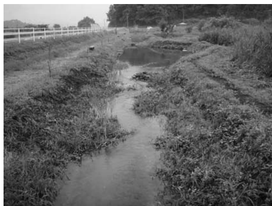
写真-1 No.①水路（完了後）
