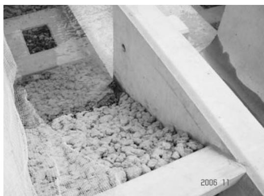
写真-7 スロープ部
