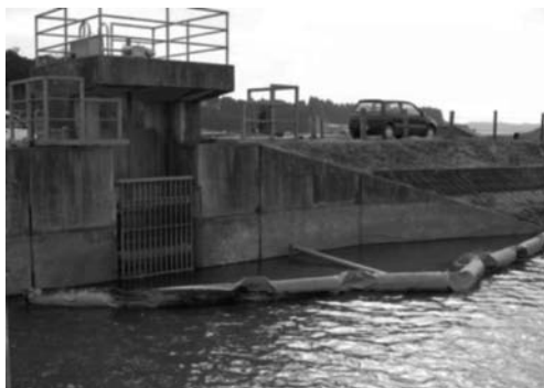
写真-3 オイルフェンスの設置状況
