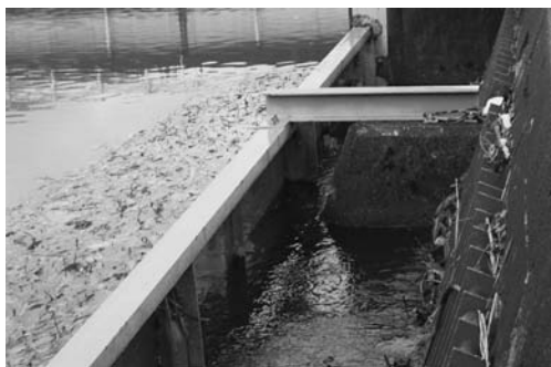
写真-6 固定式遮蔽板による浮遊性塵芥の流入防止
