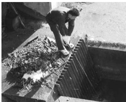
写真-2 塵芥の人力掻き上げ作業
