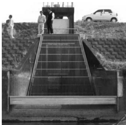
写真-7 可動式遮蔽板による浮遊性塵芥の流入防止
