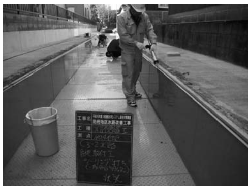
写真-14 目地取付状況
