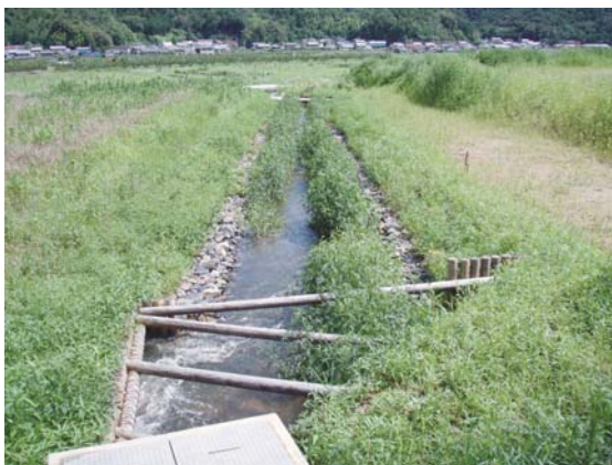
No.⑥水路 (完了後)
