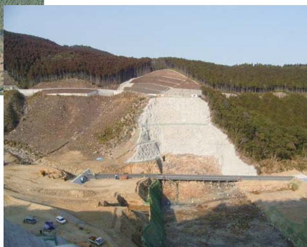
切原ダム施工状況
