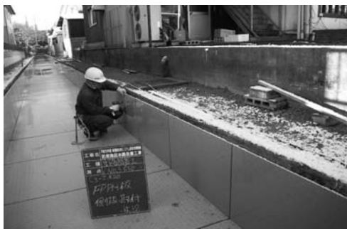
写真-12 FRPM板取付状況（側壁）
