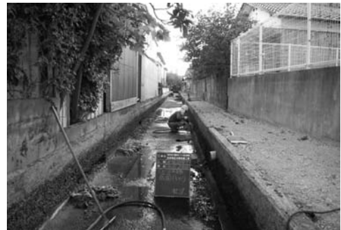
写真-4 コンクリートはつり状況
