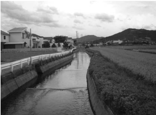
写真-1 紀の川左岸幹線水路（下流より）
