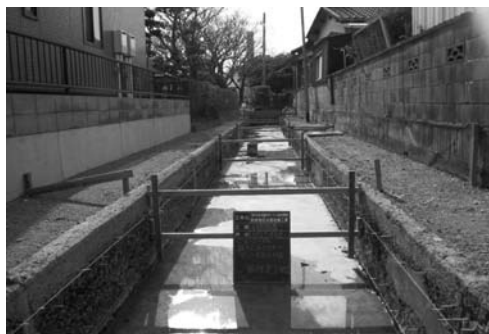
写真-8 アンカー取付状況 (側壁)
