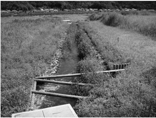
写真-2 No.⑥水路 (完了後)
