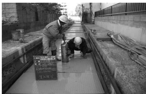
写真-11 空隙充填状況 (底板)
