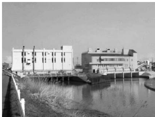
写真-1 既設機場(左)と新設機場(右)
