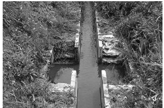
写真-2 現況施設
