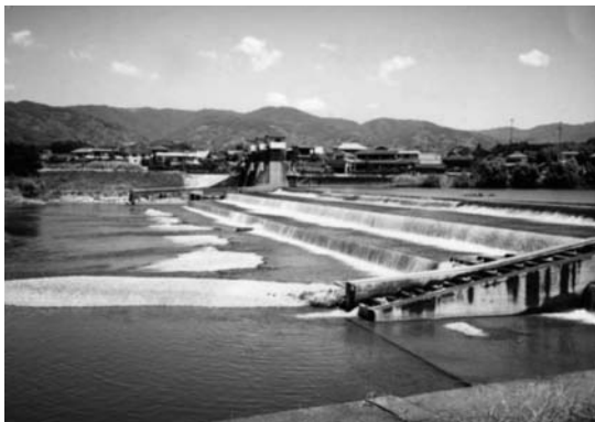
写真-5 国営造成施設紀の川藤崎頭首工 (H19)
