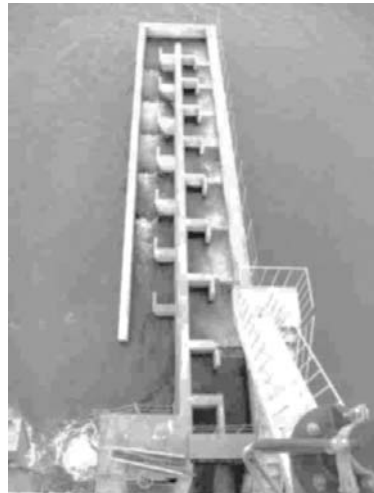
写真-6 改築後の2号魚道
