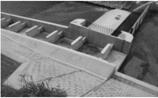
写真-1 火の口頭首工（アイスハーバー型）
