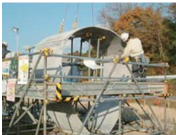
パネル仮組立
