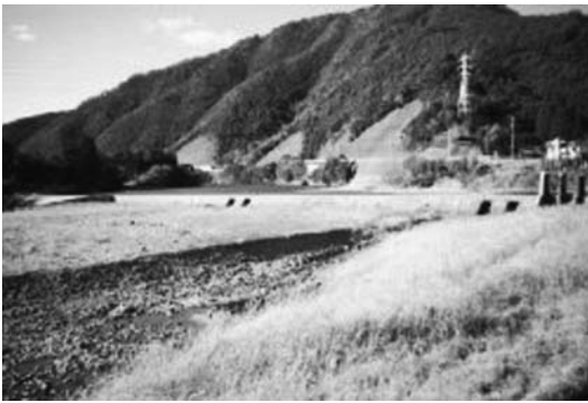
写真-7 小園頭首工 改修前（頭首工全景）※両岸取水
