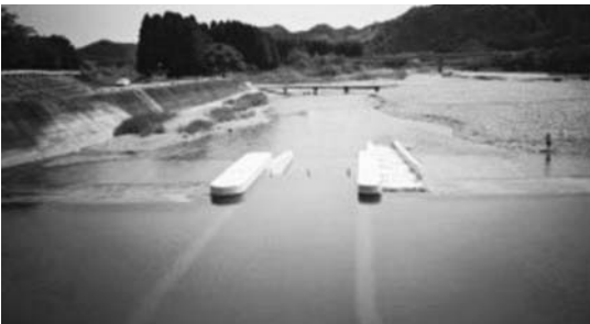
写真-6 小園頭首工魚道上流より（ミオ筋の状況）
