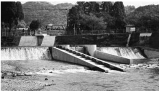
写真-8 小園頭首工 改修後（左岸側魚道）
