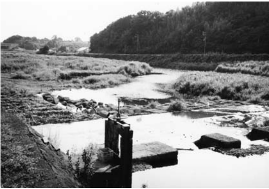
写真-1 みお筋河床低下
