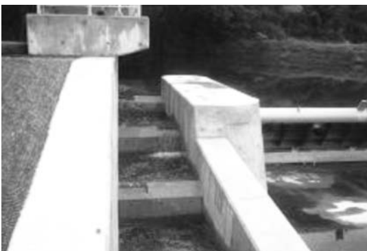
写真-3 木場田頭首工（階段式）
