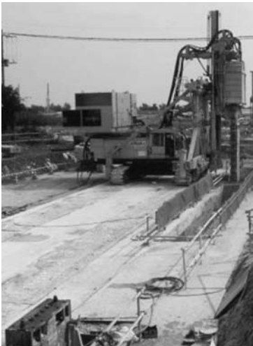
カッターポスト建込み
