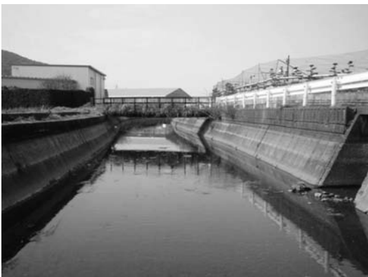
写真-1 改修前の開水路
