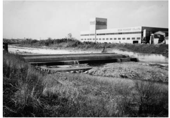
写真-9 朝明頭首工
