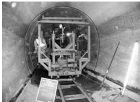
※2 アーチ部パネル設置
