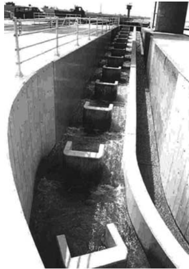
写真-5 改築後の1号魚道
