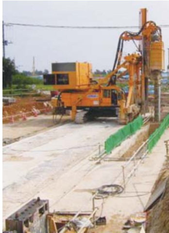
カッターポスト建込み
