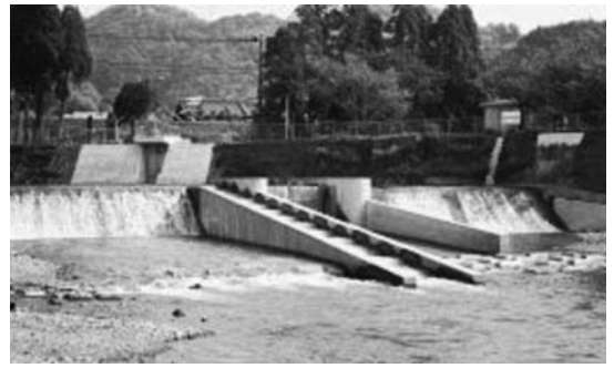
写真-2 小園頭首工（階段式）
