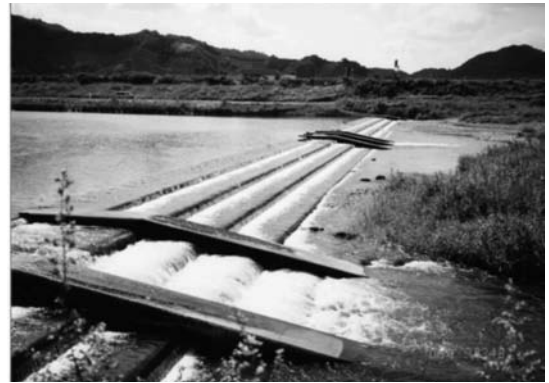
写真-10 県営有田川工業用水堰堤（H18）
