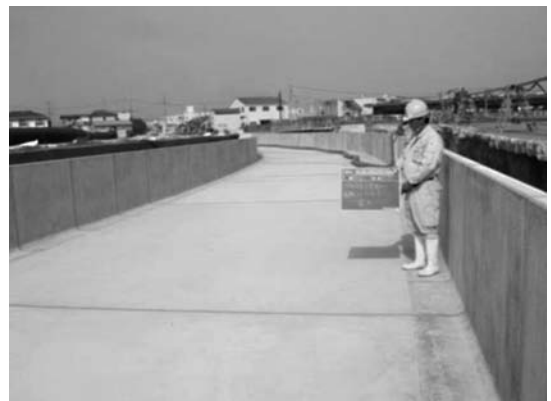
写真-2 水路用L形による改修後の開水路
