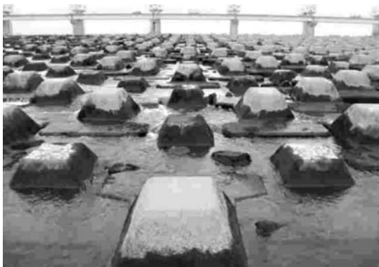
写真-4 コンクリートブロックの突起
