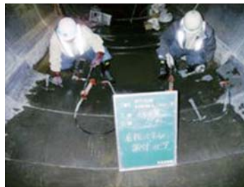
インバートパネル設置
