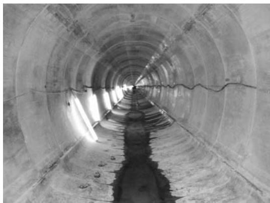
写真-3 工事完成
