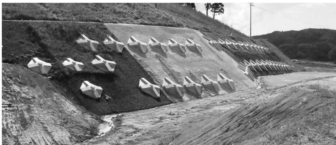
写真-5 対策工の施工完了
