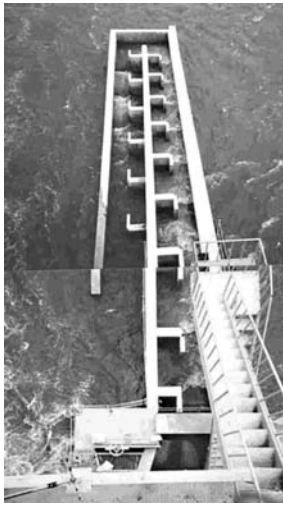
写真-7 改築後の3号魚道
