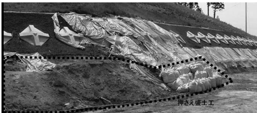
写真-4 押さえ盛土の施工
