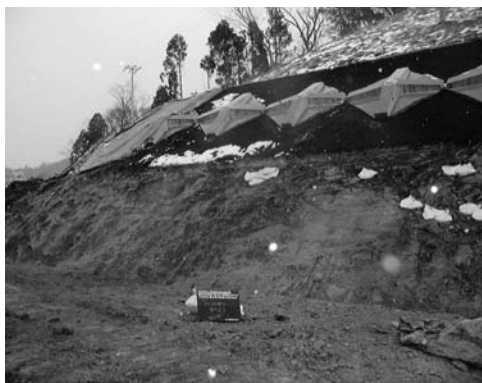
写真-1 法面整形完了
