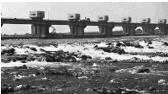
写真-2 改築前の利根大堰護床工
