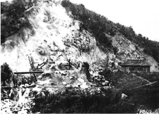
写真-1 御船川を渡る木の樋 開削初期の枝下用水
