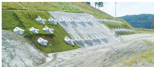
対策工の施工完了
