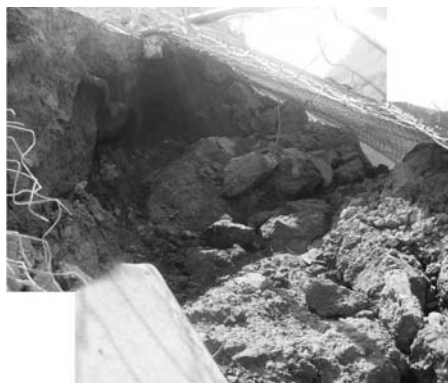
写真-2 表層崩壊の発生
