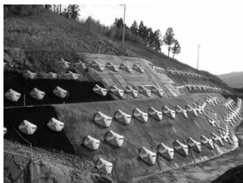
写真-7 1段目法面の施工
