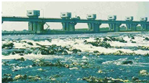
改築前の利根大堰護床工
