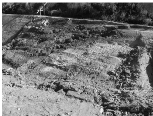
写真-6 断層破碎帯
