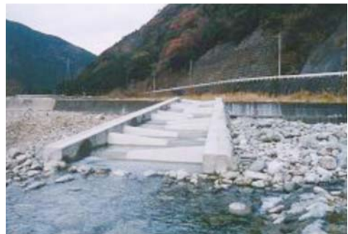
鮎の遡上も確認されたハーフコーン式魚道 (山梨県佐野川)
