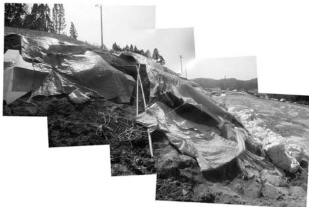
写真-3 表層崩壊の発生
