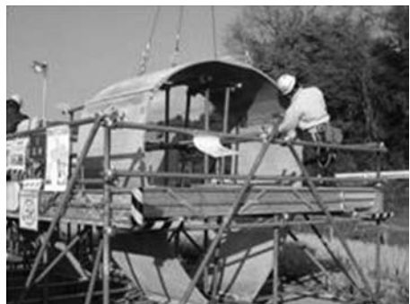
パネル仮組立
