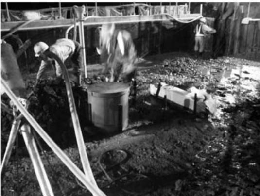
写真-4 埋設計器設置状況(夜間打設)
