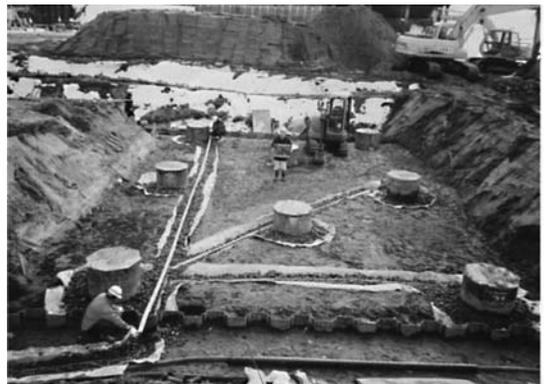
写真-4 暗渠排水設置状況（堰柱部、一次施工：H15.1）
