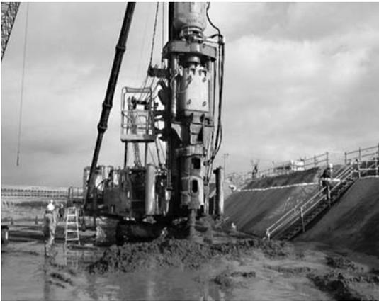
写真-2 鋼管杭打設状況 (一次施工：H14.12)
