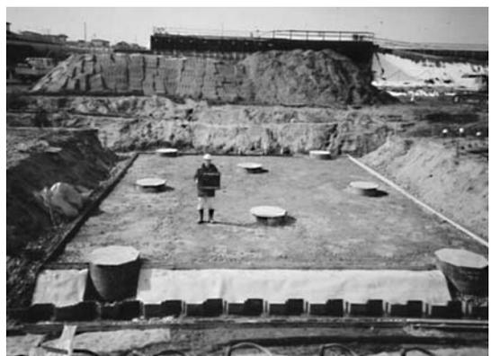
写真-5 基礎砕石設置状況（堰柱部、一次施工：H15.1）
