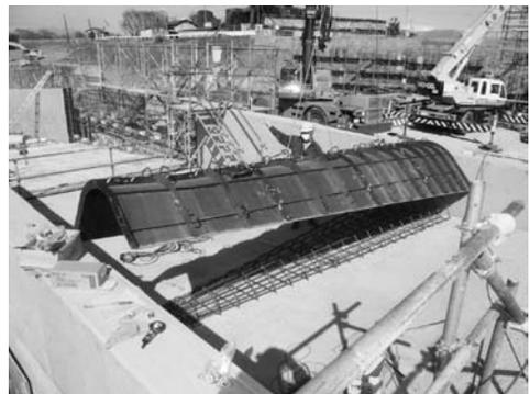
写真-4 鋼製型枠の設置
