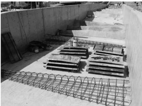
写真-3 ハーフコーン用鉄筋のセット
