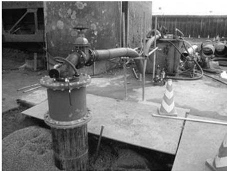
写真-6 スーパーウェルポイント設置完了 (二次施工)
