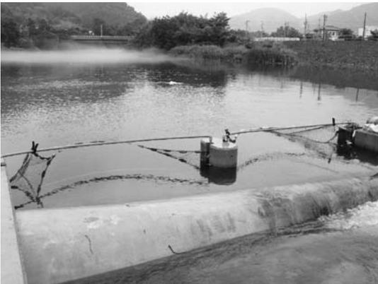
写真-9 魚道出口に設置した定置網
