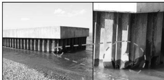
写真-1 導流堤先端部鋼矢板破損状況
