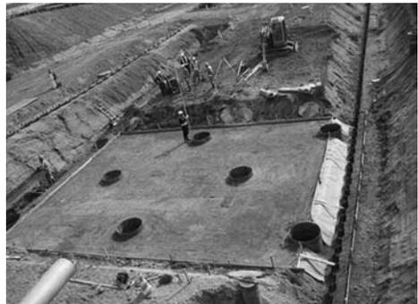
写真-9 堰柱部床付け状況 (二次施工)
