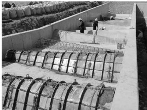
写真-5 コンクリート打設直後
