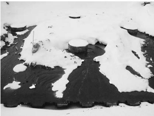
写真-3 鋼管杭からの湧水状況 (一次施工：H15.1)
