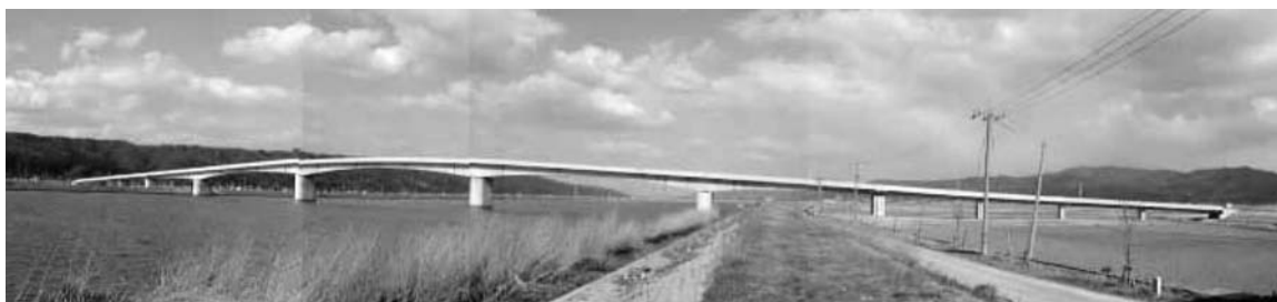
写真-10 邑知潟大橋全景
