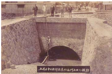
中谷川水門 明治45年改修工事当時
