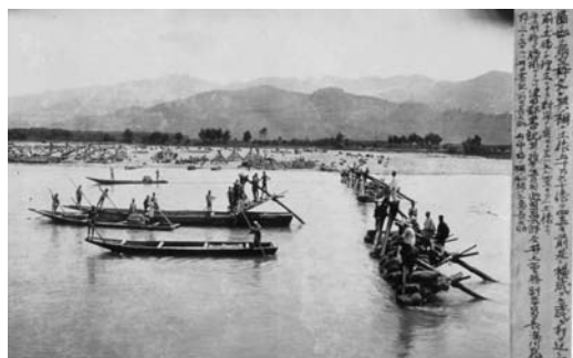
写真-2 馬枅設置 明治42年
