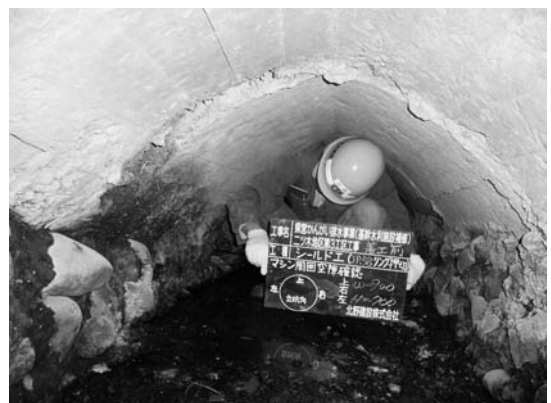
写真-2 トンネル内部の状況
