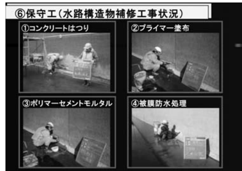
図-11 保守工 (水路構造物補修工事状況)
