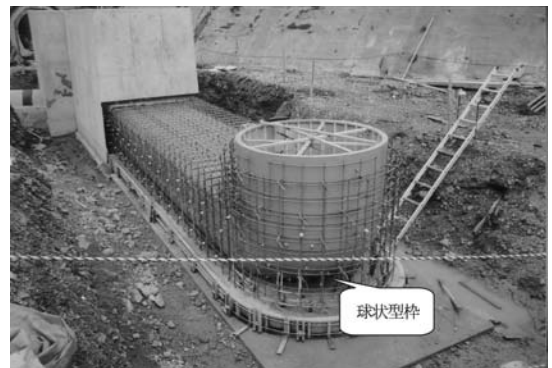
写真-4 球状型枠設置状況（円形導水路部）
