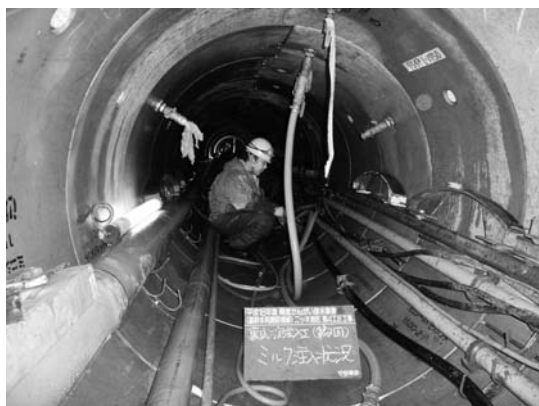
写真-7 セメントミルク注入状況
