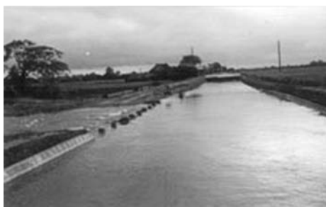
写真-5 右岸幹線水路にある昭和30年代の「野越し」の様子
