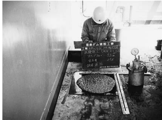
写真-9 スランプフロー測定状況
