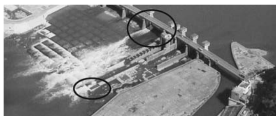
写真-5 舟通し部乱流発生状況
