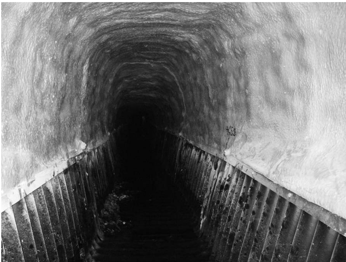
写真-9 完成断面
