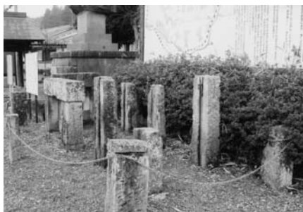
松岡公園に移築された当初の水利施設
