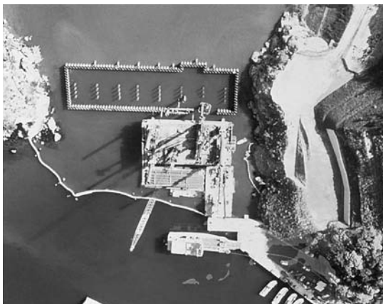
写真-4 鋼管矢板による一次締め切り完了状況
