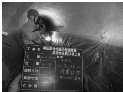
写真-6 ウレタン表面補強
