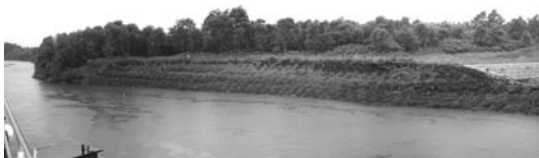
写真-6 河岸部洗掘防止工経過状況
