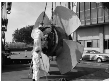
写真-3 ポンプ羽根車分解点検状況 (口径 4,200\text{mm} )
