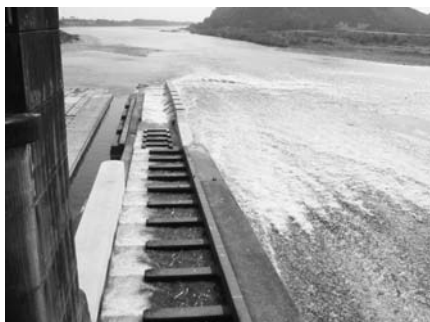
写真-8 左岸魚道 (1号制水門小開度時の流況)
