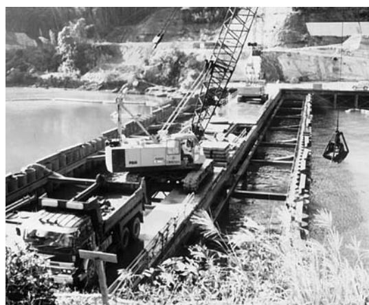
写真-6 締め切り内の掘削状況
