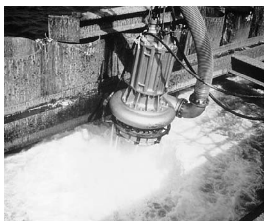
写真-7 スラッシュジェットと取り付けした攪乱ポンプ (堆積土をほぐす為使用)
