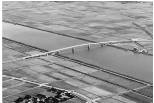
写真-1 邑知潟大橋全景
