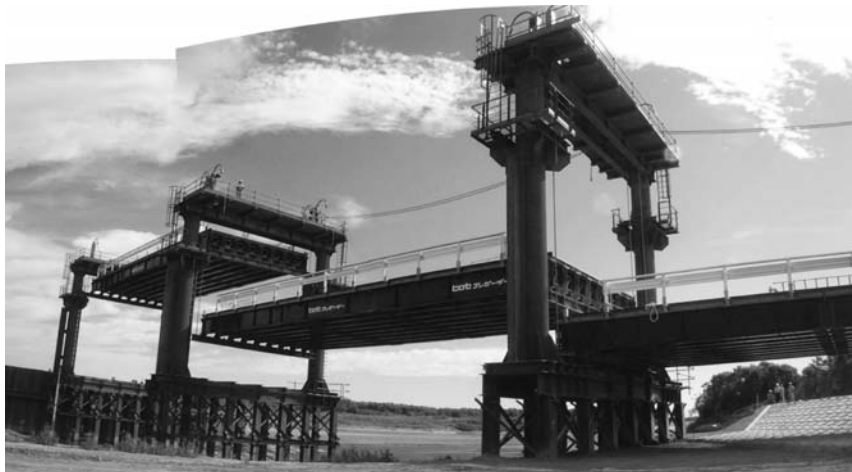
写真-1 仮栈橋工のジャッキアップ作業状況越水時安全対策
