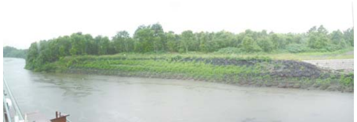
河岸部洗掘防止工経過状況
