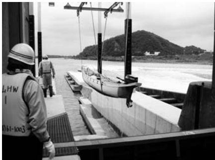
写真-11 舟通しクレーン運用状況
