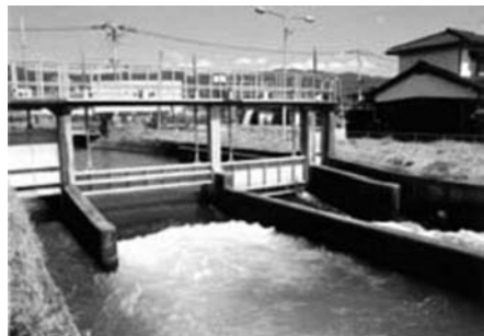
写真-3 駄市河原分水工
