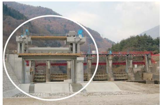
I 期工事完了後の梓川頭首工 (既設頭首工下流、約40mに完成した土砂吐水門)
