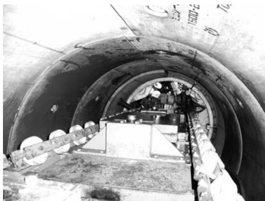
写真-6 セグメント組立状況
