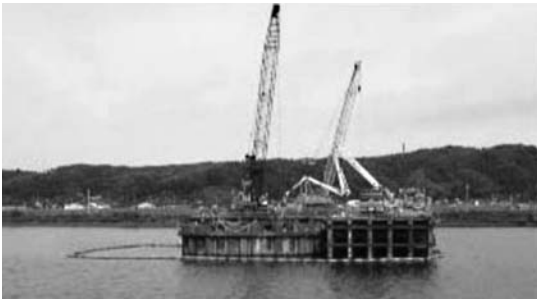
写真-7 シルトプロテクター設置状況
