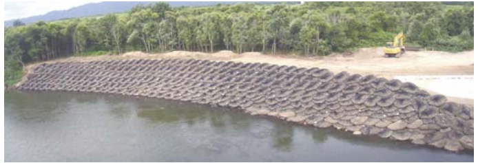
河岸部洗掘防止工設置状況
