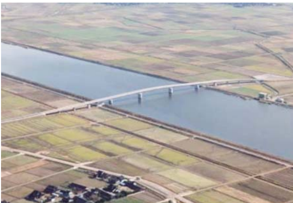
邑知潟大橋全景
