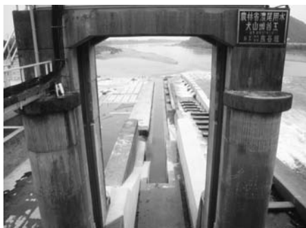
写真-9 舟通し下流部の乱流の改善状況
