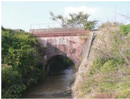
小庭谷川渡井 明治42年改修
