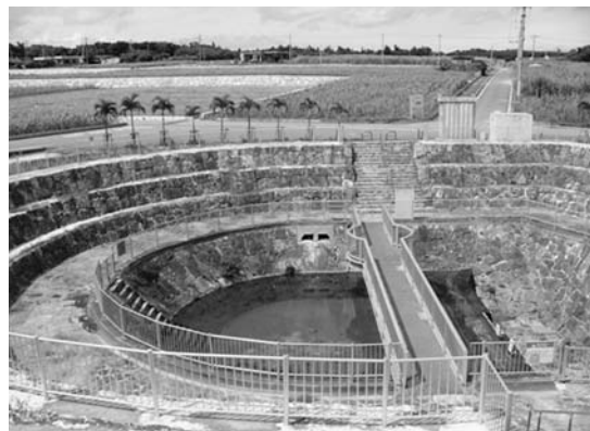
写真-3 水位水質監視施設
