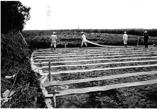
写真-2 地下水移動工 (水平排水材の敷設状況)
