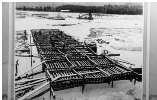
写真-3 木工沈床組立 大正15年
