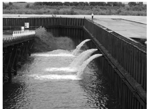
写真-7 越水前の仮締切内導水
