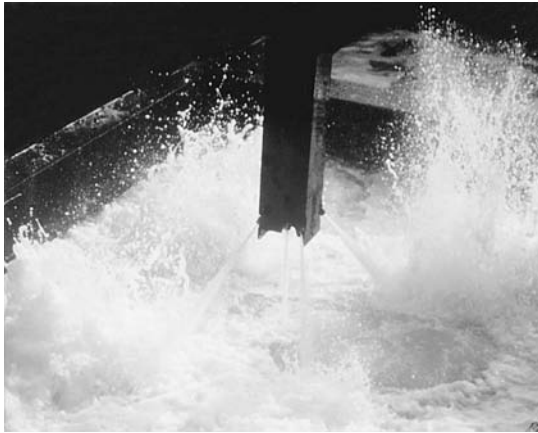
写真-8 H型鋼に取り付けたスラッシュジェット (鋼管際の掘削に使用)
