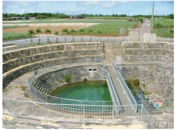
水位水質監視施設
