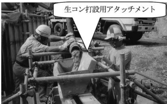
写真-6 生コン打設状況
