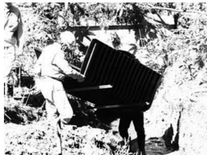
写真-4 U字溝据付
