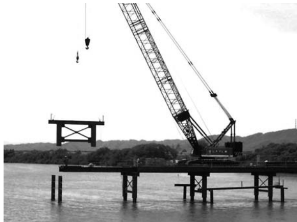
写真-2 作業構台の上部ジャケット施工状況
