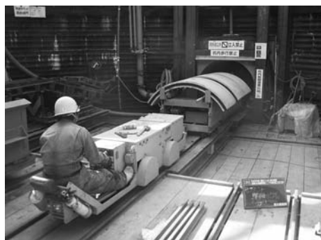
写真-4 セグメント搬入状況
