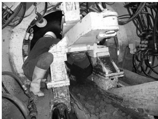
写真-5 土砂搬出状況
