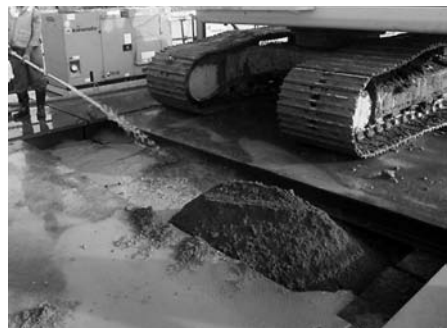
写真-3 中詰土締固め
