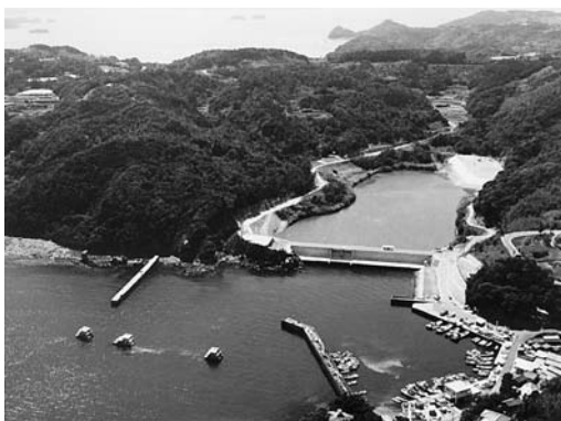
写真-3 竣工直後の全景
