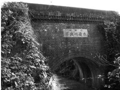
写真-6 木積川渡井 大正2年改修
