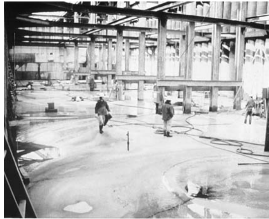
写真-15 ドライアップ直後の締め切り内状況 (鋼管矢板によりほぼ完璧な止水状況)
