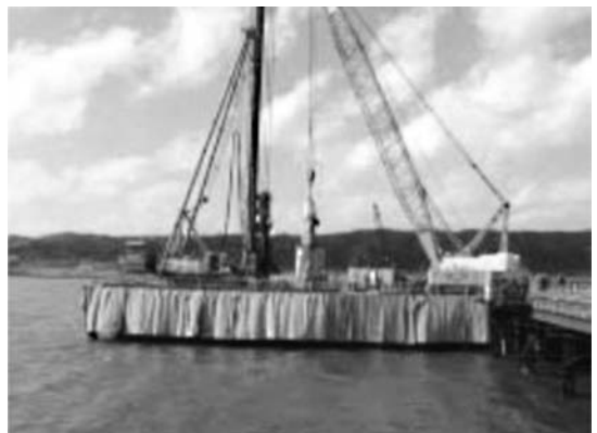
写真-4 構台・油圧ハンマー防音工
