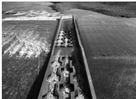
写真-7 右岸魚道 (6号制水門小開度時の流況)
