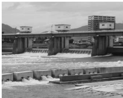
写真-6 制水門3号及び4号フラップ流下状況
