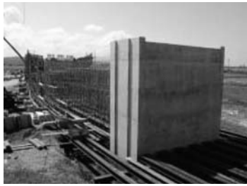
写真-2 橋脚部スリット
