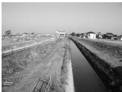
写真-7 市の江川副幹線の百石堤（右側） （左側の堤防に比べて高くなっている）
