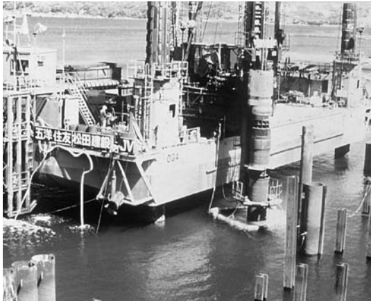
写真-5 ドーナツオーガー機のセット状況
