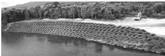
写真-5 河岸部洗掘防止工設置状況
