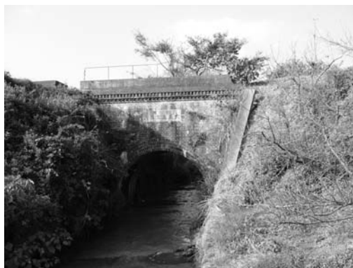
写真-4 小庭谷川渡井 明治42年改修
