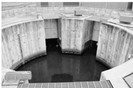
写真-4 巨勢川分水工
