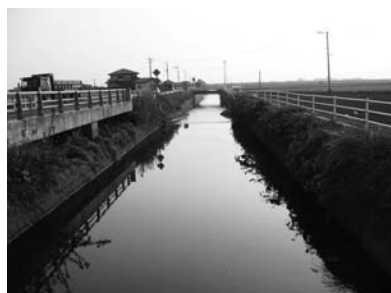
写真-6 現在の「野越し」の様子 現在では「野越し」の上に橋梁が架けられているが、野越し自体は地域の排水慣行の中で変わっていない
