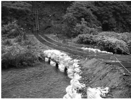
写真-3 仮設道路設置状況
