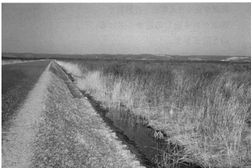
写真-3 プール側溝
