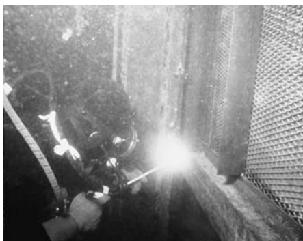
写真-10 型枠の水中溶接状況
