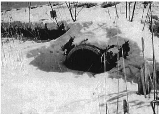
写真-5 小動物のための道路横断暗渠工
