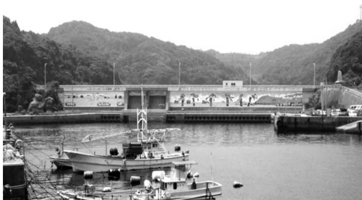
写真-1 堤体前方から見た鷹島ダム（漁船と共存するダム！）
