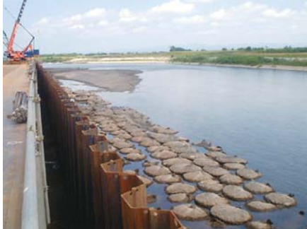
洗掘防止工設置状況
