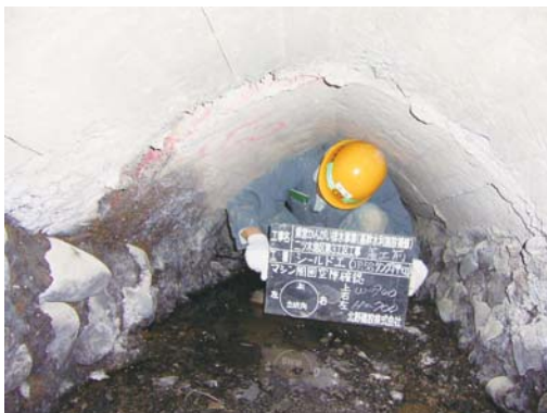
トンネル内部の状況
