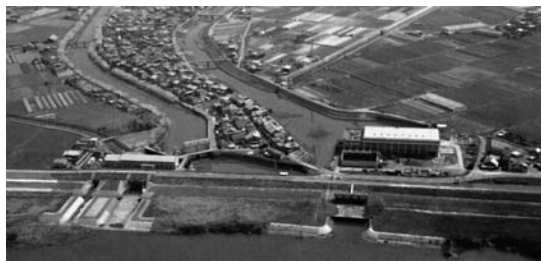
写真-4 左 旧巨椋池排水機場 右 久御山排水機場 2)
