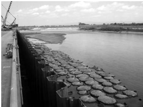
写真-4 洗掘防止工設置状況
