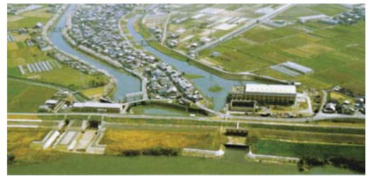
左 旧巨椋池排水機場 右 久御山排水機場
