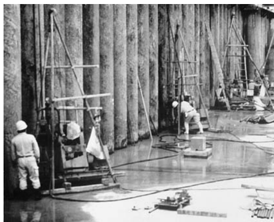
写真-16 海面下10mでのグラウト状況
