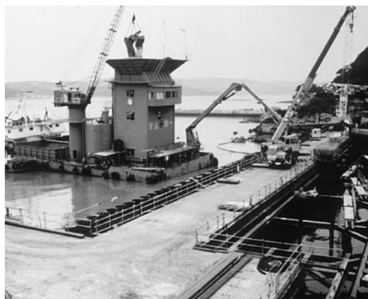
写真-11 水中コンクリート打設状況
