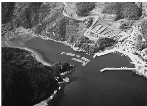
写真-2 着手前全景 (左側の入江が現在のダム敷)
