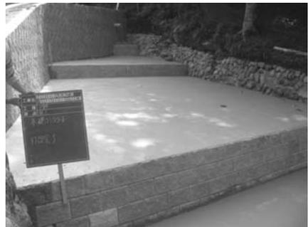
写真-6 コンクリート打設後
