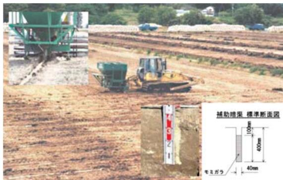
重粘土層改良工（岩手県農業公社方式）による補助暗渠工事。2m間隔に掘られた補助暗渠の溝（幅4cm，深さ40cm）に，モミガラを強制的に圧力をかけて充填する。
