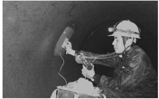
写真-3 縦方向PC鋼線探査
