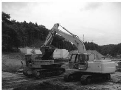
写真-5 初期固化土の解砕・積み込み状況
