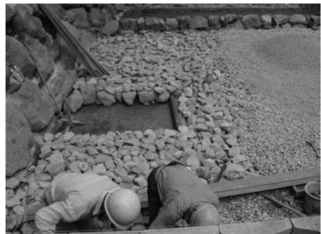
写真-7 心土および作土の施工状況
