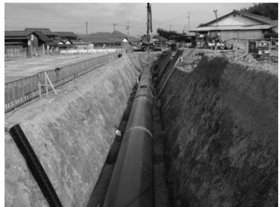
写真-2 併設水路施工状況
