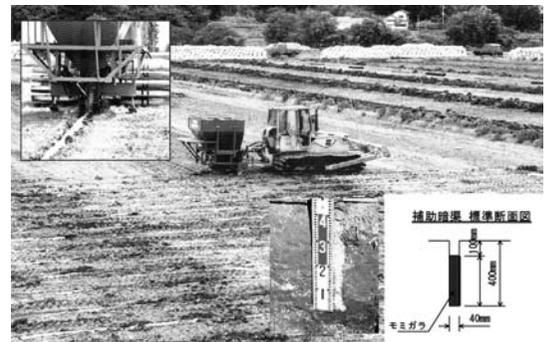
写真-8 重粘土層改良工（岩手県農業公社方式）による補助暗渠工事。2m間隔に掘られた補助暗渠の溝（幅4cm、深さ40cm）に、モミガラを強制的に圧力をかけて充填する。
