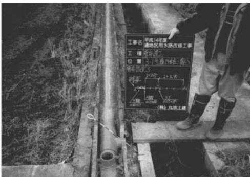
写真-2 MPIF工法施工状況
