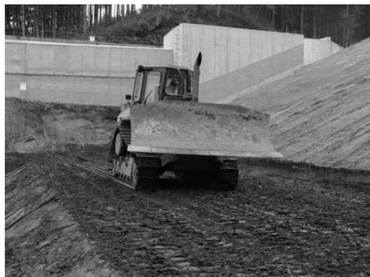
写真-6 15ト<sup>ン</sup>級ブルドーザによる転圧状況
