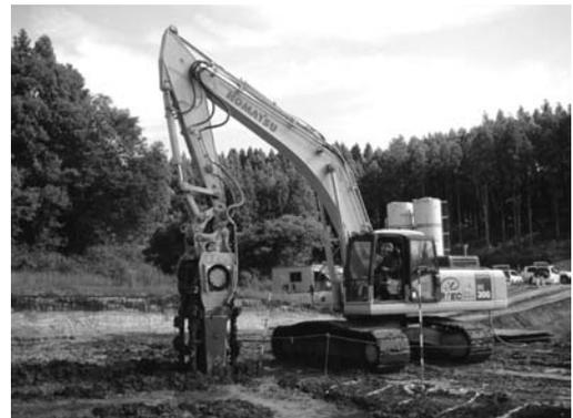
写真-3 底泥土の初期固化状況
