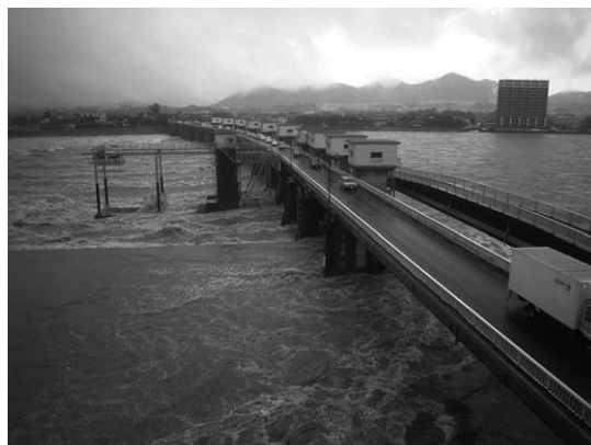
写真-2 洪水状況
