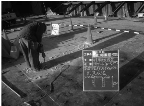
写真-12 ⑦アンカーホール削孔
