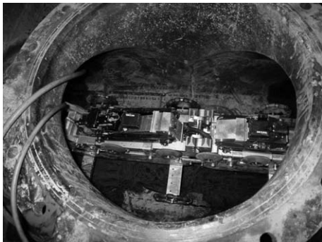
写真-2 設置状況 (検査ロボット)
