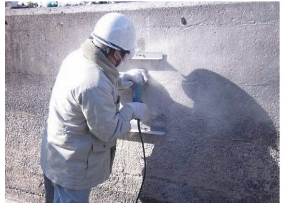
コンクリートカナによる研磨状況
