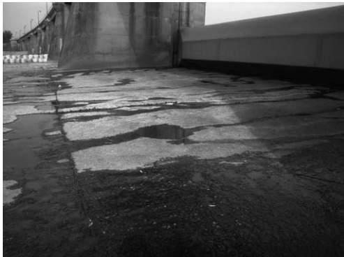
写真-3 耐摩耗板設置前（洪水吐1号）
