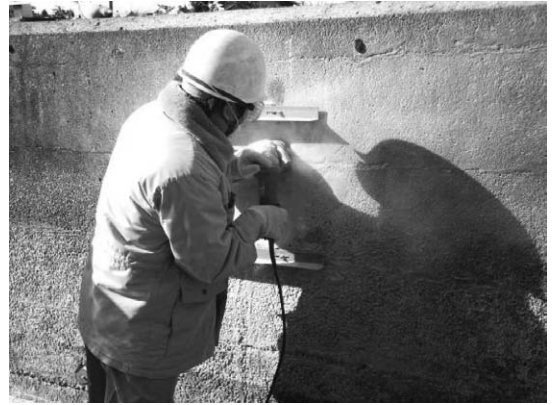
写真-4 コンクリートカンナによる研磨状況
