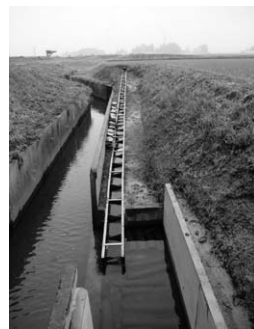
写真-9 加美町 排水路路面（1：20）設置状況
