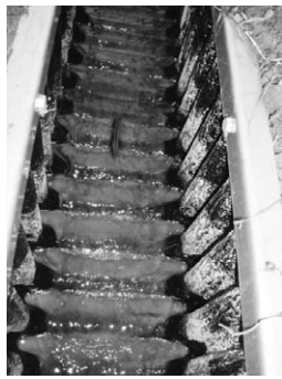
写真-4 遡上状況
