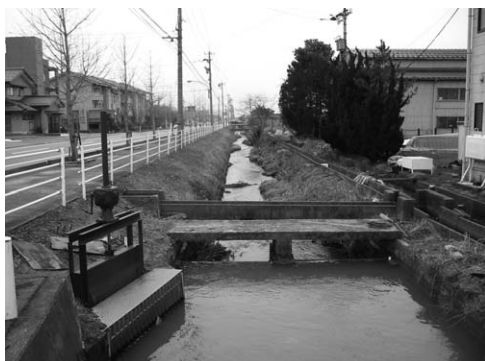
写真-4 土水路合流点→下流
