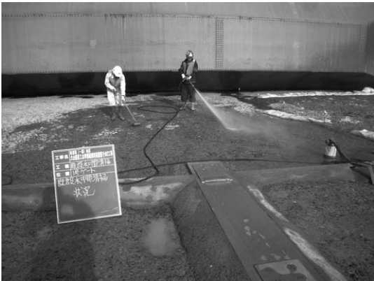
写真-8 ③はつり面洗浄
