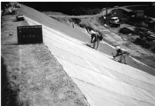
写真-4 植生シート 施工状況
