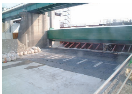
後片付け (施工後)
