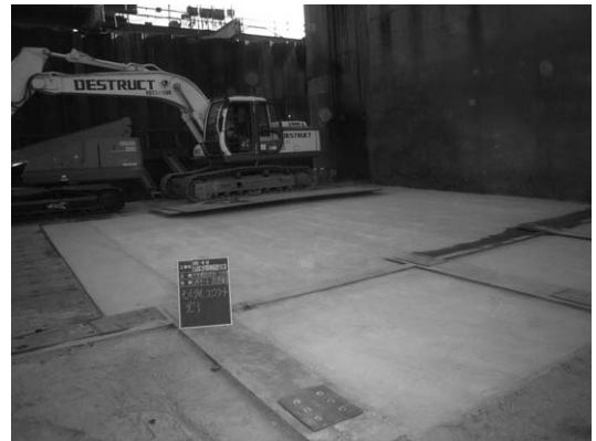
写真-10 ⑤下地処理工完了
