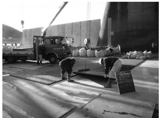
写真-11 ⑥耐摩耗板据付
