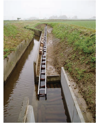
加美町 排水路法面 (1:2.0) 設置状況
