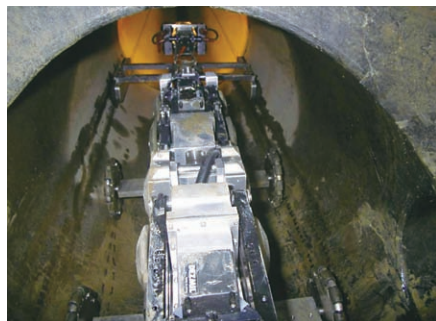
管内走行状況
