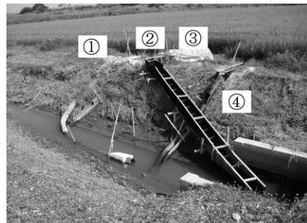
写真-8 伊豆沼3工区 排水路法面(1:2.0)設置状況
