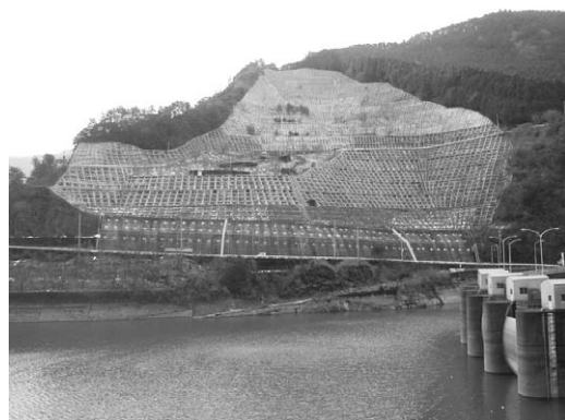
写真-2 大迫ダム左岸法面
