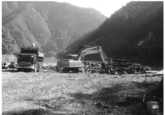
写真-3 流木回収状況
