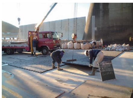
耐摩耗板据付
