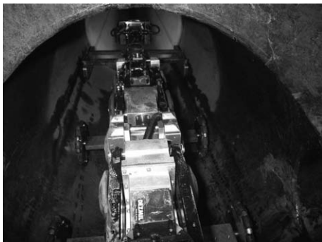
写真-3 管内走行状況
