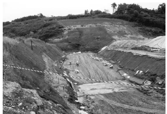
写真-1 左岸コアトレンチ施工状況
