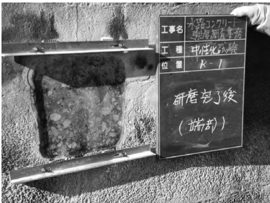
写真-5 研磨終了後フェノールフタレイン溶液による中性化試験
