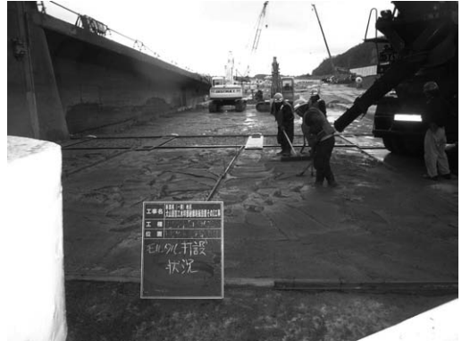
写真-9 ④コンクリート・モルタル打設
