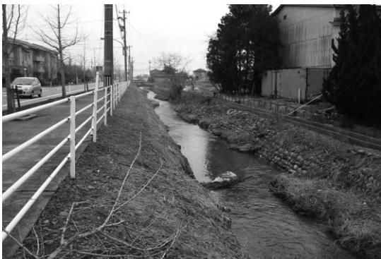
写真-1 水路全景
