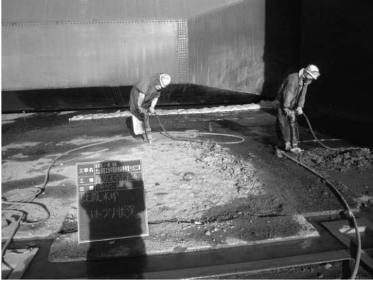
写真-7 ②既設コンクリートはつり
