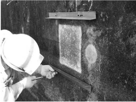
写真-3 研磨前の壁面状況及び研磨深さ測定用治具取り付け
