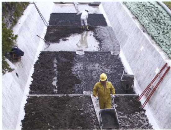
保全対策試験区の施工中
