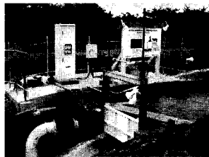
小水力発電システム (農業用水路の堰堤を利用した 小水力発電の例)
