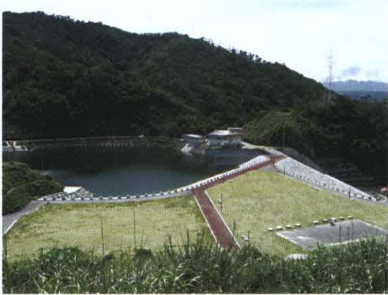
満水状況の真喜屋ダム
