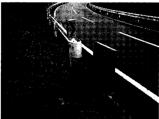
写真-3 Aエリア集水樹
