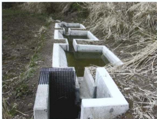
拡幅集水枡（手前）・人工池
