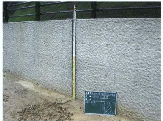
擁壁表面の粗面仕上げ状況
