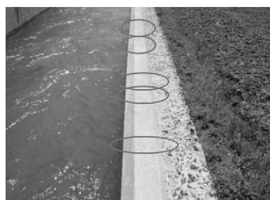
写真-11 従来ポリマーセメントモルタル区間
