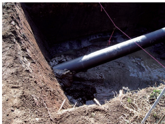
埋設管の引き込み開始
