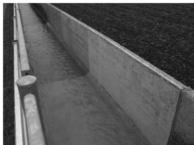
写真-9 水路状況
