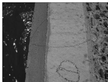
写真-12 超高強度ポリマーセメントモルタル区間
