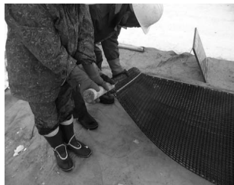
写真-4 単管パイプ設置状況
