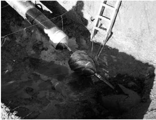
写真-8 埋設管の取り付け
