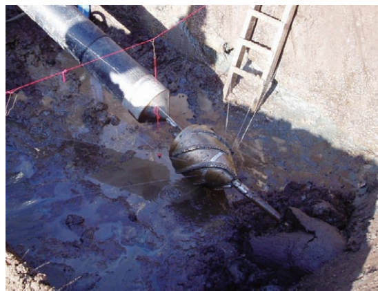
埋設管の取り付け
