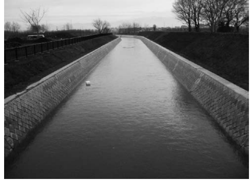
写真-8 工事完了後
