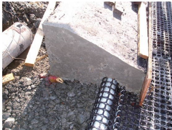
基礎コンクリートとの密着状況
