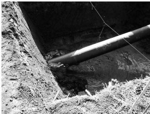
写真-9 埋設管の引き込み開始
