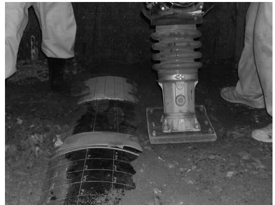
写真-5 締固め状況 (条件3)
