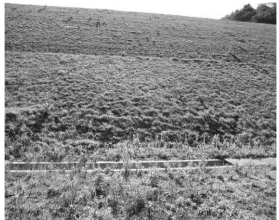
写真-18 ため池法面における施工事例
