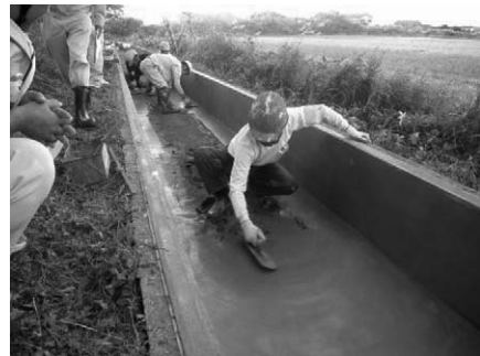
写真-7 底版部仕上げ状況
