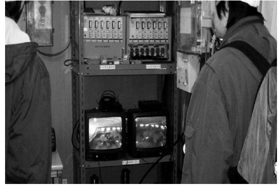
写真-8 ガス検知機と函内モニター
