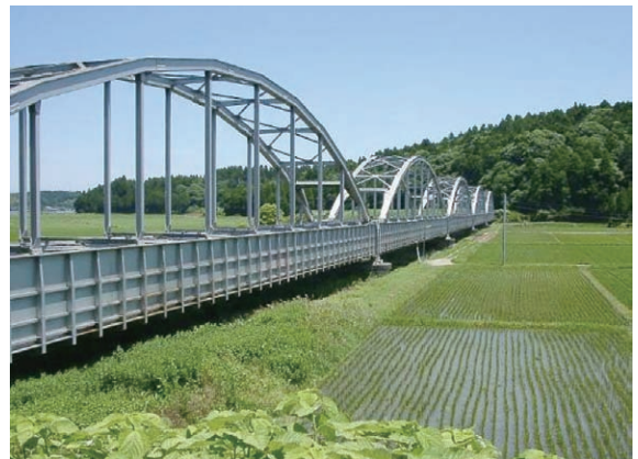
現在の公平水路橋
