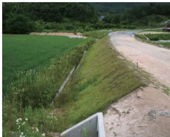
農道法面における施工事例
