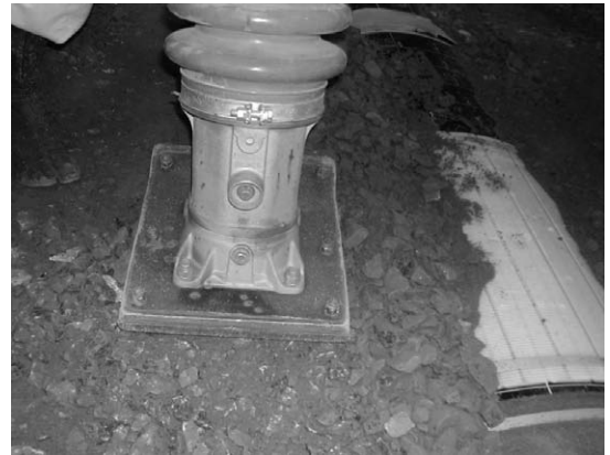
写真-4 締固め状況 (条件2)
