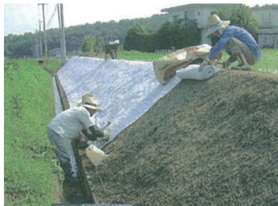
法面部の張付
