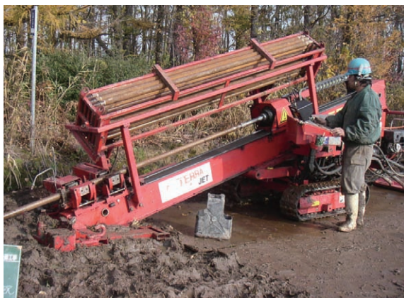
ドリルラック据付全景
