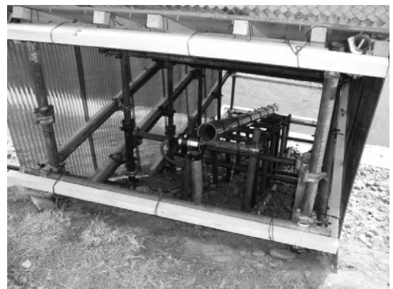
写真-9 観測計器設置状況
