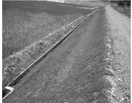
写真-17 新規法面における施工事例
