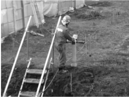
写真-4 ロケーターによる計測
