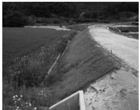
写真-19 農道法面における施工事例
