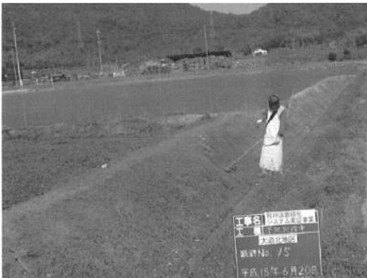
写真-6 草刈り機による刈払い
