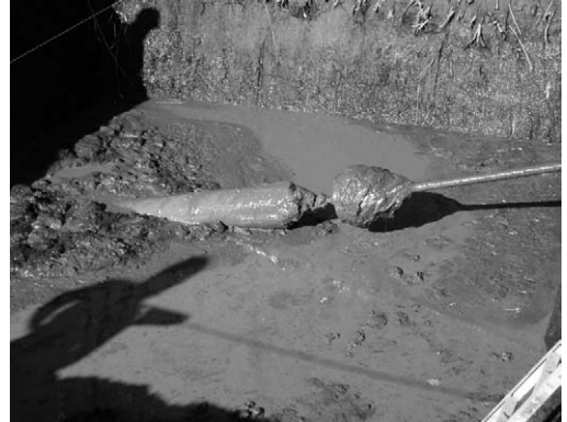
写真-10 埋設管の引き込み完了
