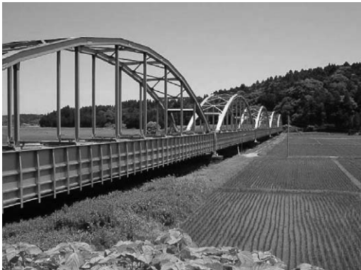
写真-2 現在の公平水路橋
