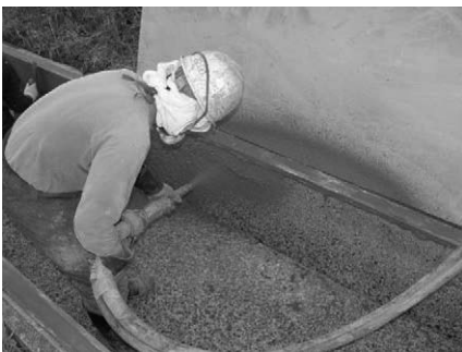
写真-5 HPFRCC吹付け状況
