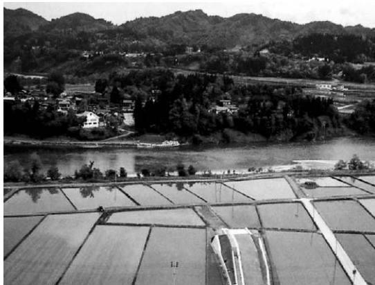
写真-1 着工前全景
