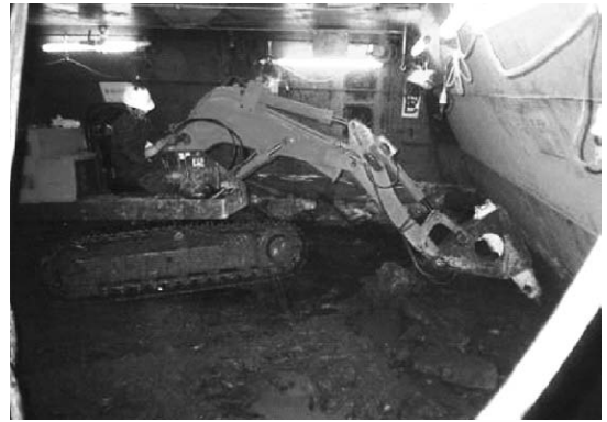
写真-4 地上走行式バックホウ掘削状況
