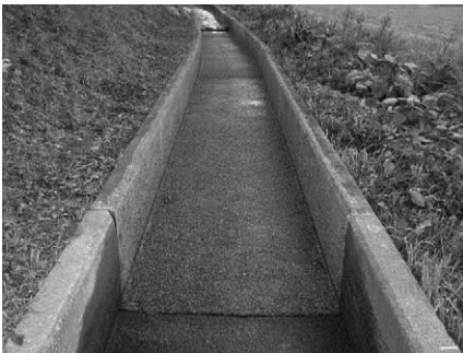
写真-4 処理完了
