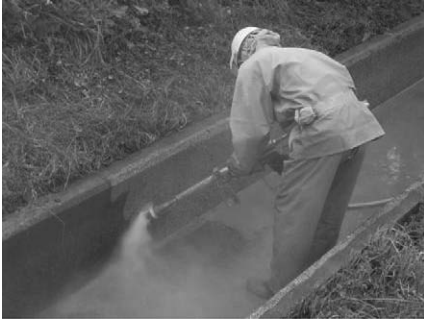
写真-3 ウォータージェットによる処理状況
