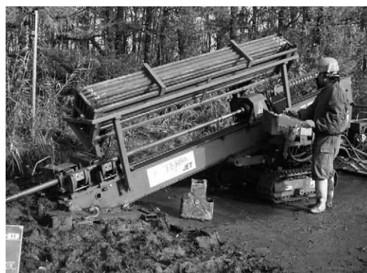
写真-2 ドリルラック据付全景
