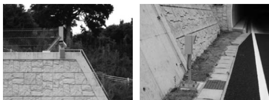
車両検知カメラセンサ 補償用赤外線センサ 写真-4 車両検知用センサ
