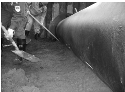
図-9 管底部の突固め状況
