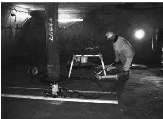
写真-5 載荷試験実施状況
