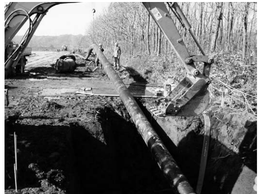
写真-7 埋設管の取り付け準備
