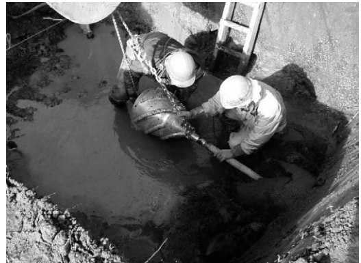
写真-6 バックリーマーの取り付け
