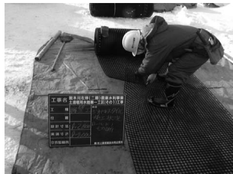
写真-3 現場加工状況
