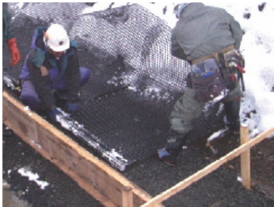
ジオテキスタイル設置状況
