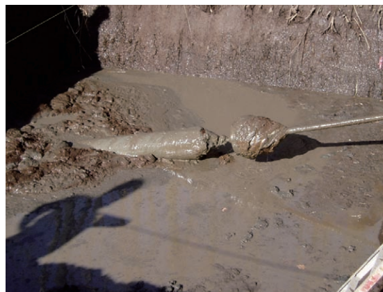
埋設管の引き込み完了
