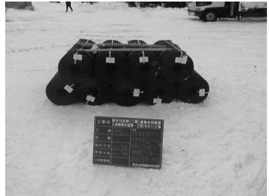
写真-2 材料納入状況
