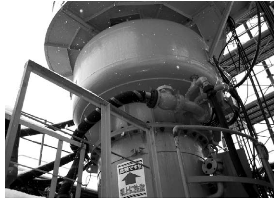
写真-3 加圧・減圧（マンロック）
