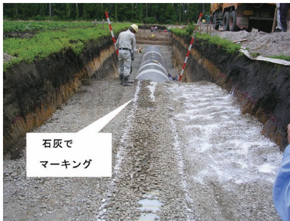
施工状況 (離隔距離の管理状況)
