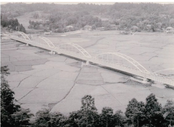
建設当時の公平水路橋
