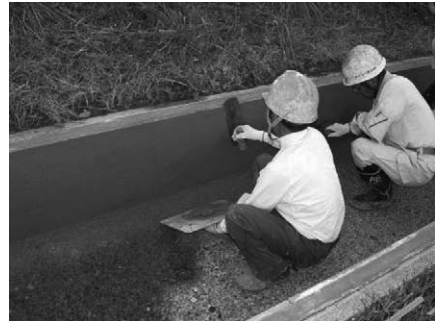
写真-6 側壁部仕上げ状況
