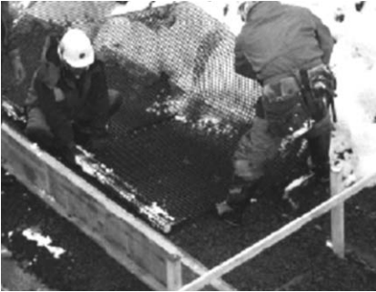
写真-5 ジオテキスタイル設置状況
