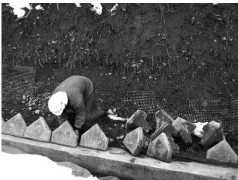
写真-7 コンクリートブロック敷設状況
