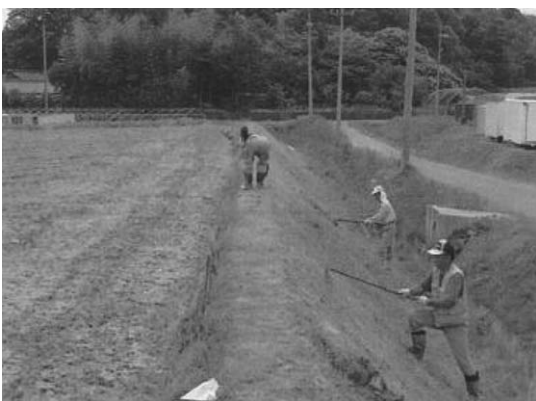
写真-7 レーキによる削り取り
