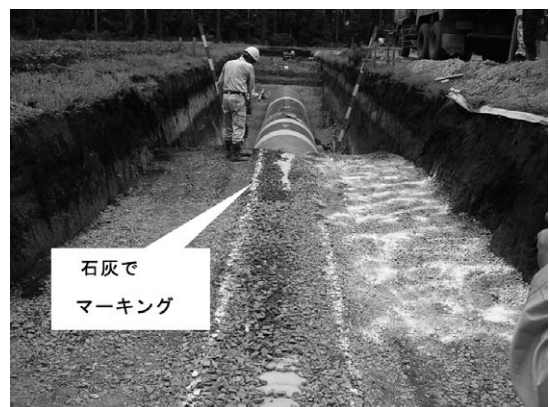
写真-10 施工状況(離隔距離の管理状況)
