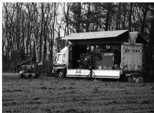
写真-1 システム機械の据付
