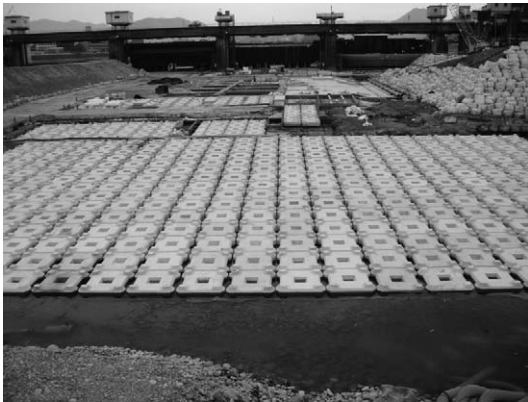
写真-4 護床ブロックの増設
