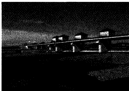
写真-5 完成した頭首工
