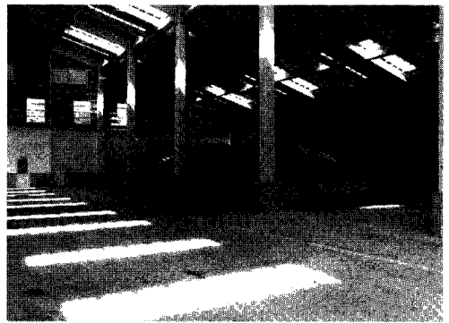
写真-7 堆肥製品庫
