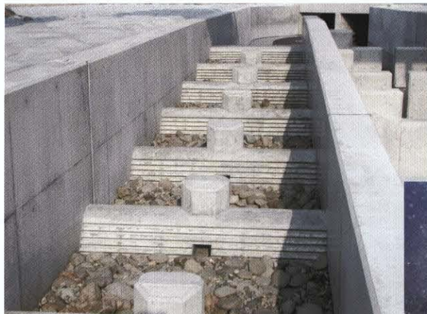
完成した魚道を下流から見る
