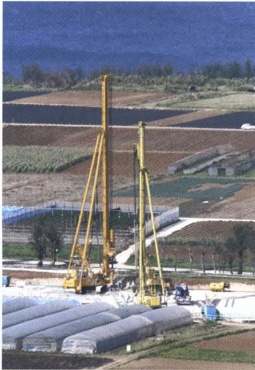
伊江地下ダム試験工事施工状況 手前が従来機(DH608),奥が大型機(DH808)
