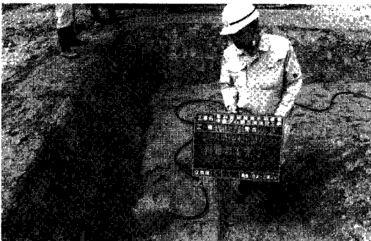
写真-2 間隙水圧計設置状況
