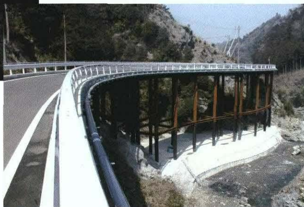
完成後の写真
