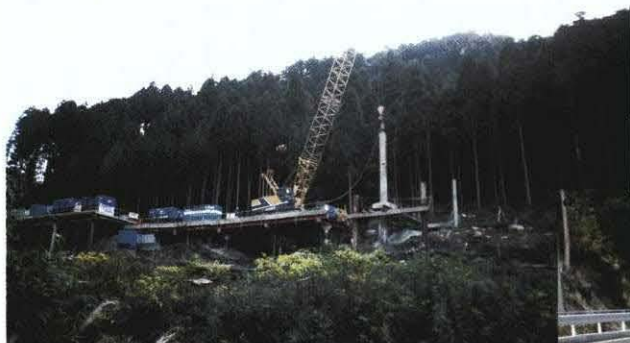
工事中の写真
