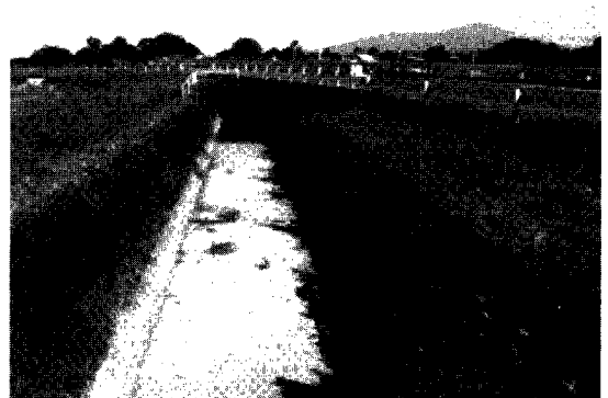
写真-1 施工前状況
