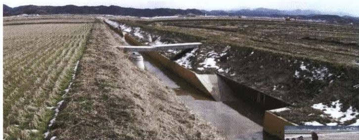
幹線排水路のスロープ
