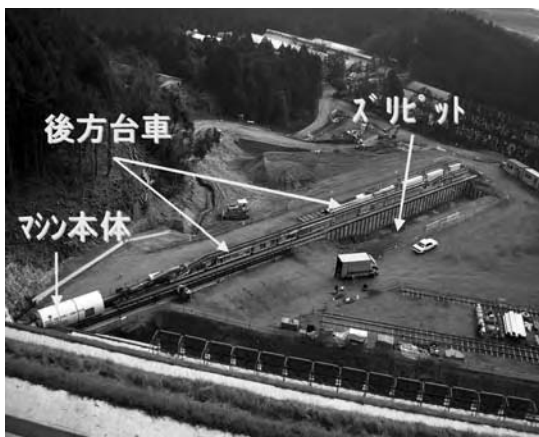
写真-4 TBM掘削前の全景
