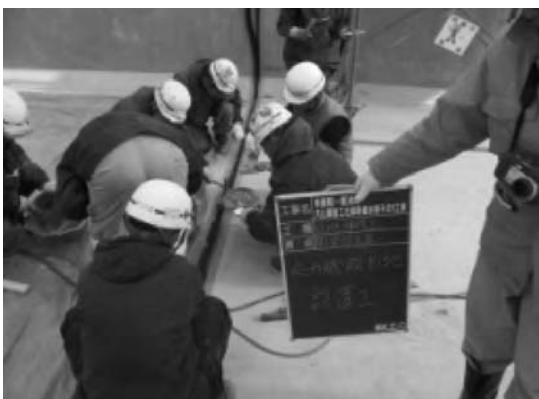
写真-8 応力機能目地工法の施工状況及び施工後
