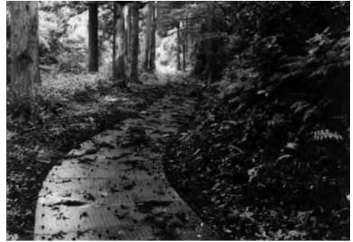
写真-13 水路上面を鉄板で覆い、土砂や落葉が流入を防ぐ水路
