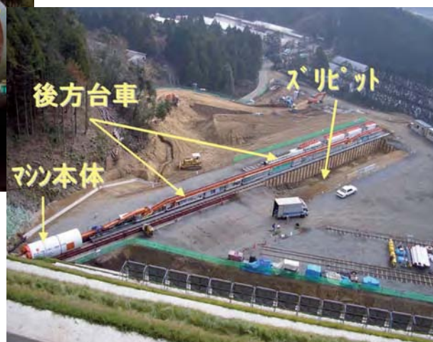
TBM掘削前の全景
