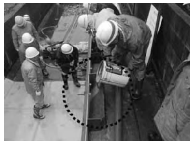
写真-⑧ グラウト材注入
