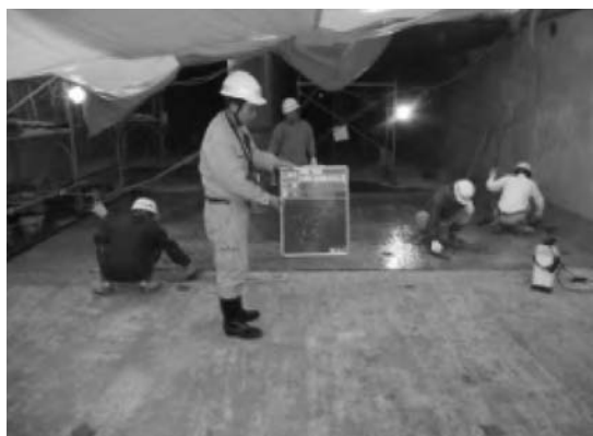
写真-9 プライマー塗布状況及びポリマーセメントモルタル施工状況
