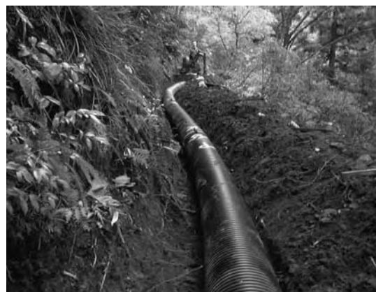
屈曲部の施工
