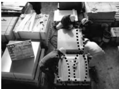
写真-③ ジョイントプレート取付け
