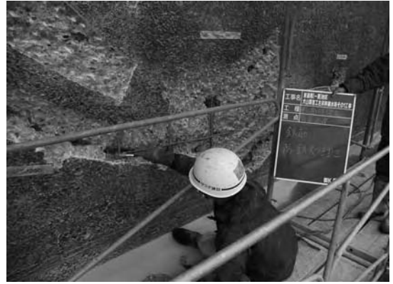
写真-6 軽量ポリマーセメント系モルタルによる断面修復の施工状況
