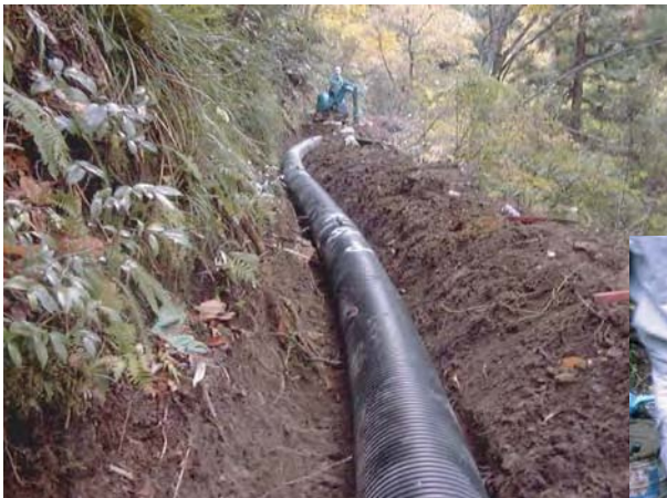
屈曲部の施工
