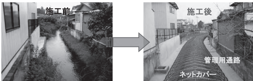
写真－3 施工前・施工後写真
