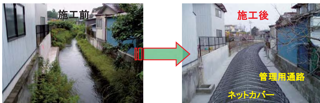
施工前・施工後写真
