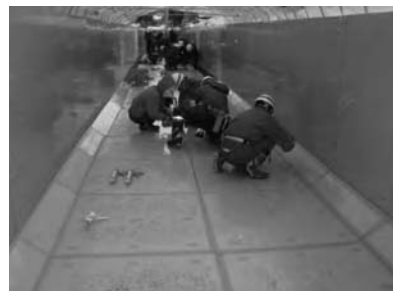
写真-⑦ 目地材シーリング設置
