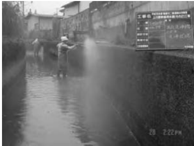
写真-① 既設水路（高圧ジェット）洗浄
