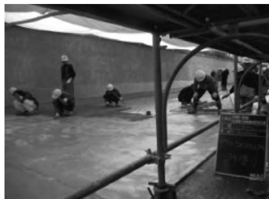
写真-9 プライマー塗布状況及びポリマーセメントモルタル施工状況
