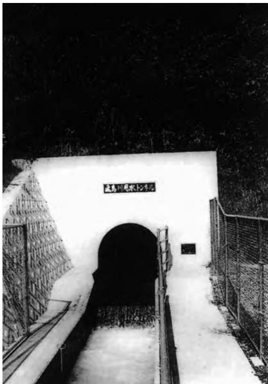
写真-9 新用水トンネル出口
