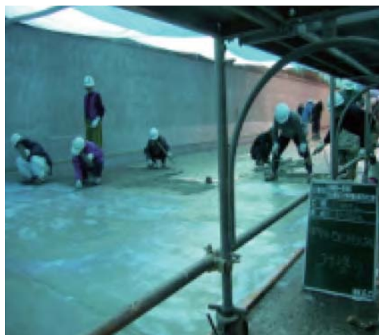
プライマー塗布状況及びポリマーセメントモルタル施工状況
