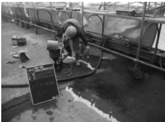
写真-7 インジェクターによるエポキシ樹脂注入の施工状況
