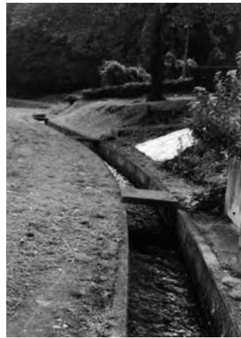
写真-14 コンクリート三面張り用水路
