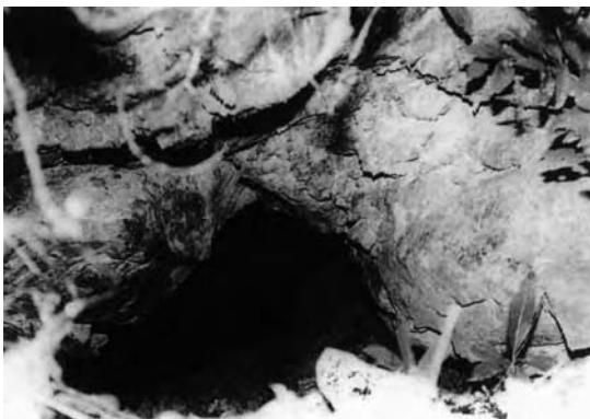
写真-3 遊牛谷の水路トンネル
