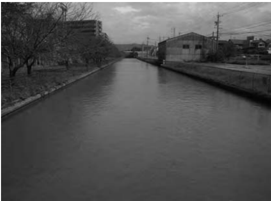
写真-3 水位上昇状況（粗度が悪化）
