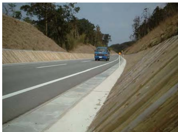
完成した法面保護工 H17.3
