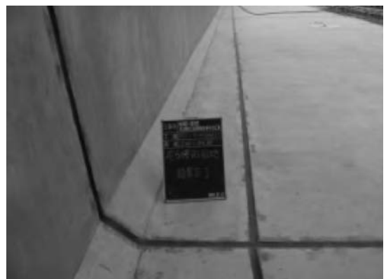
写真-8 応力機能目地工法の施工状況及び施工後
