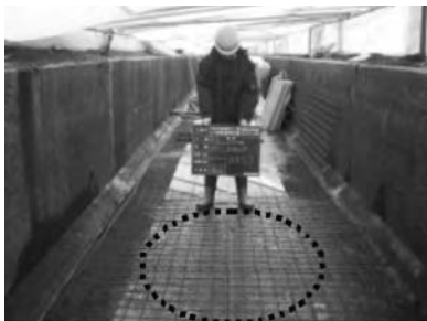
写真-② 底盤溶接金網設置
