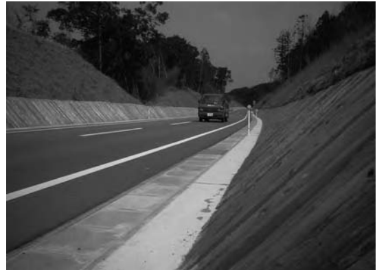
完成した法面保護工 H17.3
