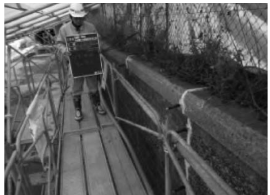
写真-7 インジェクターによるエポキシ樹脂注入の施工状況
