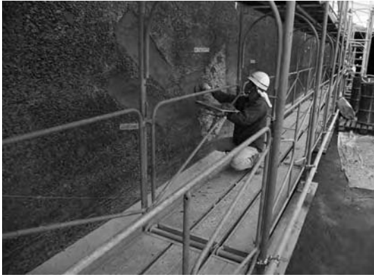
写真-6 軽量ポリマーセメント系モルタルによる断面修復の施工状況
