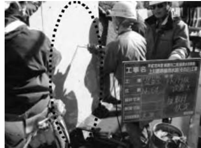
写真-⑤ 側壁FRPM板設置
