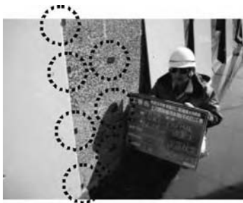
写真-④ 側壁スペーサー設置
