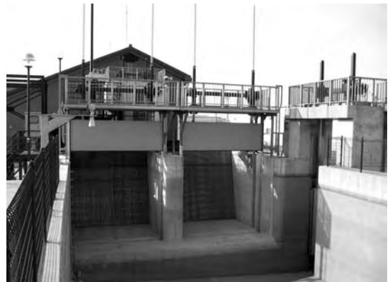
写真-2 ヘッドタンク取水口部
