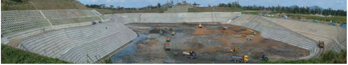
千原地下ダム(地表貯水部) 平成16年12月現在
