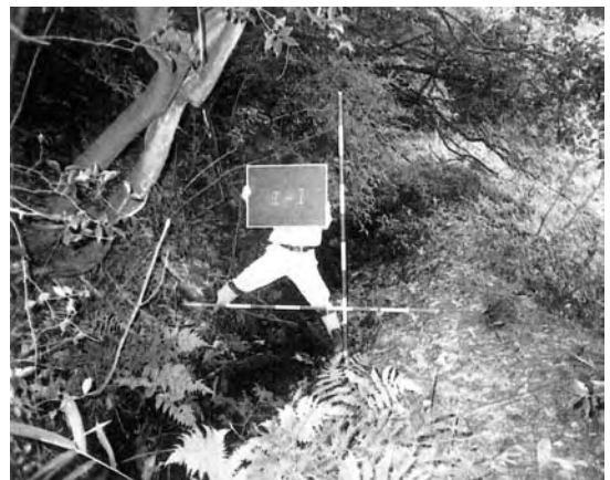
写真-3 野4号排水路（現況2）
