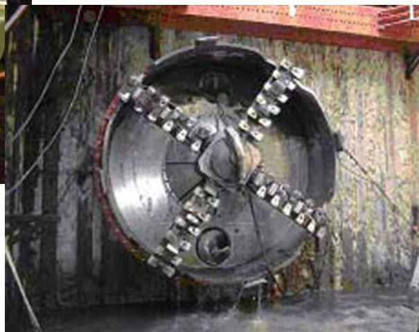
シールドマシン貫通状況
