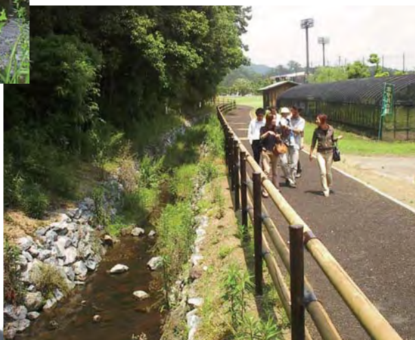
野4号排水路の定型水路部
