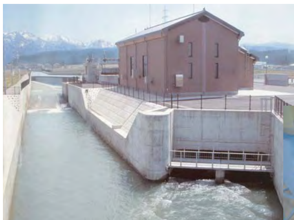
発電所全景(下流側)
