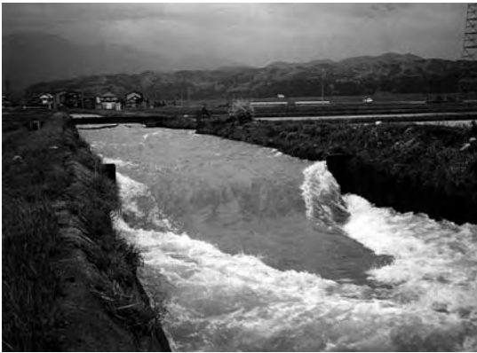
写真-1 現況の2-1号幹線水路
