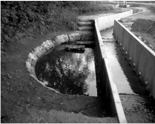
写真-2 淵設置状況
