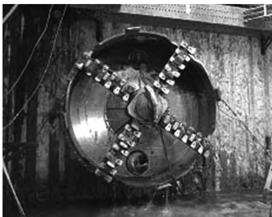
写真-2 シールドマシン貫通状況
