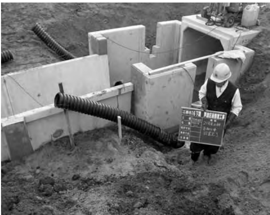
写真-3 波形無孔管設置状況
