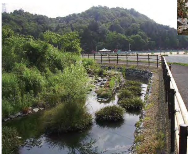
野4号排水路の魚道・深場・幅広部
