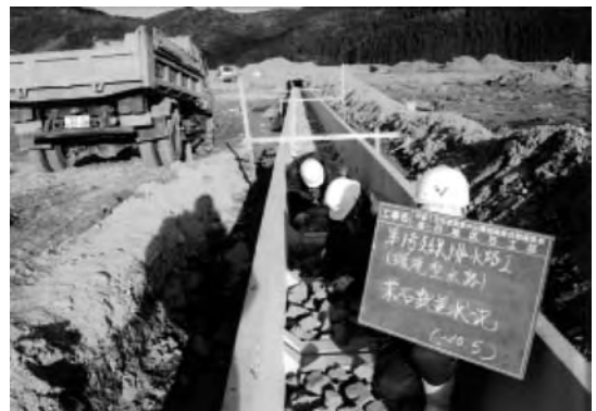
写真-4 二方張水路
