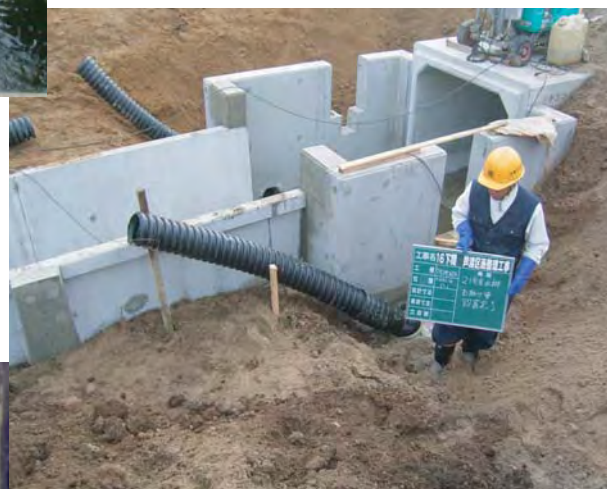
波形無孔管設置状況
