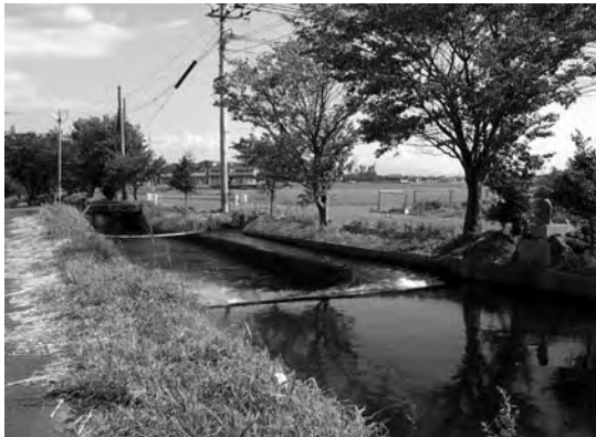
写真-4 内山頭首工及び分水工
