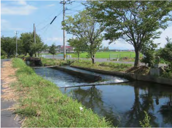
内山頭首工及び分水工
