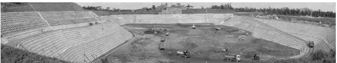
写真-1 千原地下ダム(地表貯水部) 平成16年12月現在
