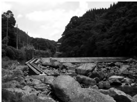
写真-3 水天淵頭首工
