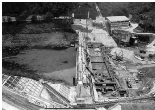
写真-3 コンクリート打設状況
