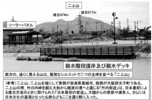
写真-15 親水階段護岸及び親水デッキの状況
