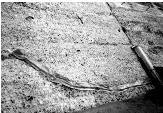
写真-7 漏水処理
