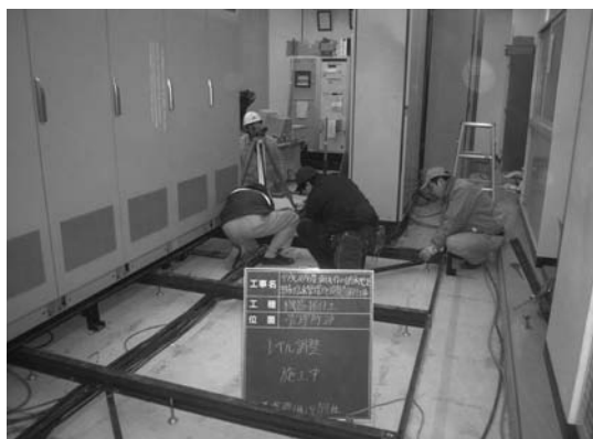
写真-5 レール設置状況
