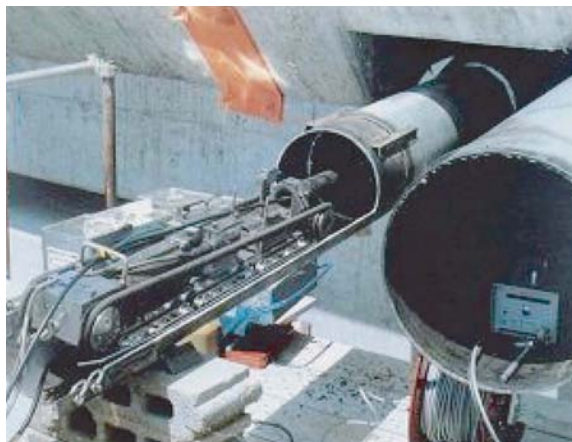
管内面塗装機の外観
