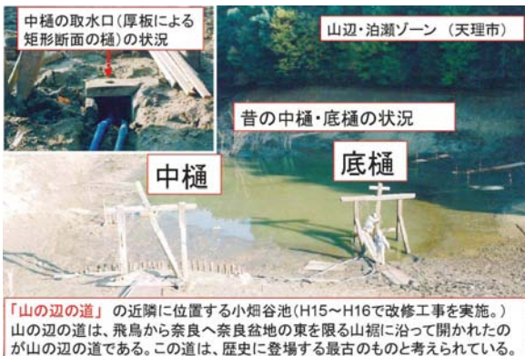
小畑谷池の改修前の状況
