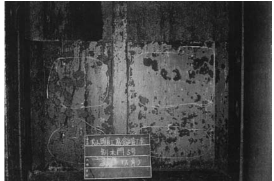
写真-5 側部戸当たりの状況
