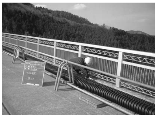
写真-4 堤頂部配線の仮廻し状況
