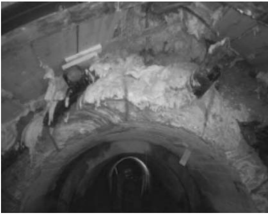
写真-3 空洞充填施工状況 (169基)
