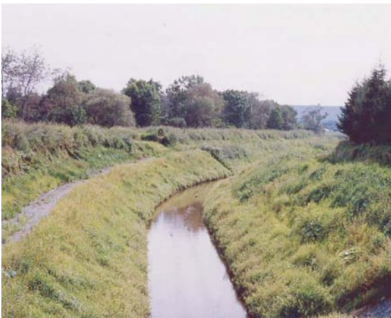
排水路(植生護岸)
