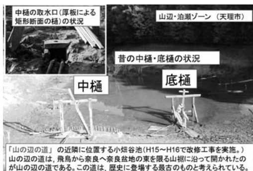
写真-18 小畑谷池の改修前の状況 平成15年12月
