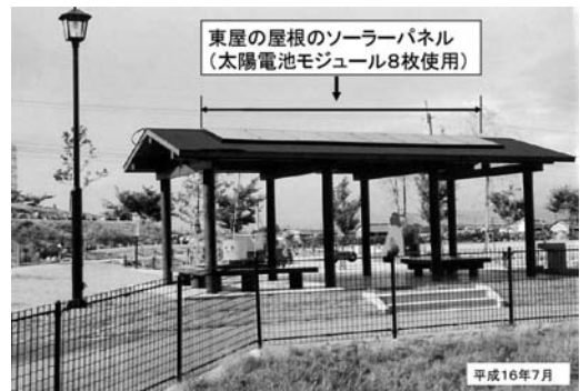
写真-5 ソーラーパネルの設置状況
