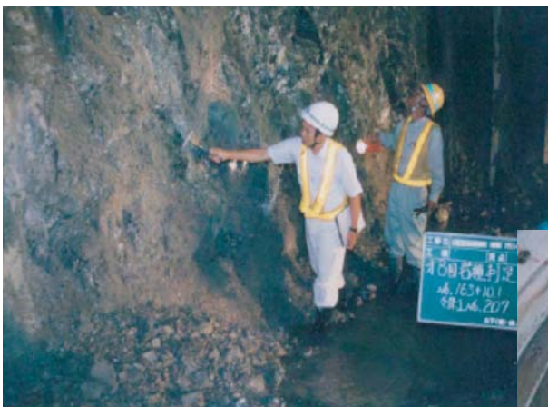
2号トンネル判定状況
