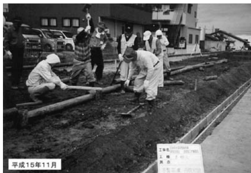
写真-3 直営施工による物づくり広場の整備状況
