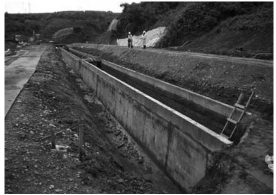
写真-1 側壁外側確認状況
