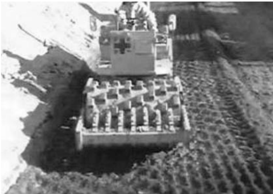
タンピングローラによる締固め状況
