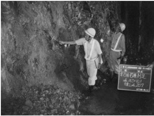
写真-3 判定状況 (2号トンネル)
