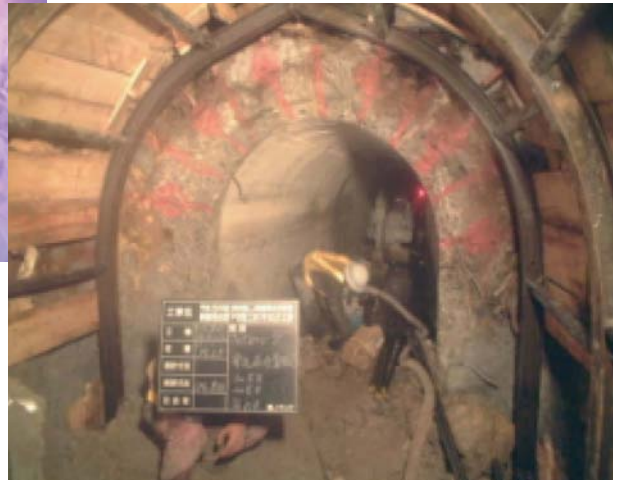
注入式フォアポーリング施工状況
