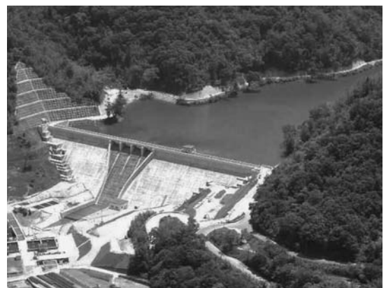
写真-2 新堤体（2004年撮影）
