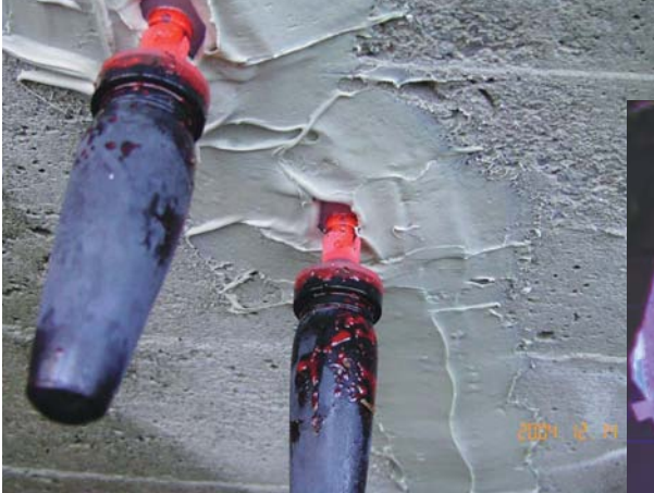
樹脂注入状況
