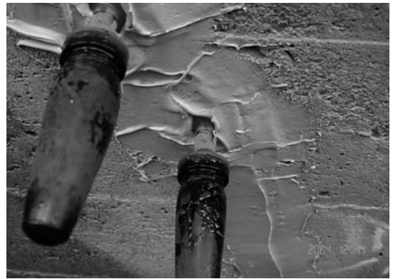
写真-2 樹脂注入状況
