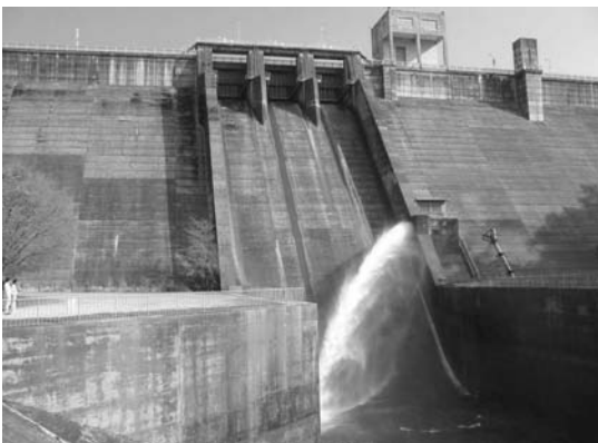
写真-1 ダム堤体下流からの状況
