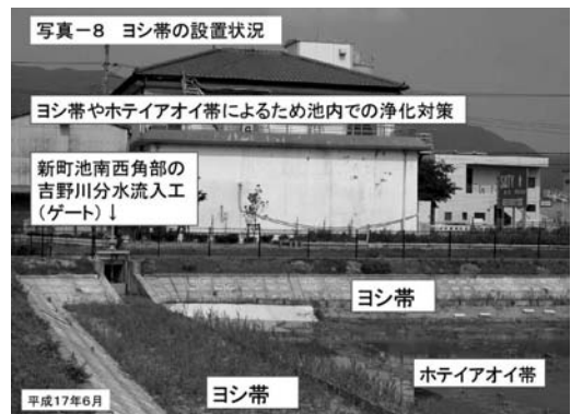
写真-8 ヨシ帯の設置状況
