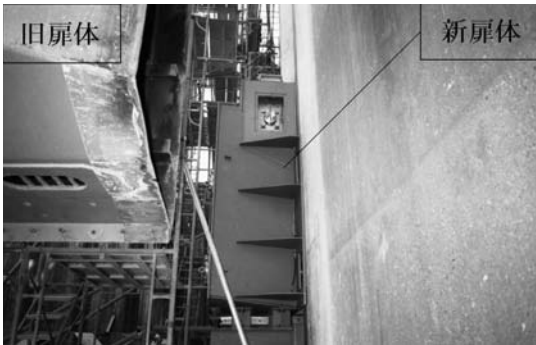
写真-9 旧扉体と新扉体端部
