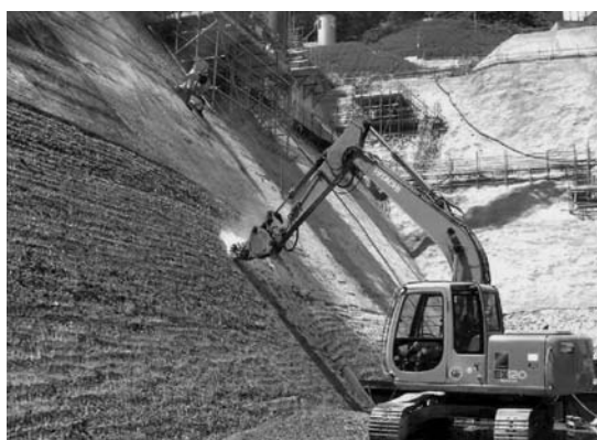
写真-6 旧堤体下流表面処理状況
