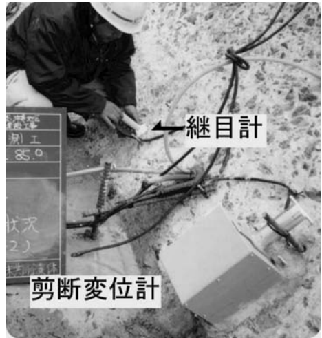
写真-10 埋設計器設置状況
