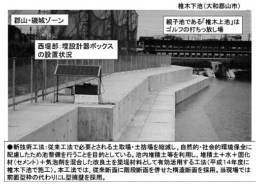
写真-28 新技術工法によるため池改修
