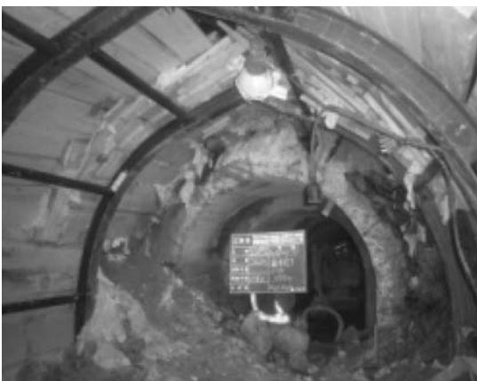
写真-4 注入式フォアボーリング施工状況（169基）
