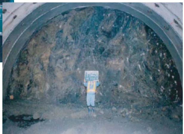
2号トンネル切羽
