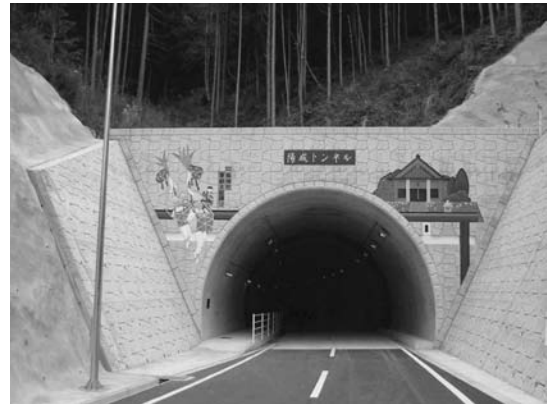
写真-5 7号トンネル
