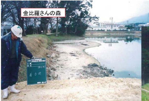
ため池改修前の状況 (東堤北側)
