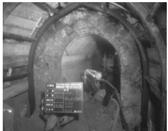
写真-5 注入式フォアボーリング施工状況（174基増ボルト）
