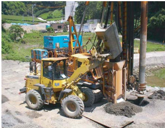
採石投入状況 (写真-1)
