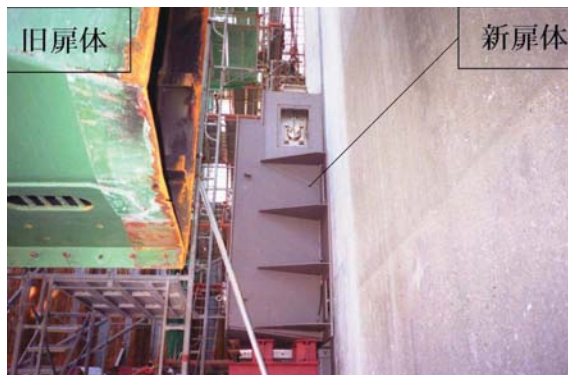
旧扉体と新扉体端部
