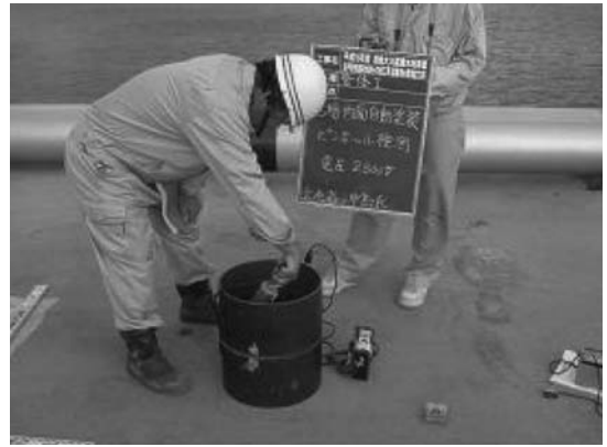
写真-10 事前のピンホール検査状況
