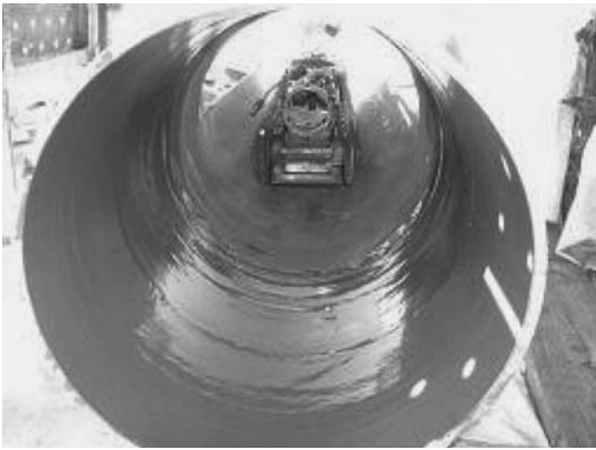
写真-9 塗装完了時の状況
