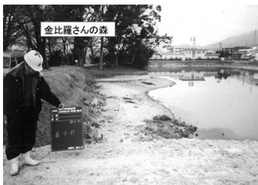
写真-1 ため池改修前の状況 (東堤北側)
