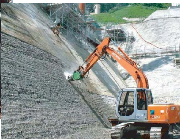
旧堤体下流表面処理状況
