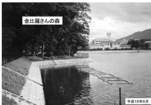
写真-2 ため池改修後の状況 (東堤北側)
