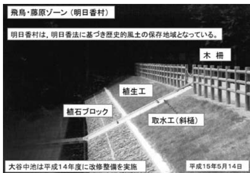
写真-24 大谷中池の改修後の状況
