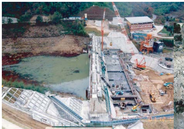
コンクリート打設状況
