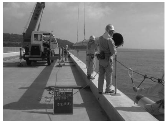
写真-6 長尺管（12m）の架設状況
