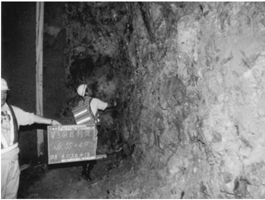
写真-6 判定状況 (7号トンネル)
