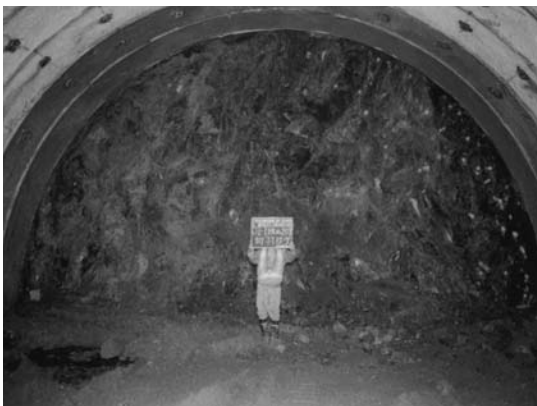
写真-4 2号トンネル切羽
