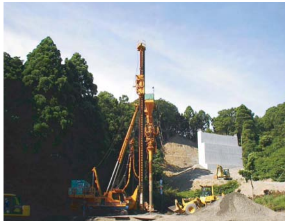
ケーシングパイプの地中貫入状況 (写真-2)
