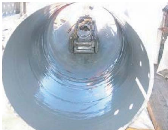
塗装完了時の状況
