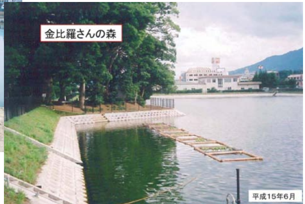
ため池改修後の状況 (東堤北側)
