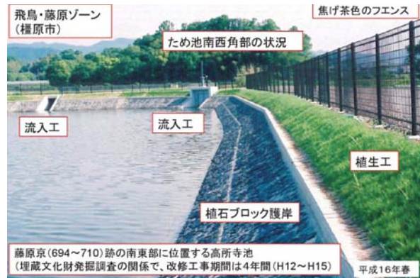
高所寺池の改修後の状況
