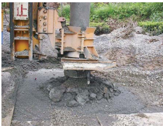
杭体造成状況 (写真-3)
