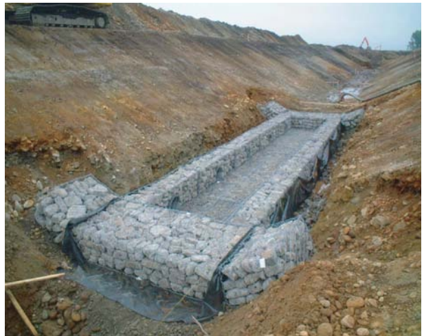
魚溜工施工状況
