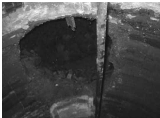
写真-5 3号トンネルアーチ部の落盤
