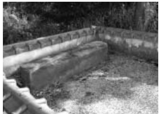
写真 - 2 請石部分
