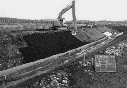
写真-4 鋤とり物法面整形作業状況
