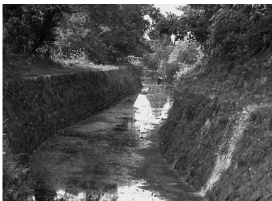
写真-3 幹線水路（開渠）の状況
