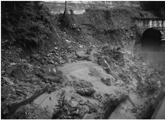
写真-7 第2沈砂池の被災後（下流から撮影）
