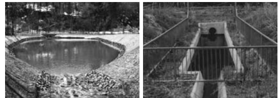
小沼沢幅広水路工
