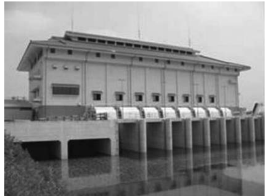
写真-1 機場外観写真
