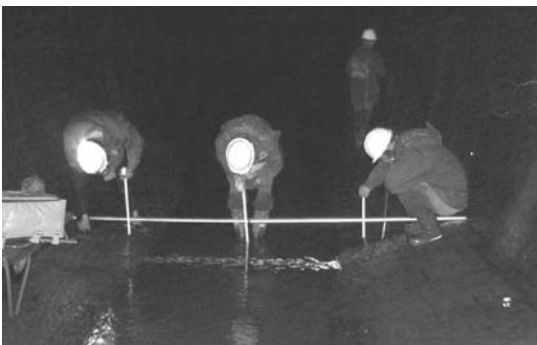
写真-12 インバート摩耗の計測
