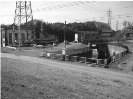
写真-2 現機場（左）と板倉川（右） 新機場は現機場と板倉川に挟まれた狭小箇所に建設
