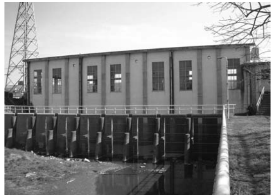
写真-1 現排水機場
