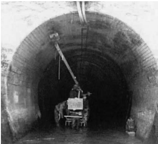
写真-10 電磁波レーダー調査
