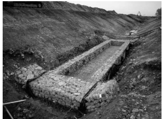
写真-2 魚溜工施工状況
