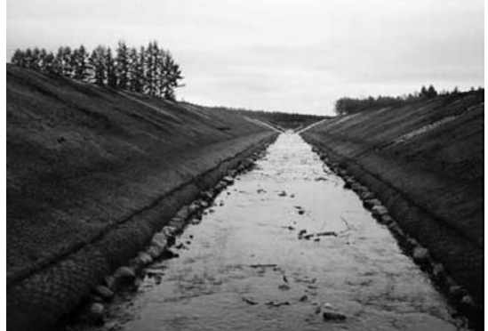
写真-5 法面整形完了状況
