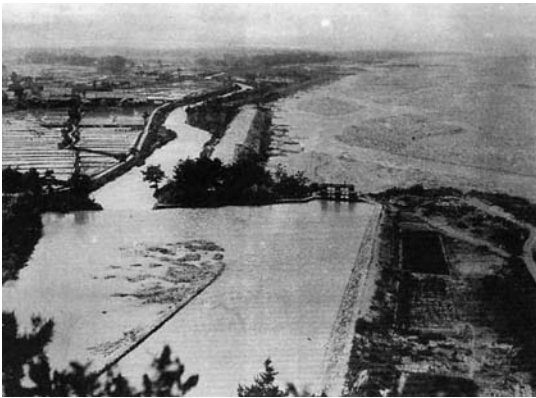
写真-2 当時の常西合口水路
