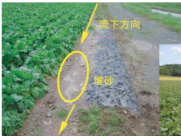
降雨直後の保護工
