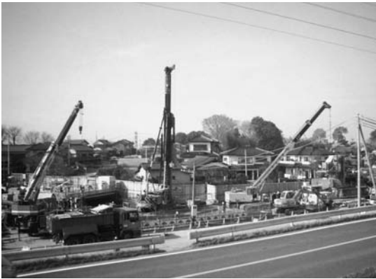
写真-3 接続水槽基礎杭打設工
