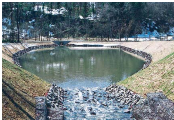
小沼沢幅広水路工
