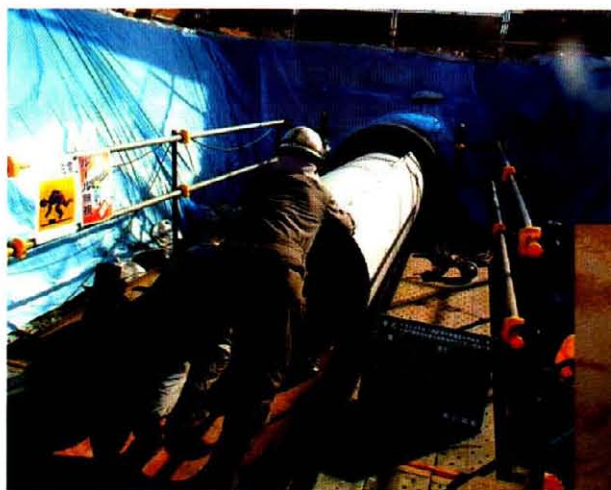
巻き込み鋼管の引込み作業状況
