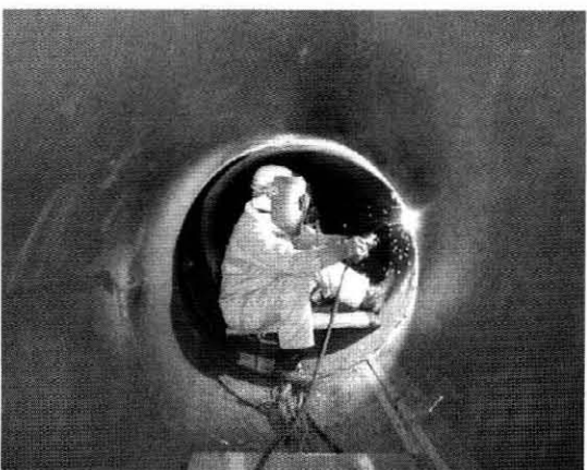
写真-3 巻き込み鋼管の溶接作業状況
