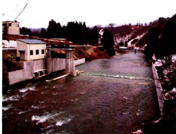
西高峰頭首工全景(補修完了)
