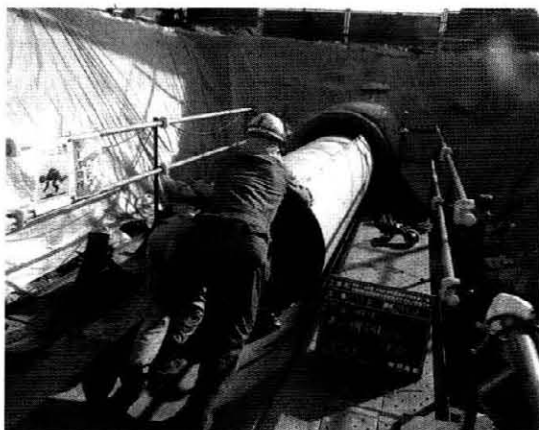
写真-1 巻き込み鋼管の引込み作業状況
