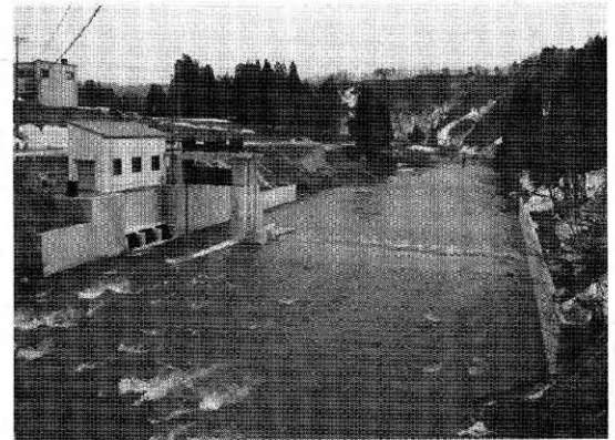
写真-4 西高峰頭首工全景（補修完了）
