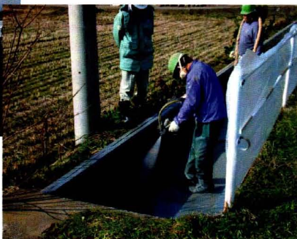
塗装吹き付け状況
