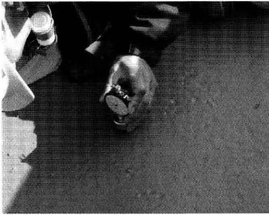
写真-4 塗膜厚の測定状況
