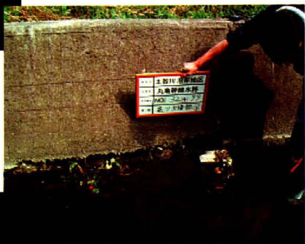
側壁部(欠損)
