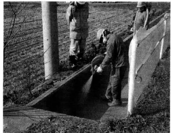
写真-3 塗装吹き付け状況
