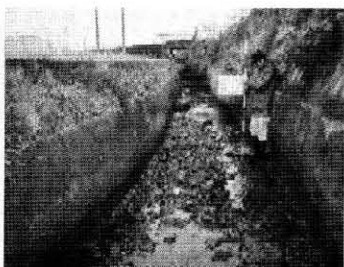
写真-5 土砂・転石堆積状況 （摩耗特記参考）
