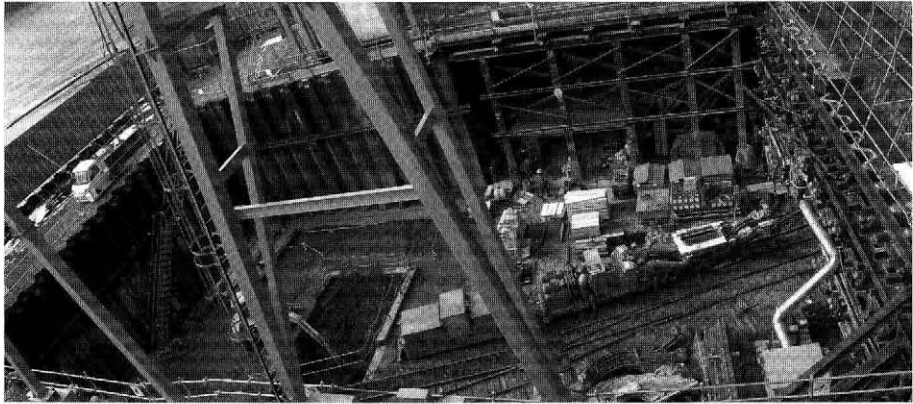
写真-11 トンネル坑口の全景
