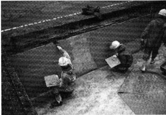
写真-9 繊維モルタル塗布
