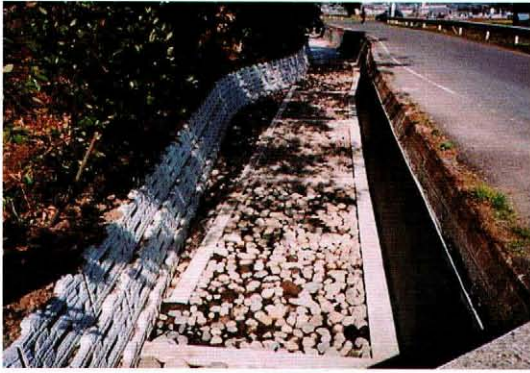
ほたる護岸工
