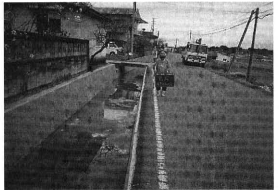
写真-3 景観保全工L=1,984.7m
