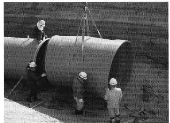
写真-4 吊り降ろし
