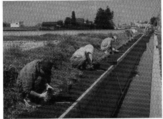
写真-9 植栽作業状況
