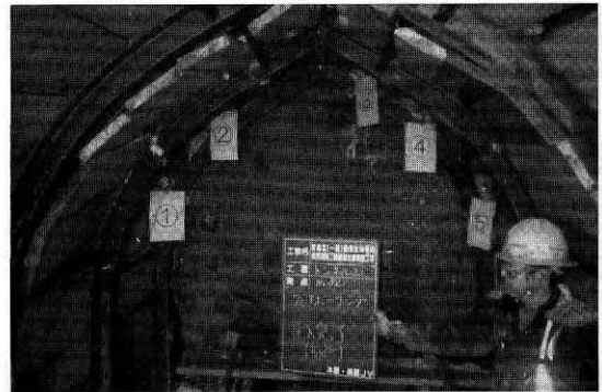
写真-10 注入完了
