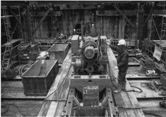
写真一 推進機械据付状況
