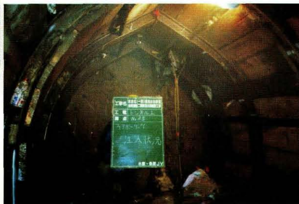
ウレタン注入状況
