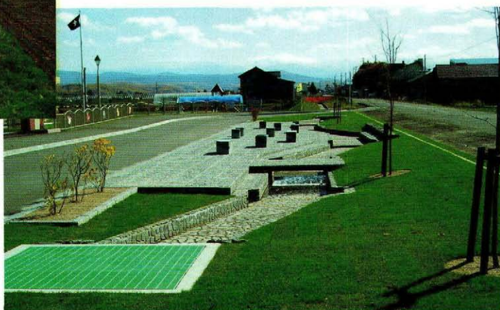
ソフト事業で周辺整備された「せせらぎ水路」
