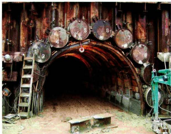
パイプルーフ工完成
