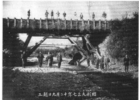
写真-1 木製掛樋の頃の龍の渡井
