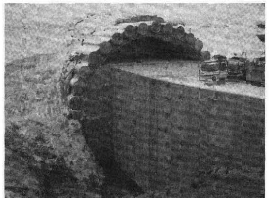
写真-9 エアモルタルの充填完了
