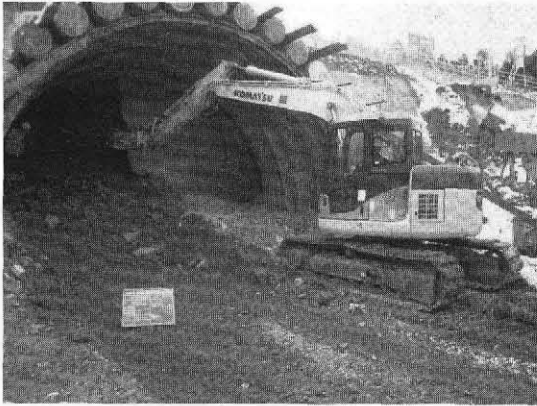
写真-4 トンネル内の掘削状況
