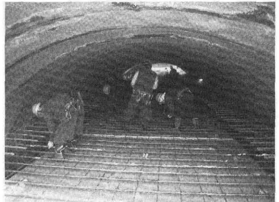
写真-7 坑内での配筋作業
