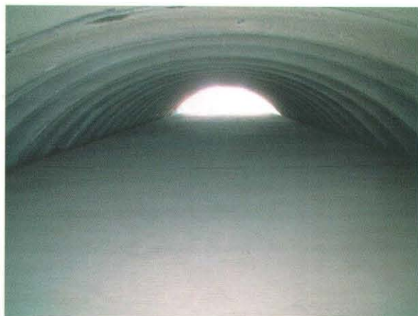
ボックスカルバートの完成
