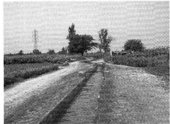
写真-6 改修されたメスカ水路 (先進地：モナイファ地区) 2001年8月
