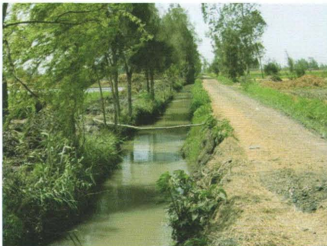
現況のメスカ(支線用水路)
