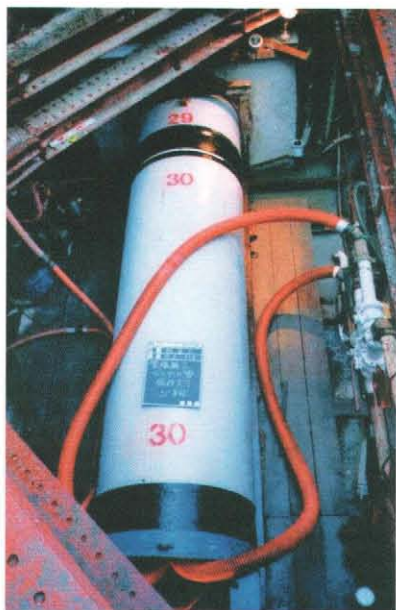
ダクタイル鋳鉄管の推進状況
