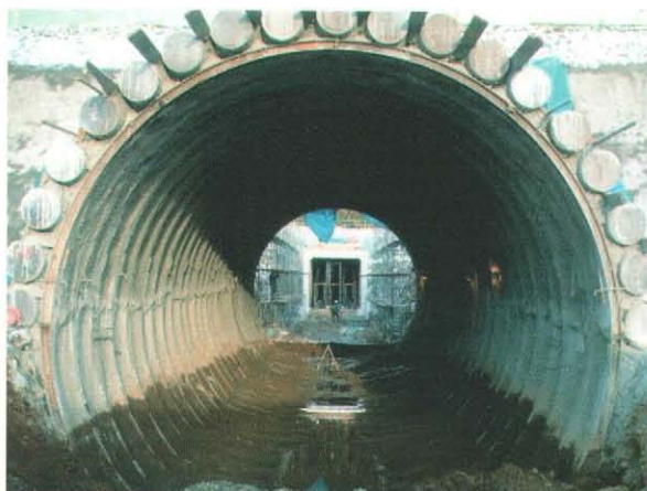
トンネル掘削完成
