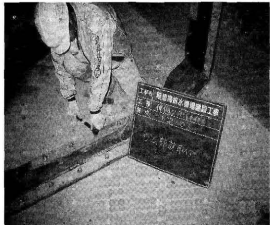
写真-2 目地補修状況
