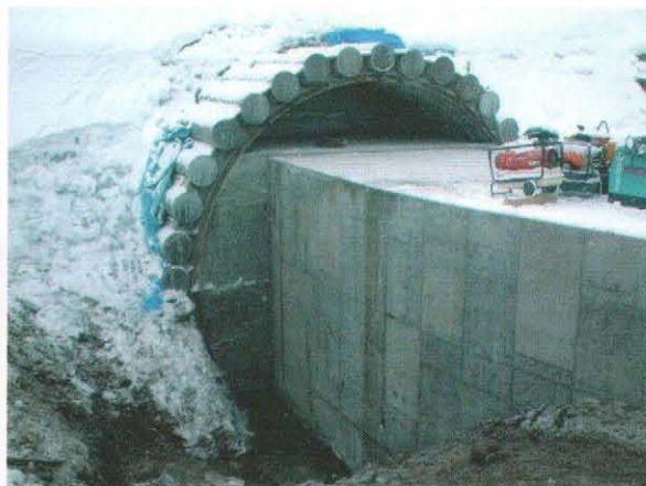
エアモルタルの充填完了
