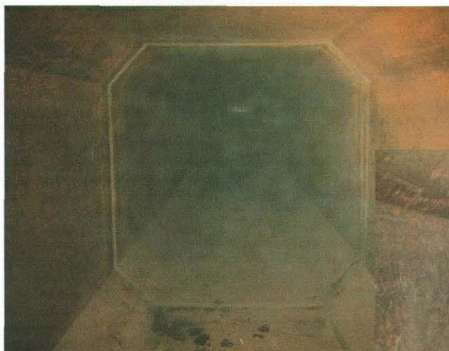
樋管改修前の状況
