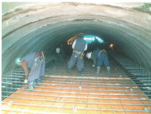
坑内での作業状況
