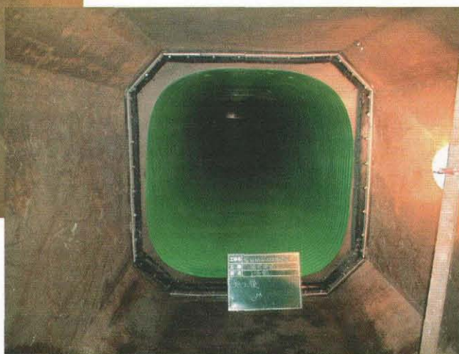
樋管改修後の状況
