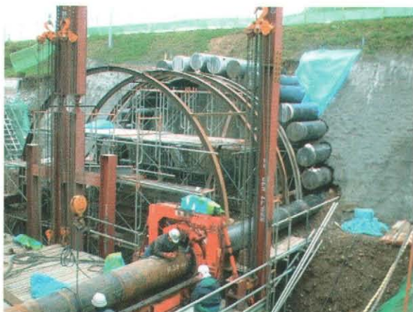
パイプルーフ推進状況
