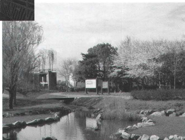
柳川瀬公園から見た管理棟の状況
