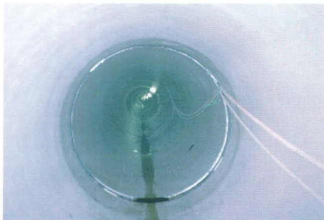
管内施工状況
