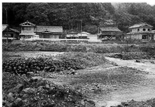
写真-2 被害の状況
