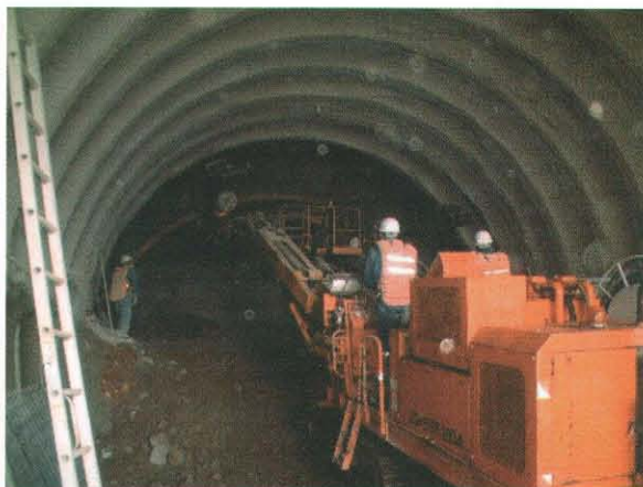
鋼製支保工の建込み状況
