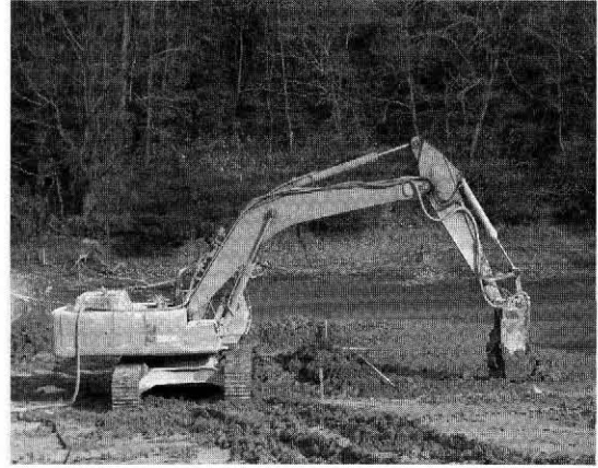
写真-1 トレンチャー型攪拌混合機による初期固化状況
