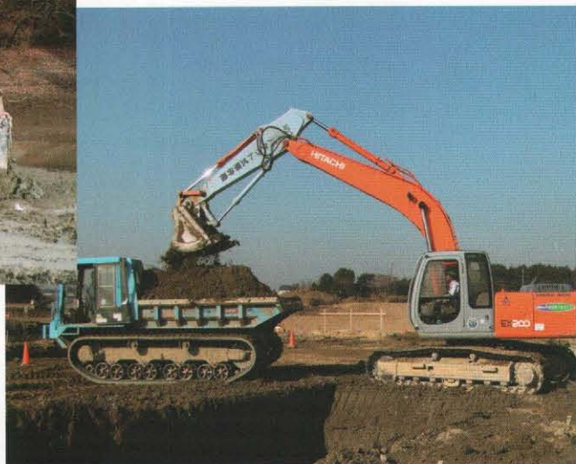
バケット式解砕機による解砕状況
