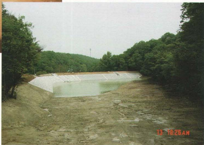
盛立て完了後の状況
