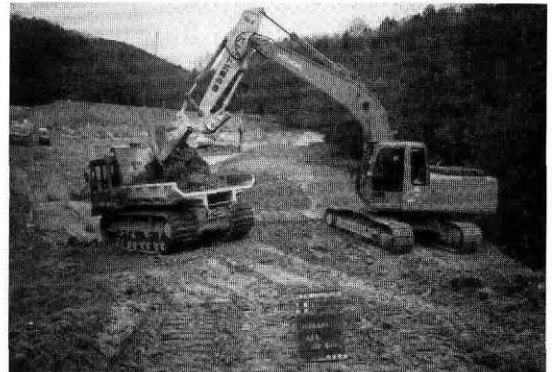
写真-4 解砕機による解砕・積込み状況
