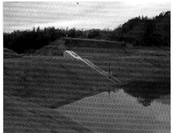
写真-6 北谷池の改修途中の堤体状況
