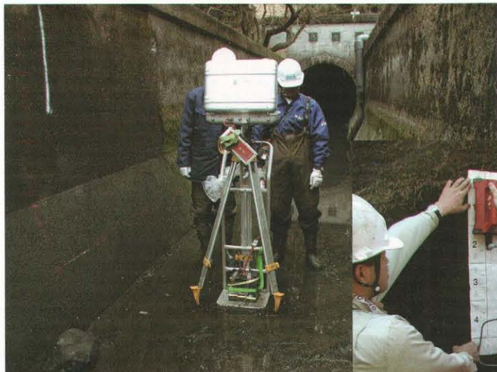
レーザー式内空断面計測状況
