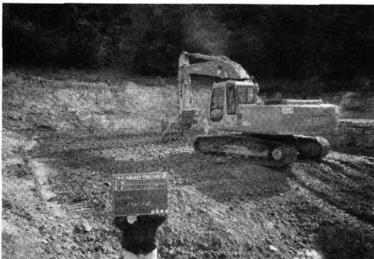
写真-5 バックホウによる撒き出し状況
