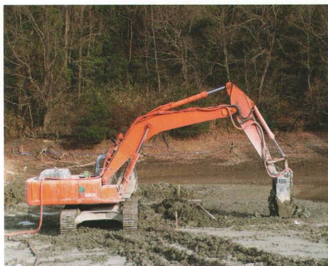
トレンチャー型攪拌混合機による初期固化状況
