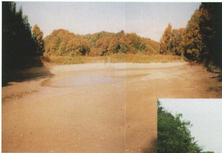
施工前の皿池の状況
