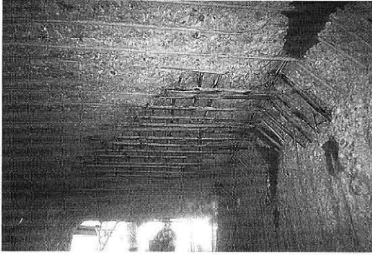
写真-5 補強鉄筋設置完了
