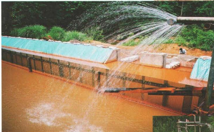
酸化槽への流入状況
