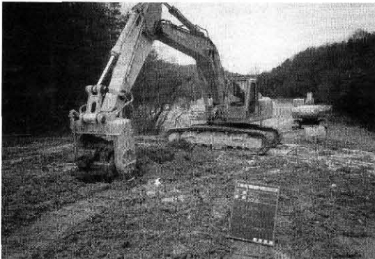
写真-3 トレンチャーによる固化材混合状況
