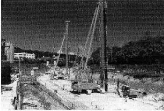
写真一 地中連続壁工法の施工状況
