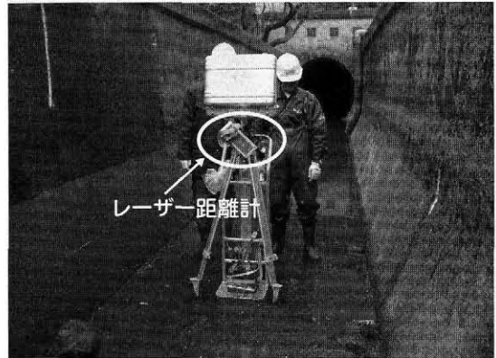
写真-2 レーザー式内空断面計測
