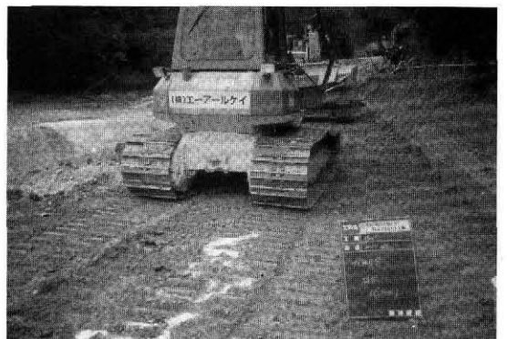
写真-6 ブルドーザーによる転圧状況
