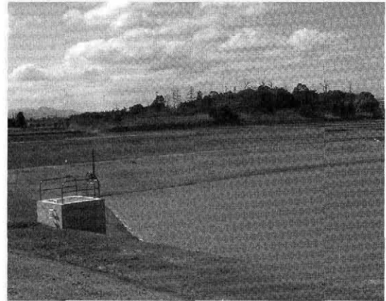
写真-3 寺家池の改修後の堤体の状況
