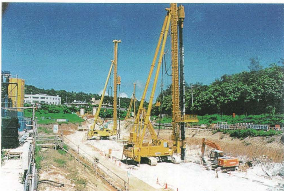
地中連続壁工法の施工状況
