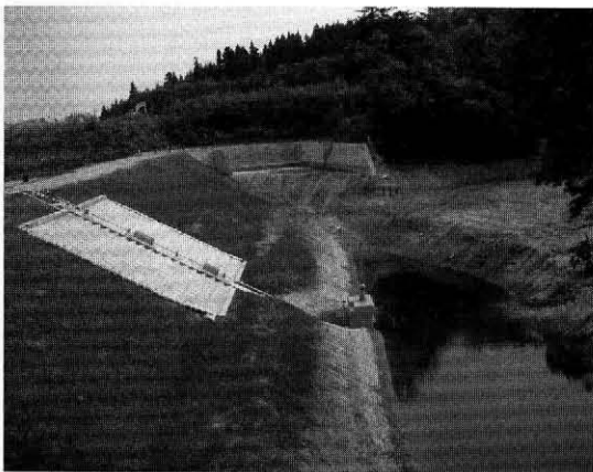
写真-5 虎吉沢池の改修後の堤体状況
