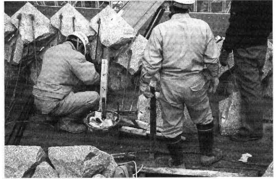
図-24 鉄筋で固定した石積
