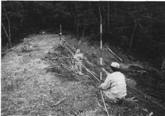
写真-2 堤体陥没状況
