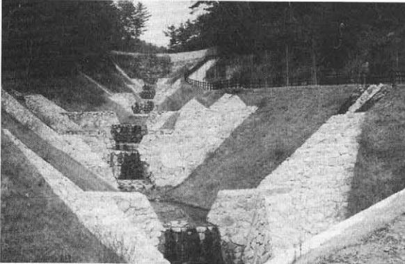
写真-9 石積みにより改修された砂防河川
