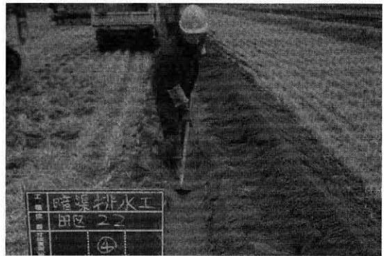
図-8 石炭灰投入状況の写真
