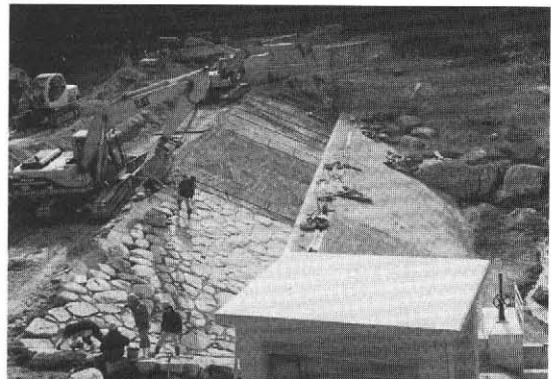
写真-10 張石施工中（付近に転石が点在している）
