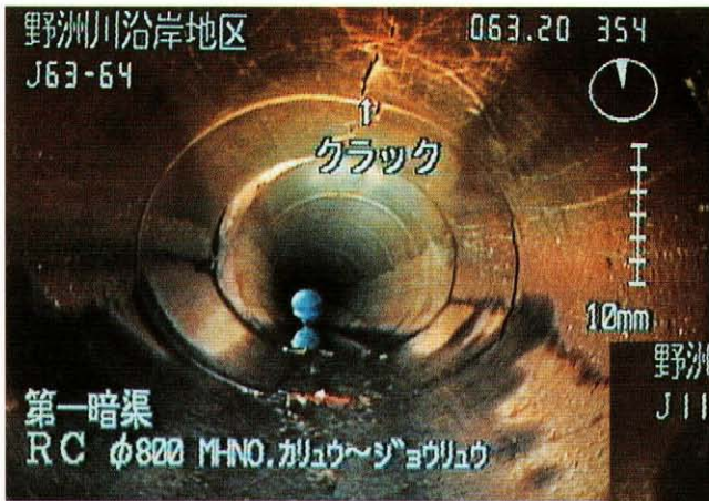
A 区間改修前管内状況
