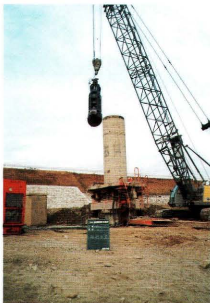
全回転オールケーシング掘削機での 施工状況
