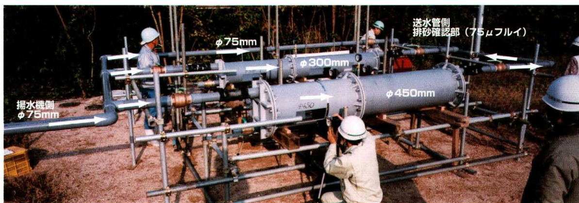
実験装置の設置状況
