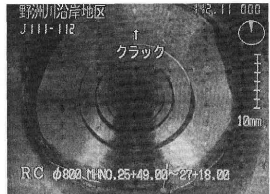
写真-2 B区間 改修前 管内写真
