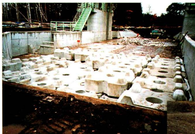
魚道呼び込みプール施工状況
