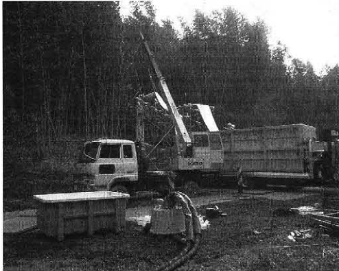
写真-3 反転工法施工状況
