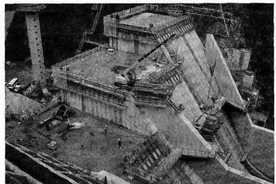
写真-1 施工状況
