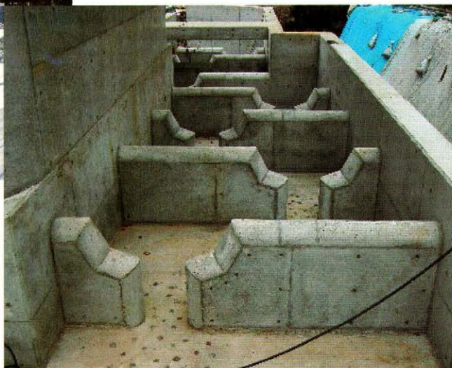
魚道完成写真 (バーチカルスロット形式)
