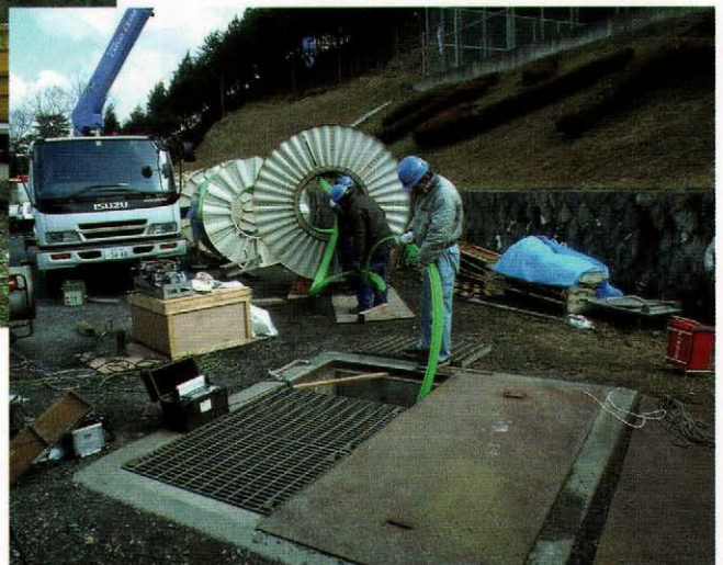
製管工法施工状況 (SPR 工法施工)
