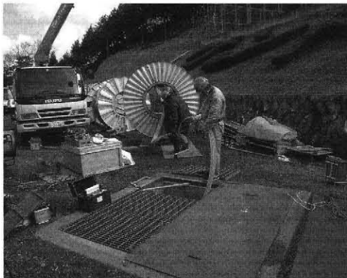
写真-4 製管工法施工状況
