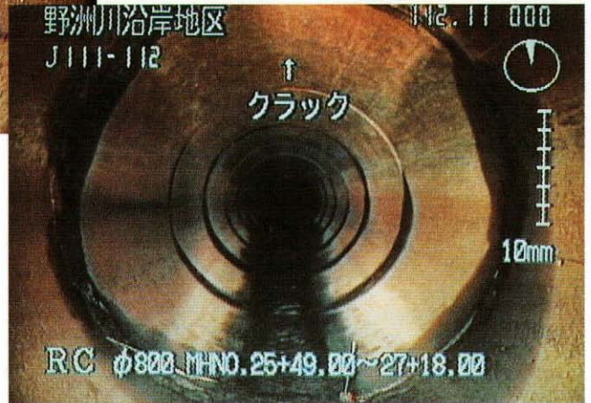
B 区間改修前管内状況
