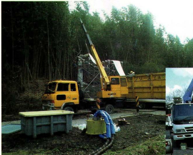
反転工法施工状況
