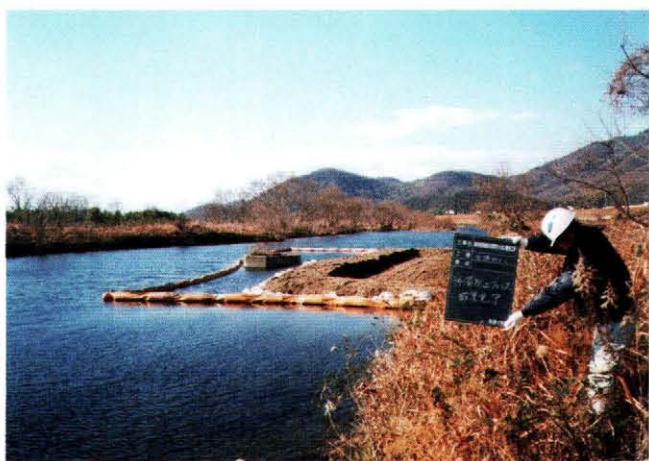
汚濁防止フェンス設置完了状況
