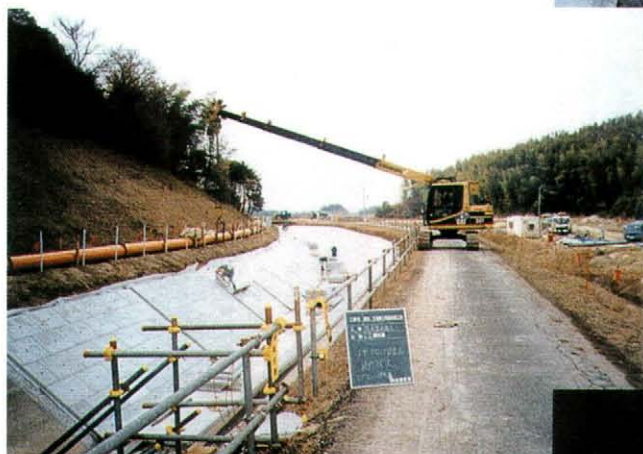
コンクリートブロック設置状況
