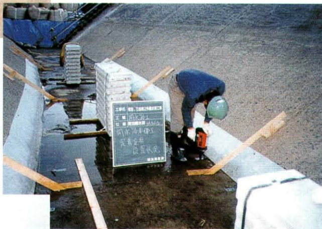
コンクリートブロック調整金具設置状況
