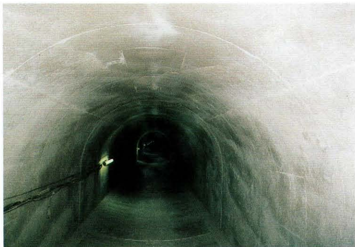
新安積幹線用水路トンネル改修後
