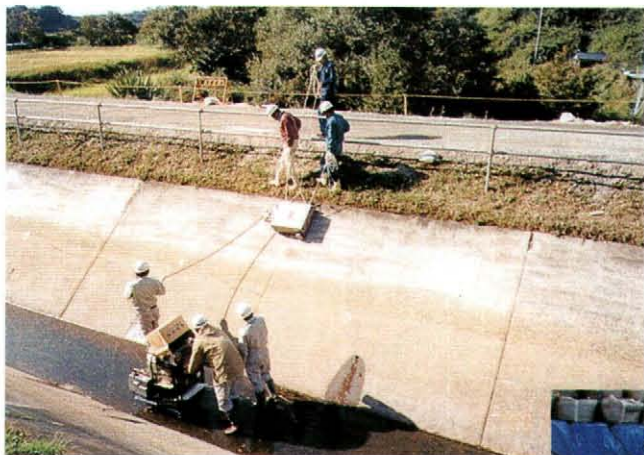
既設水路レーダー探査
