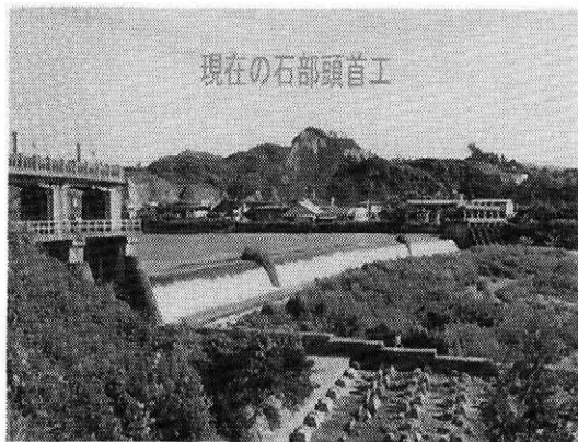
図-5 現在の石部頭首工
