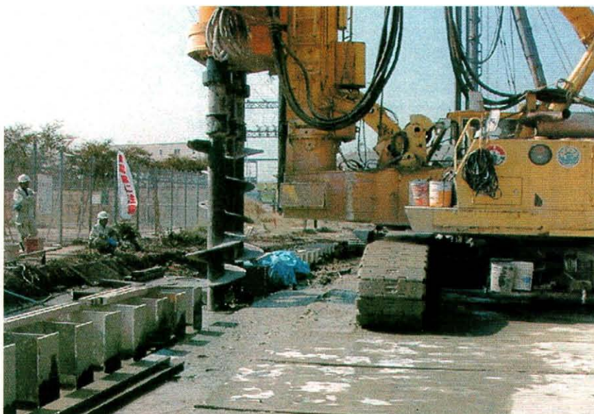
止水壁 (SMW) の施工状況
