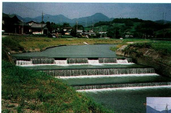
山崎頭首工（改修前）
