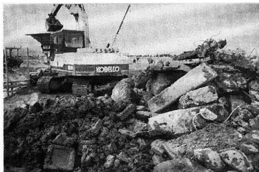
写真二 撤去する際に付着した土を取る。
