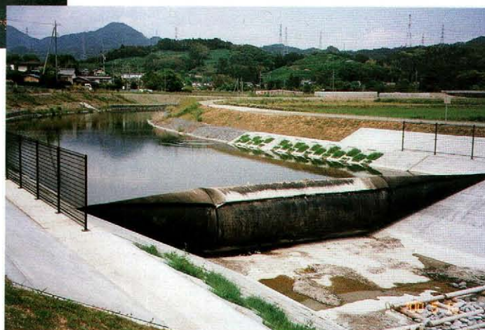
山崎頭首工（改修後）
