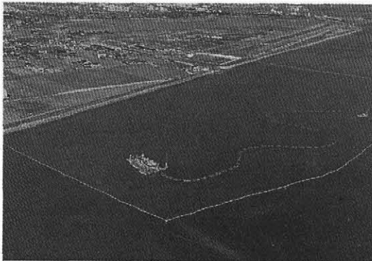
写真-2 笹ヶ瀬川筋を浚渫中のクリアウオータIII号
