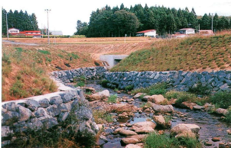
急流落差工。出水に伴い瀬と淵が発達してきている。植生も回復している。
