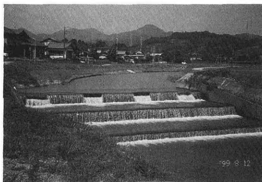
写真一7 山崎頭首工（改修前）
