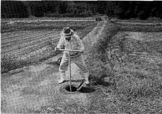
写真—3 制水弁の止水
