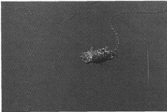
写真-1 松尾港沖を浚渫中の新大本丸
