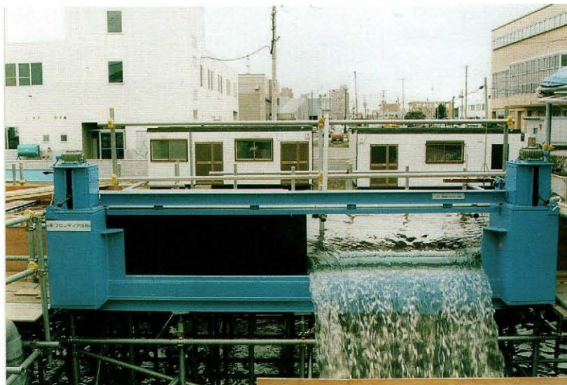
実験中の横引き型ロール式ゲート
