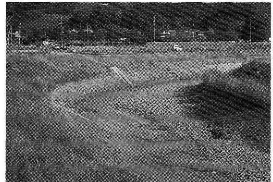
左岸側が平張り、右岸側が多段積み。
