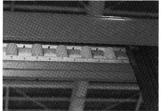
写真-7 上部水平ローラ
