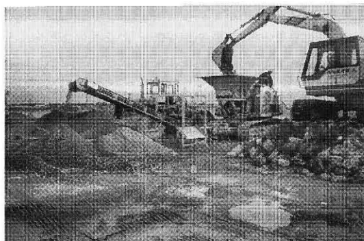
写真四 人頭大に砕いたコンクリート塊をガラパゴスに投入し、裏込め材として利用可能な粒土に砕く。
