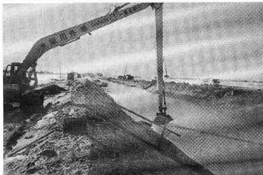
写真六 再生碎石を大型連節ブロックの裏込め材として再利用。
