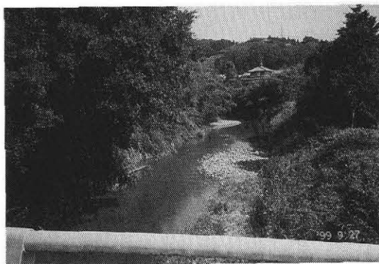
山崎橋から上流へ向って撮影。
