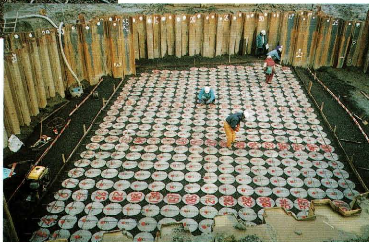
こま型ブロック設置状況
