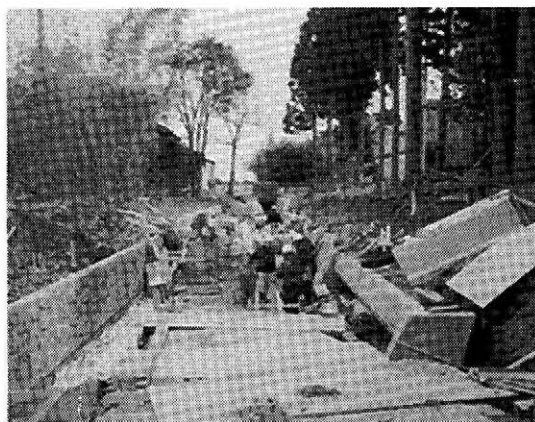
施工中の水路
