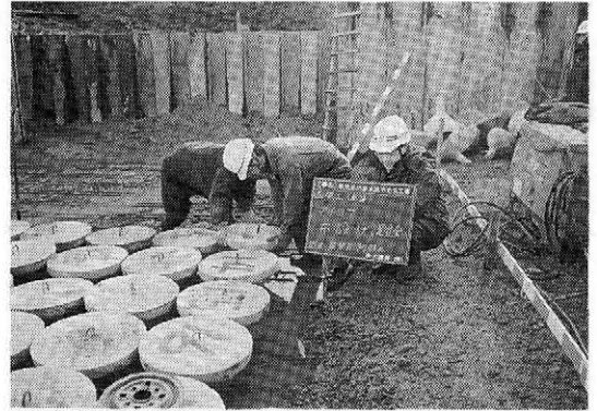
写真-2 こま型ブロック敷設状況
