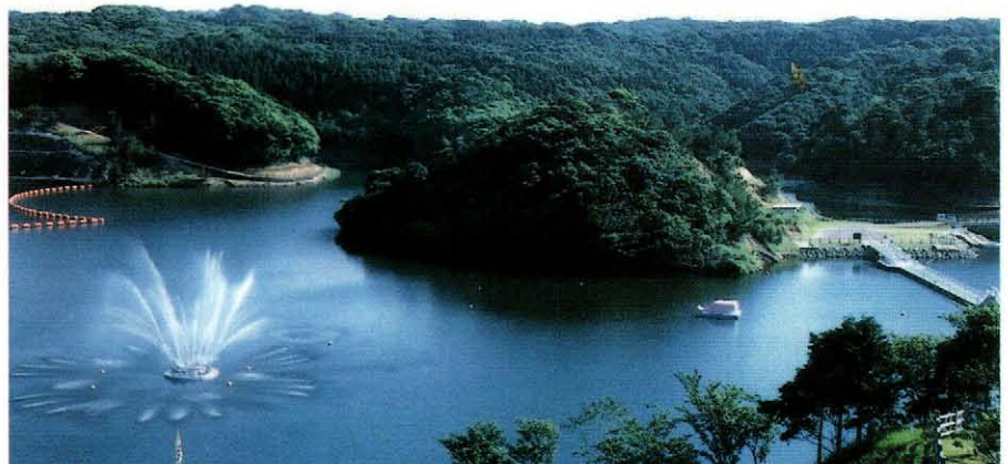
噴水バッキ施設稼働状況
